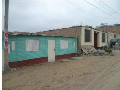
Figura 25. Viviendas de albañilería de un nivel con cobertura ligera.
