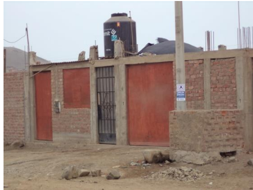
Figura 31. El material predominante es la mampostería de ladrillo.
