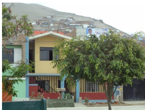
Figura 19. Edificaciones con techos aligerados, en buen estado de conservación.
