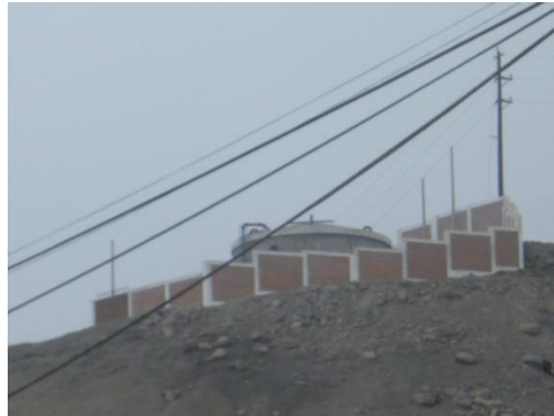
Figura 56. Tanque de agua.
