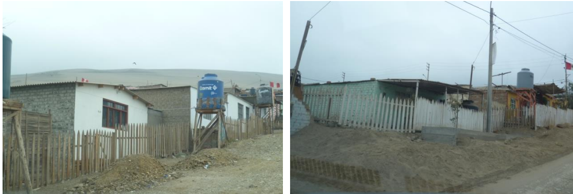
Figura 40. Viviendas de albañilería informal.
