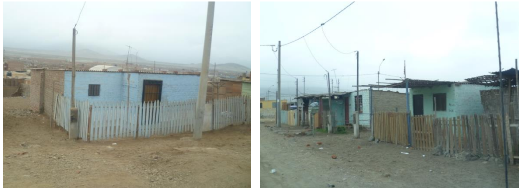
Figura 37. Viviendas típicas del Sector 08.
