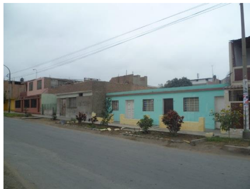
Figura 24. Vivienda de mampostería de un nivel del sector 05.
