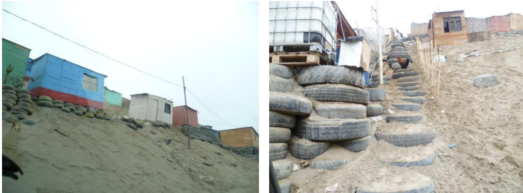
Figura 42. Uso de materiales reciclados para la base de las viviendas en las laderas.
