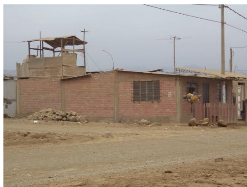
Figura 36. En menor porcentaje, edificaciones de mampostería con refuerzos.
