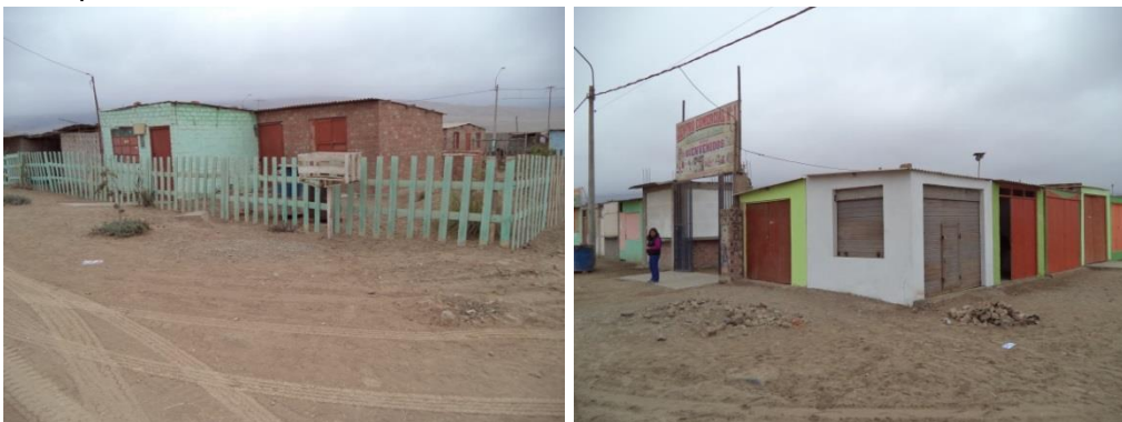
Figura 30. Tipos de edificaciones en el Sector 07. Predominan las edificaciones de un solo piso de uso residencial. En menor porcentaje existen edificaciones de uso comercial (derecha), que están aglutinadas en mercadillos.
