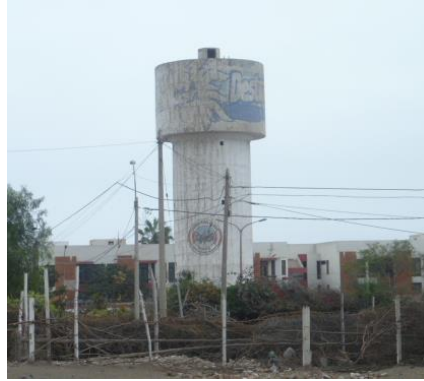
Figura 59. Reservorio elevado de concreto armado.
