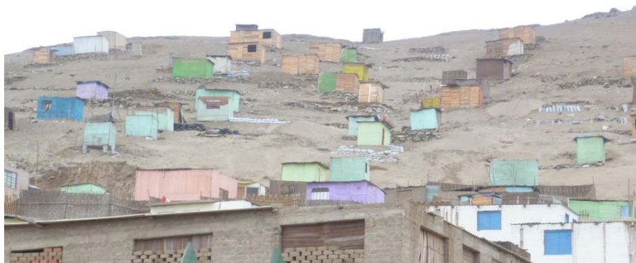
Figura 41. Vivienda de madera en las laderas de cerros.
