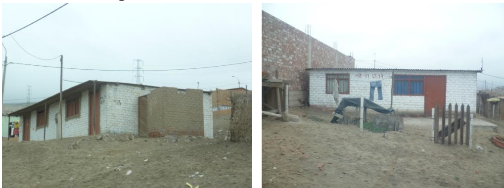
Figura 44. Viviendas de albañilería informal.
