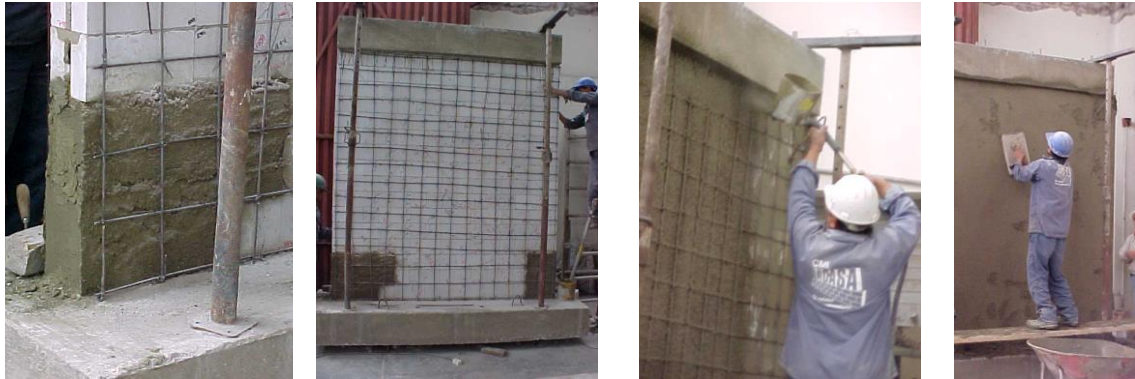
Figura 81. Detalle de refuerzo sobre las caras del muro.
