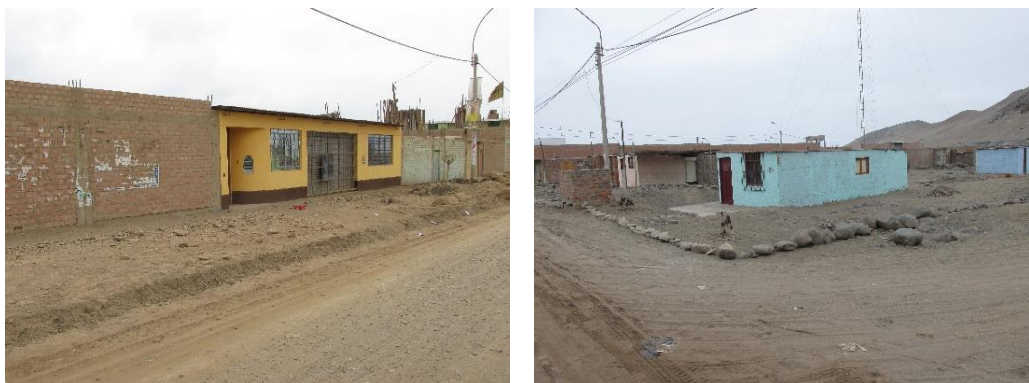
Figura 27. Edificaciones del sector 06, de un piso.
