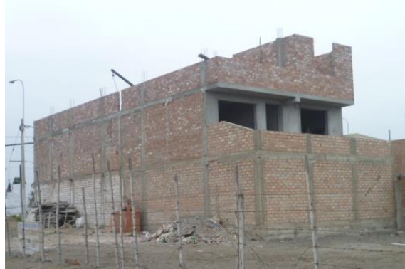
Figura 13. Vivienda de mampostería de 02 niveles del Sector 02.
