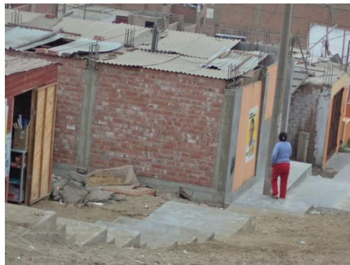
Figura 21. En mucho menor porcentaje existen edificaciones de mampostería con diafragmas flexibles.
