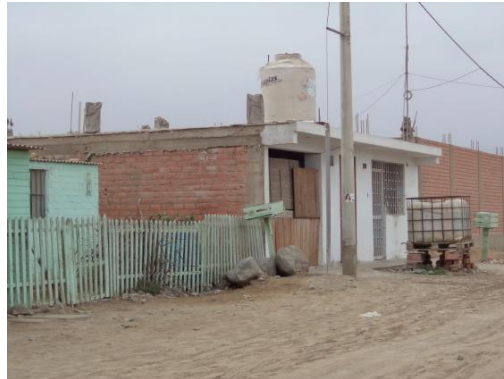
Figura 34. Edificaciones con techos aligerados, en buen estado de conservación.
