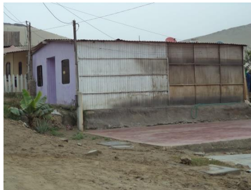
Figura 18. Los techos son predominantemente coberturas ligeras de calamina.
