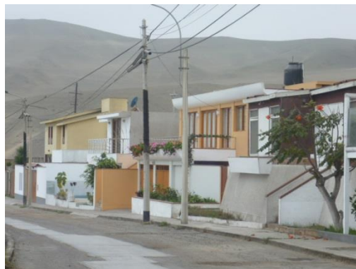
Figura 11. Viviendas de albañilería confinada.
