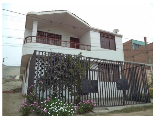
Figura 16. El material predominante es la mampostería de ladrillo.
