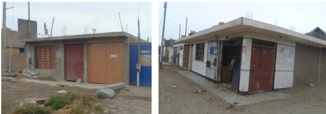
Figura 14. Viviendas de albañilería de un nivel con losa aligerada del sector.
