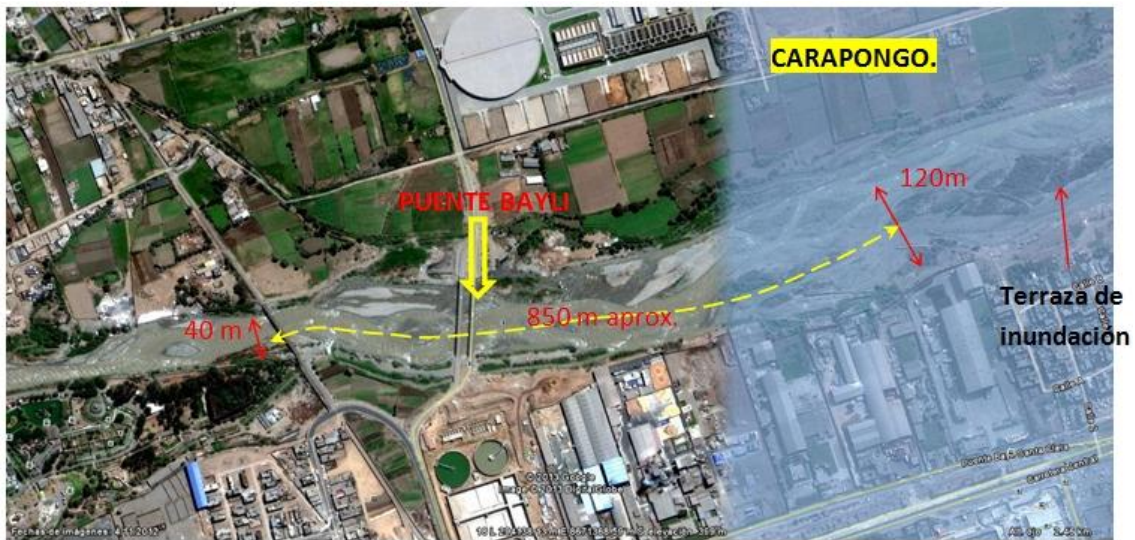
Figura 26: En la imagen se diferencian dos sectores, aguas arriba y aguas abajo del puente tipo Bayli. El primero presenta un cauce amplio; mientras que, el segundo el cauce es estrecho. Este último, por su morfología considerada a un área susceptible al desbordamiento del río.
