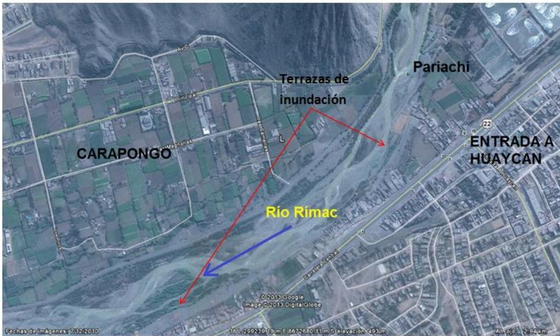
Figura 25: Obsérvese las terrazas de inundación conformadas por material fluvial redondeados, encontrándose desde arena gruesa hasta grandes bloques, lo cual indica el cambio del régimen del caudal del río. Margen izquierdo del río presenta alto peligro de inundación.
