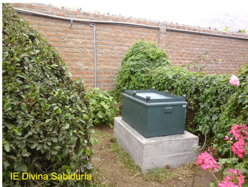
Figura 9: Estaciones acelerométricas instaladas en los locales del IE. 0051 José Faustino Sánchez Carrión y IE Divina Sabiduría de Carapongo
