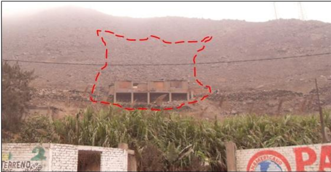
Figura 19: La línea segmentada de color rojo muestran caídas de rocas en el extremo noreste del frontis de la planta de Sedapal
