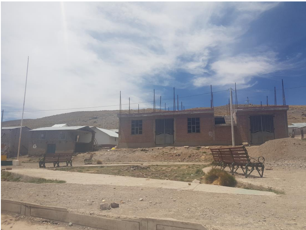
Foto 07: Construcción de un piso de material noble que no sufrió daños por efecto del sismo, nótese la vivienda de adobe con los muros colapsados.
