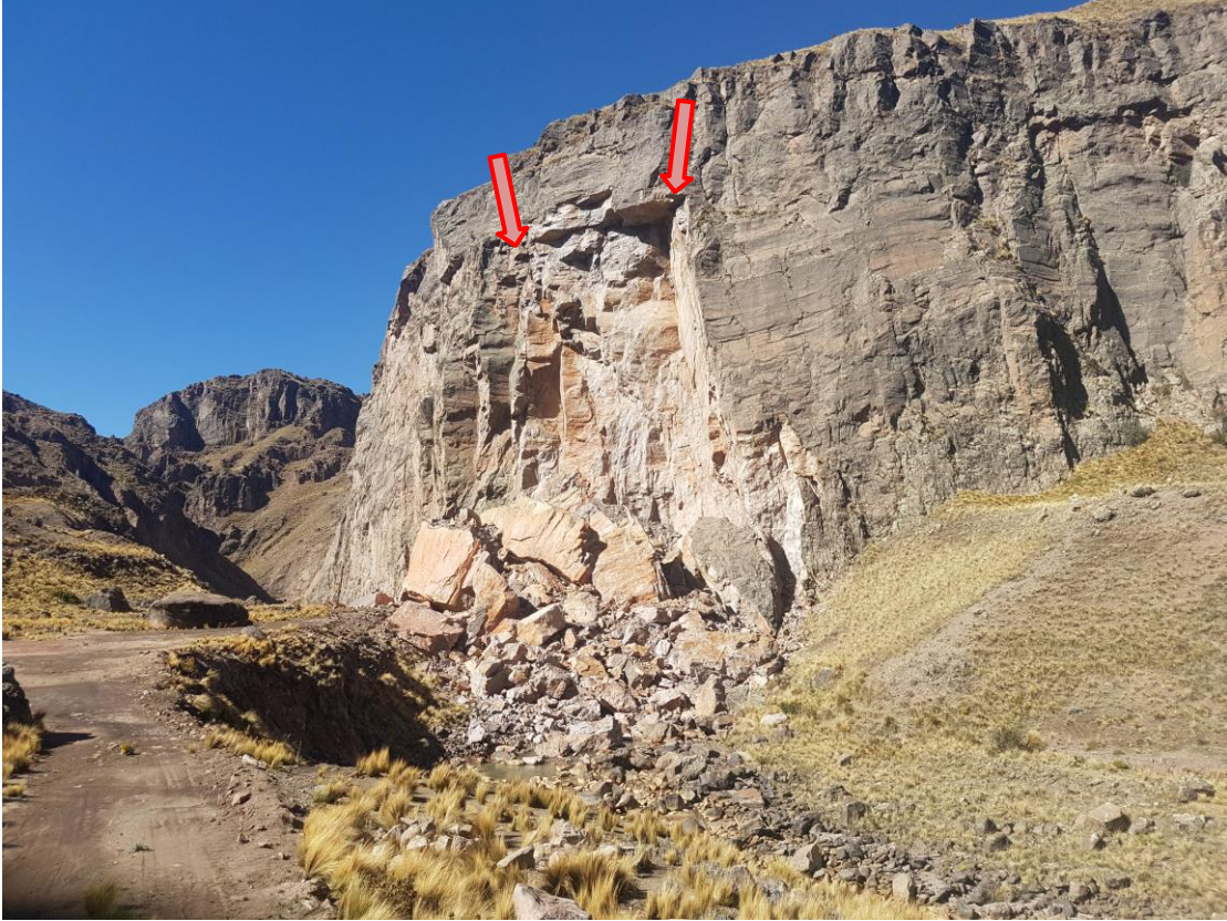
Foto 01: Derrumbe (Caída de rocas) represando el río Jatun Ayllu, las flechas rojas indican la zona de desprendimiento o arranque.
