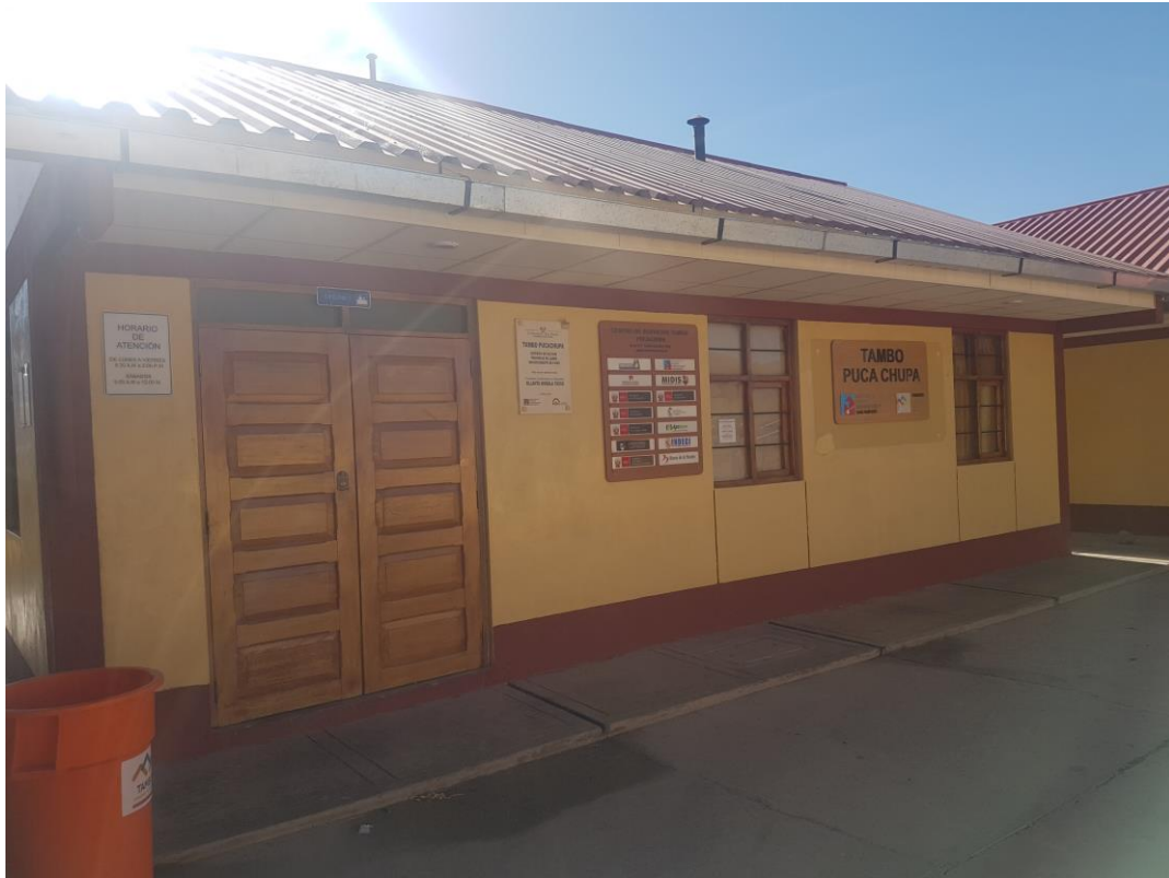
Foto 08: Vivienda de un piso de material noble, las paredes y ventanas no sufrieron daño.
