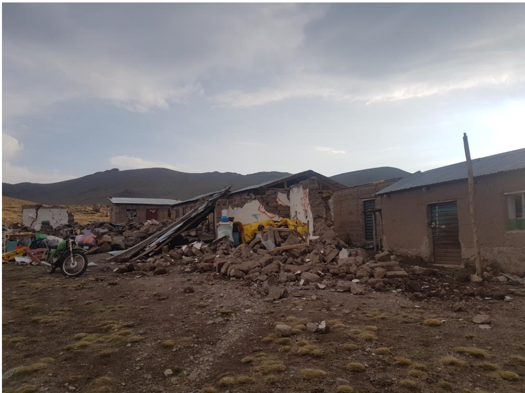
Foto 06: Vivienda colapsada por efecto de la amplificación de ondas sísmicas, el suelo y el tipo de construcción.
