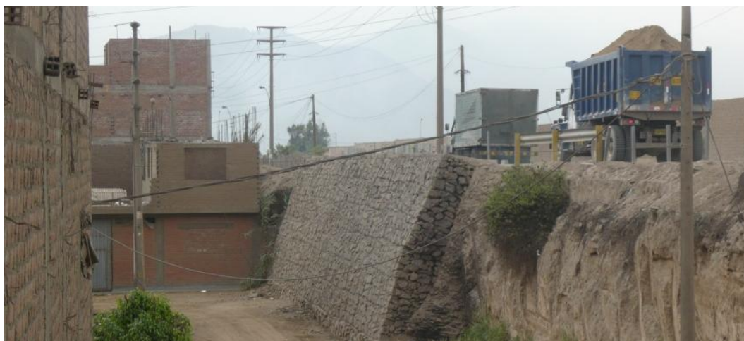
FOTOGRAFIA 50: VÍA COLECTORA A LA ALTURA DEL AA.HH. LAS BRISAS DEL PARAÍSO
