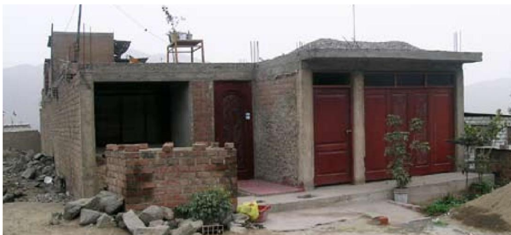
FOTOGRAFIA 46: CONSTRUCCIONES DE LADRILLO
