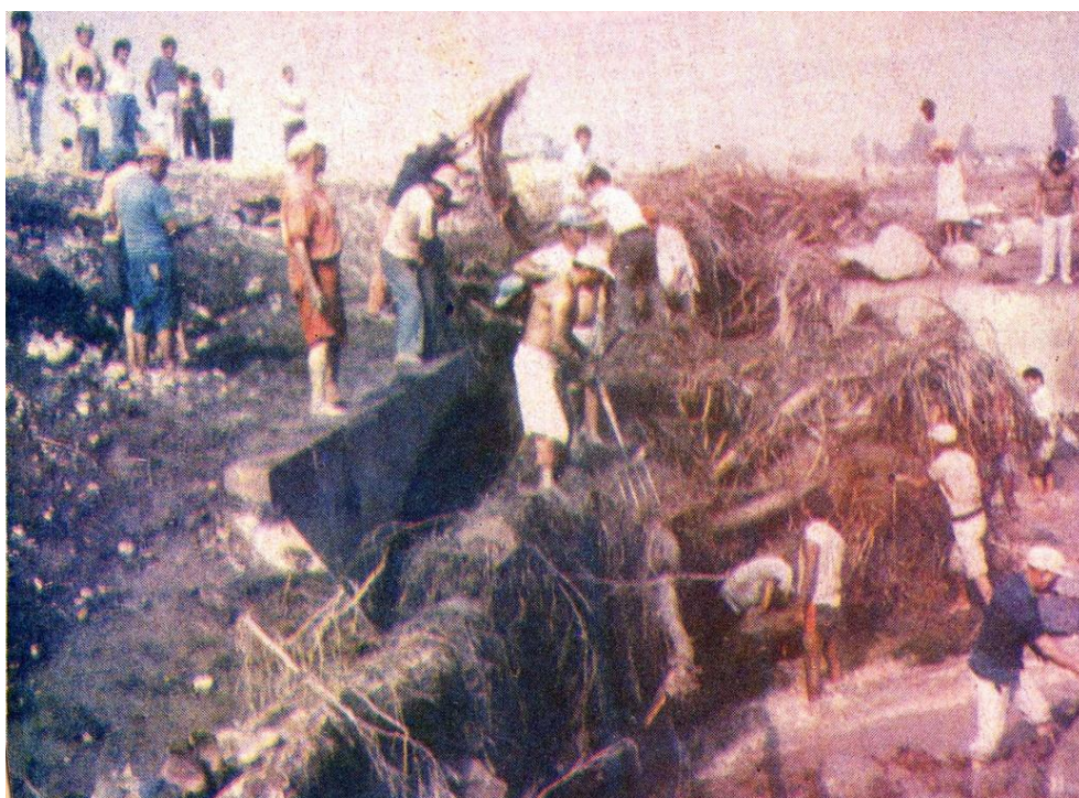
FOTOGRAFIA 36: OBSTRUCCIÓN EN EL PUENTE CAMPOY, 10 DE MARZO DE 1987
