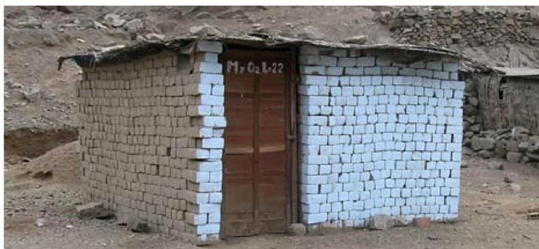
FOTOGRAFIA 47: CONSTRUCCIONES DE ADOBE
