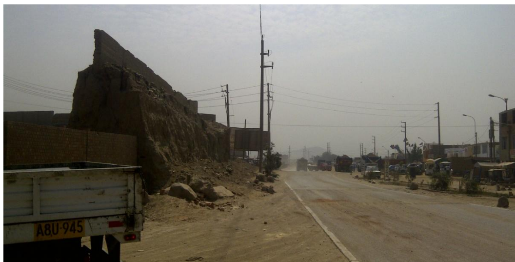
FOTOGRAFÍA 15: AVENIDA LA TORRES, A LA ALTURA DE LOS GERANIOS DE HUACHIPA
