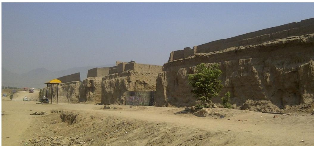
FOTOGRAFIA 49: VÍA LAS TORRES, A LA ALTURA LOS GERANIOS DE HUACHIPA
