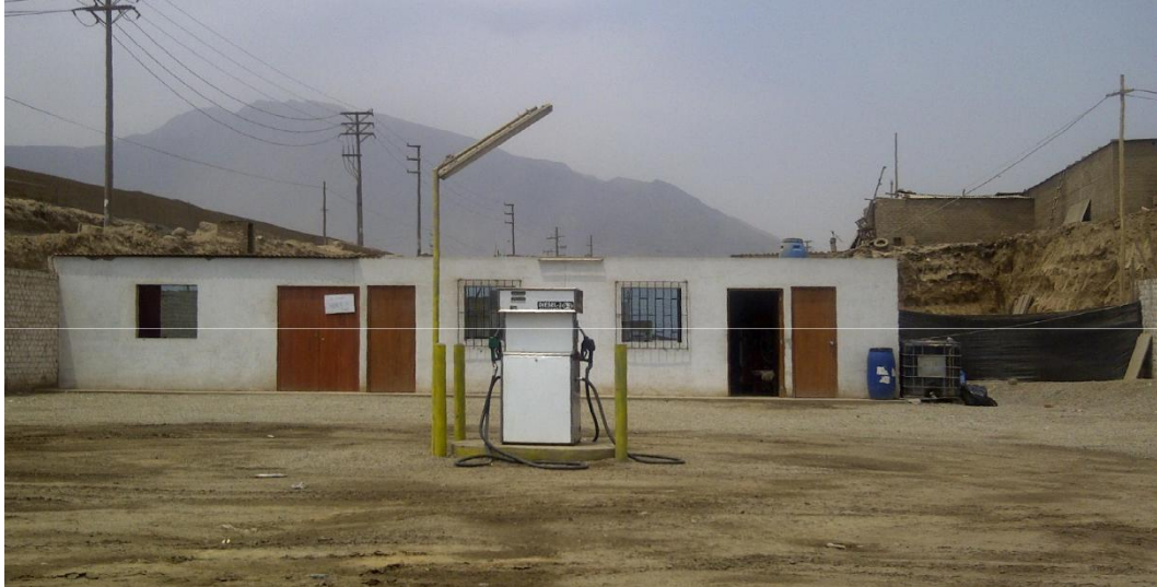
FOTOGRAFÍA 28: GRIFO CLANDESTINO EN LA AVENIDA LAS TORRES
