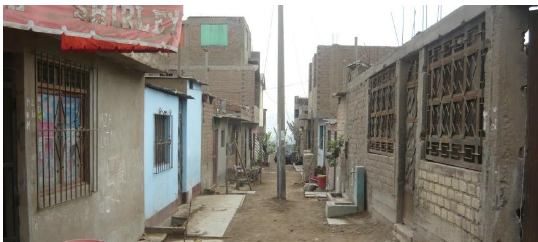
FOTOGRAFIA 45: CONSTRUCCIÓN EN LA ASOCIACIÓN VECINAL LA HUERTA.
