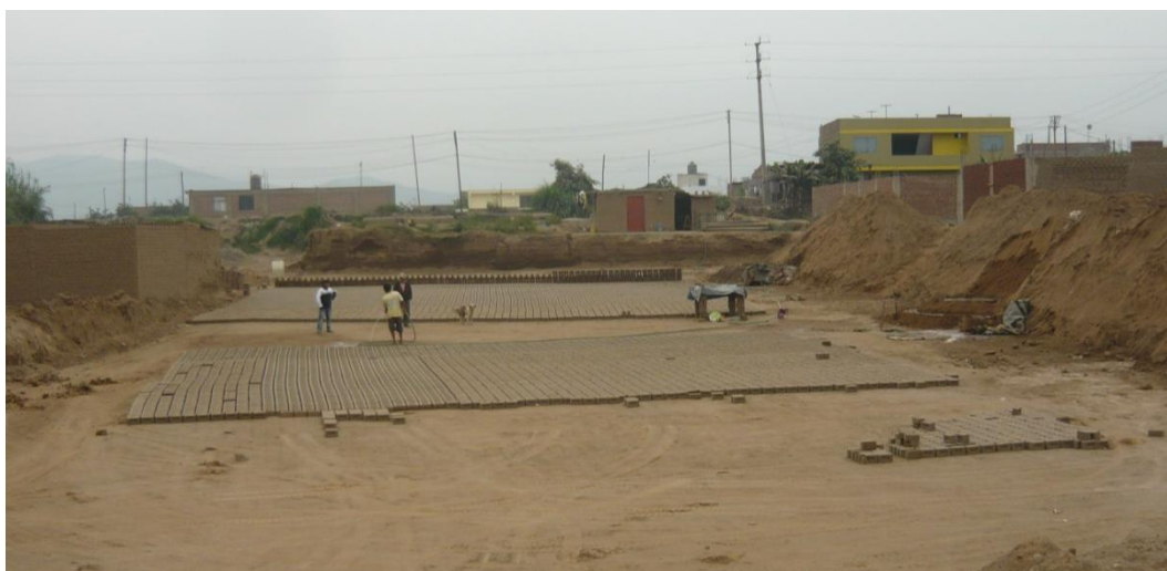
FOTOGRAFÍA 03: POBLADORES TRABAJANDO EN LA ELABORACIÓN DE LADRILLOS
