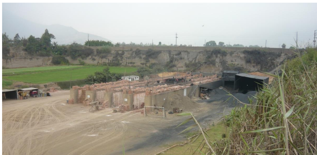
FOTOGRAFIA 53: FABRICA SEMI INDUSTRIAL DE LADRILLOS, UBIADA EN HUACHIPA
