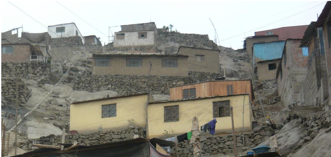
FOTOGRAFIA 31: CONSTRUCCIONES SOBRE PIRCAS SIN CONGLOMERANTES.
