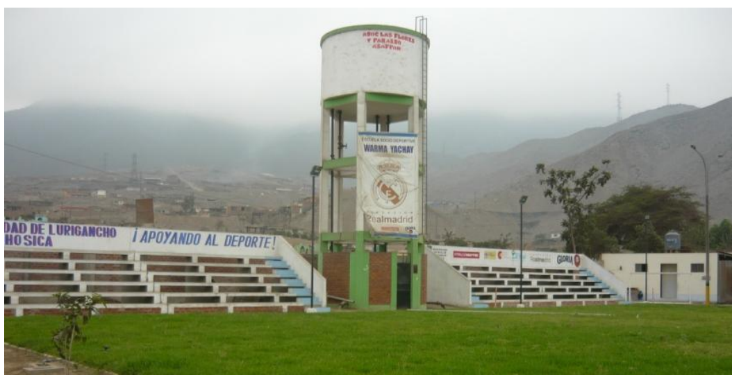
FOTOGRAFÍA 12: MINI ESTADIO DE NIEVERÍA, UBICADO EN LA ASOCIACIÓN VECINAL DE NUEVO PARAÍSO.
