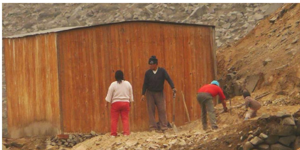
FOTOGRAFÍA 04: POBLADORES TRABAJANDO EN LA CONSTRUCCIÓN DE PIRCA PARA VIVIENDA
