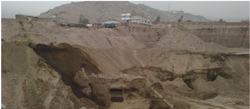
FOTOGRAFIA 32: CANTERA DE AGREGADOS; REPRESENTACIÓN DE INESTABILIDAD DE TALUD.
