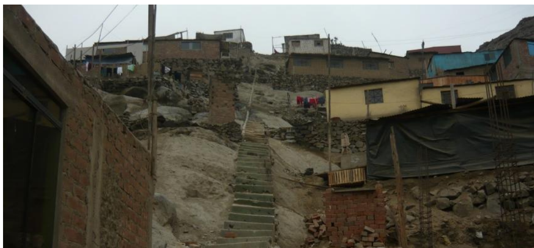
FOTOGRAFIA 51: VÍA PEATONAL en el AA.HH. RINCONCITO SAN ANTONIO.
