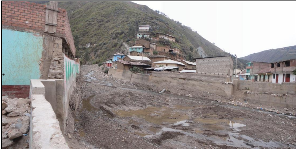
Foto 12.- Canalización de la quebrada Batán, que muestra el estrechamiento del su canal.
