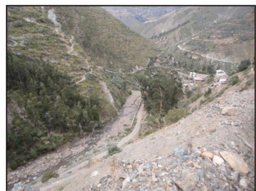
Cauce de la quebrada Batán colmatado.
