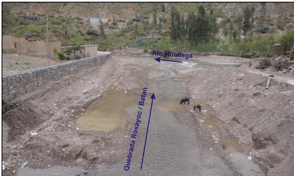
Foto 6.- Encauzamiento de la quebrada Rosayoc/Batán.
