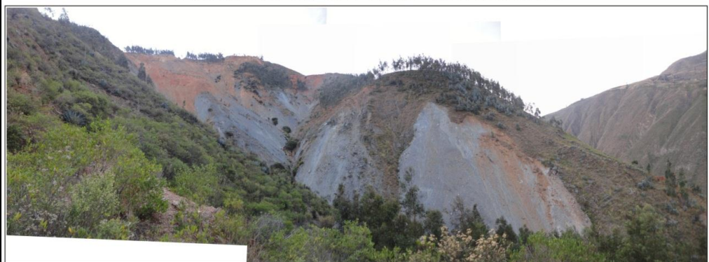
(A) Deslizamiento del sector de Cashayo
