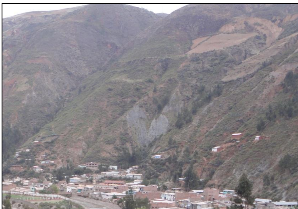
Foto 17.- Sector de San Rafael, en la ladera del cerro se muestran erosiones de ladera, que han generado depósitos de talus de detritos.
