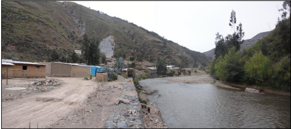
Foto 7.- Sector Barrio Mollepata, protegido con defensa ribereña, el río Huallaga en la margen derecha se está formando una playa de gravas.
