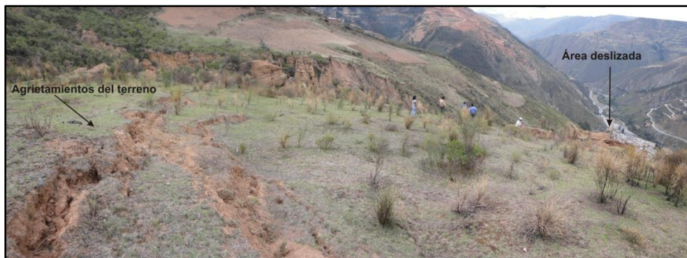
Fotos 21 y 22.- Agrietamientos del terreno ubicados en la parte posterior del deslizamiento reciente.
