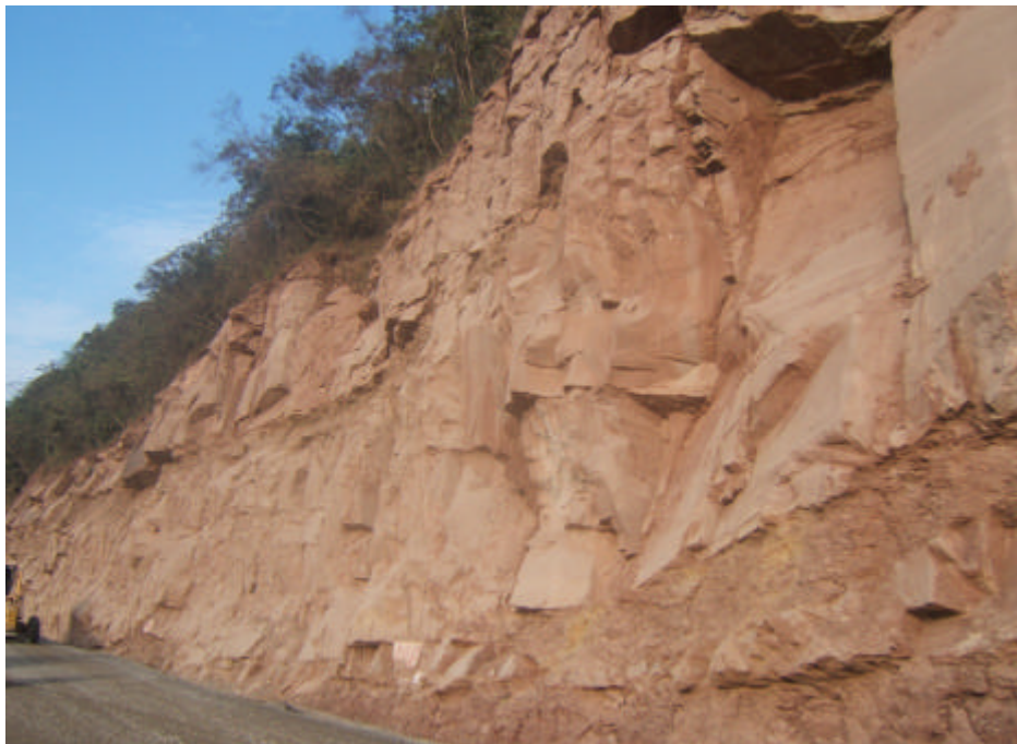
Foto 6.8 Caída de rocas, carretera Tarapoto-Juanjuí, km 30+740 (distrito Buenos Aires, provincia Picota).
