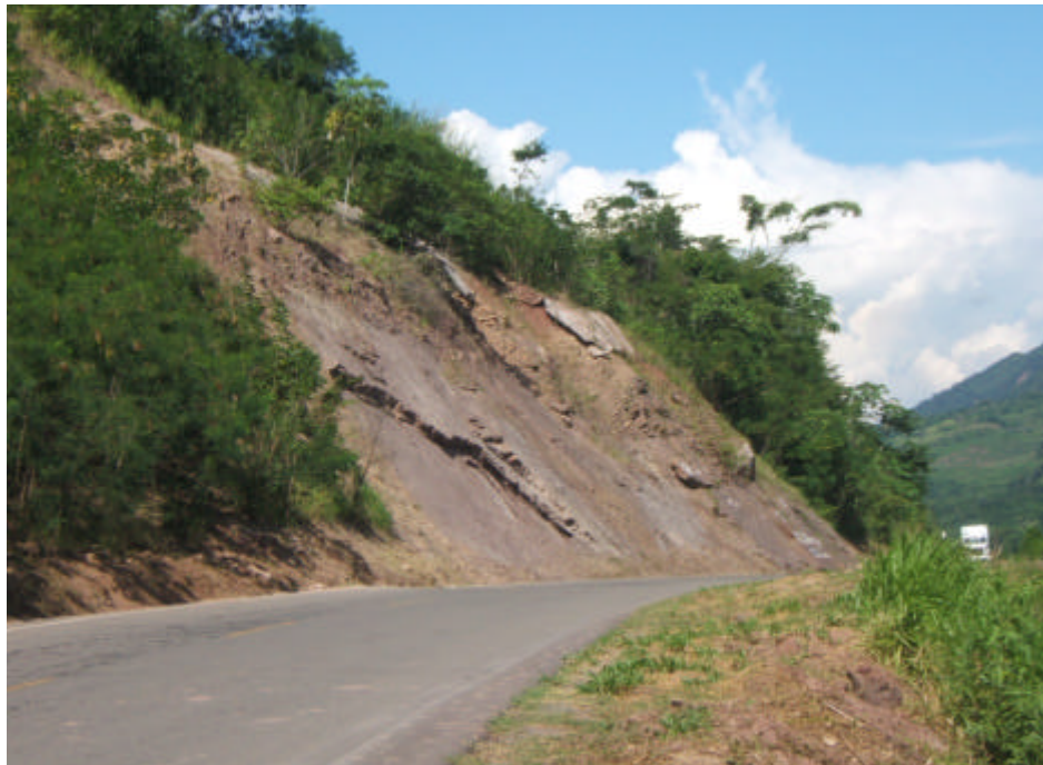
Foto 6.4 Deslizamiento traslacional frente a San Miguel, carretera Moyobamba-Tarapoto, (distrito y provincia de Lamas).
