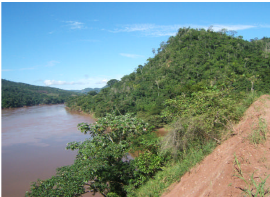
Foto 6.20 Sector Mirador de Chumia. Erosión fluvial por la margen izquierda del río Huallaga.
