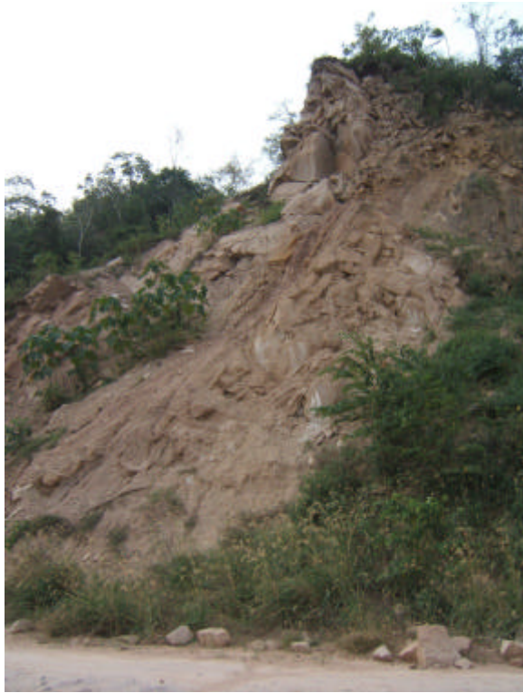
Foto 6.7 Derrumbes en la carretera Tarapoto-Juanjuí, (distrito Buenos Aires, provincia Picota).
