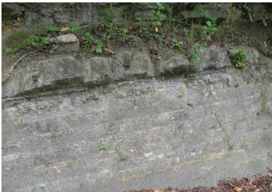
Foto 3.5 Afloramiento rocoso de la Formación Chonta compuesto por estratos de calizas arenosas intercaladas con limolitas. Sector San Pedro de Cumbaza. Provincia de San Martín, distrito San Antonio.
