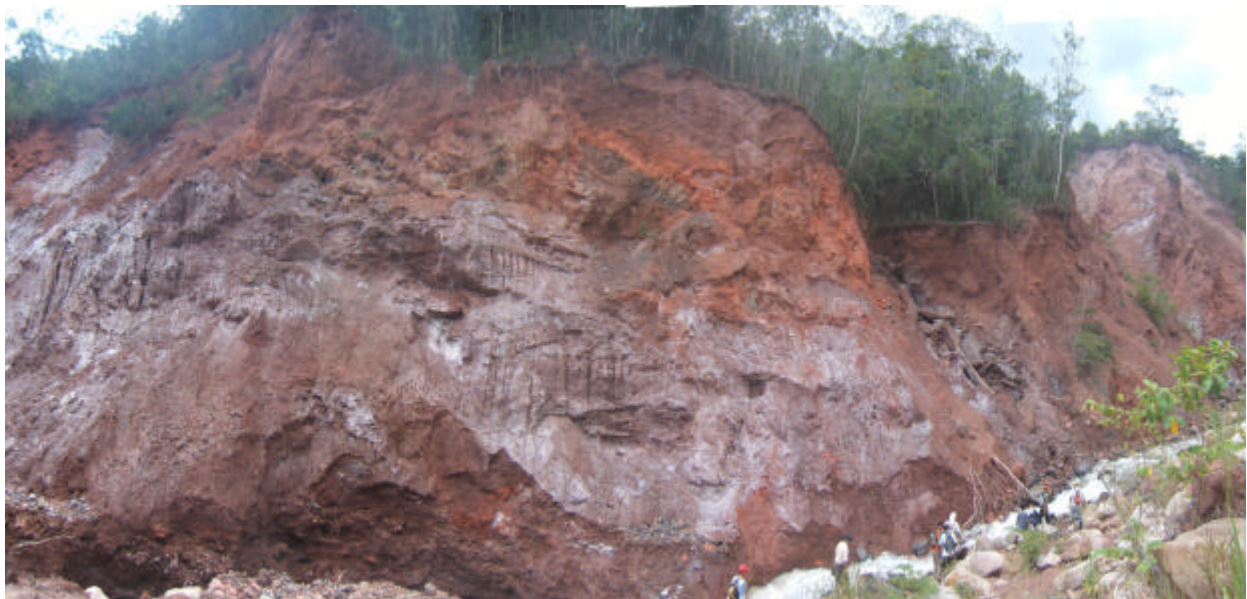
Foto 3.14 a, b Domo de sal, constituido por yeso y anhidrita conjuntamente con limolitas y lodolitas rojizas y fragmentada. Susceptible a la ocurrencia de derrumbes. Provincia de Picota, distrito de Pilluana.
