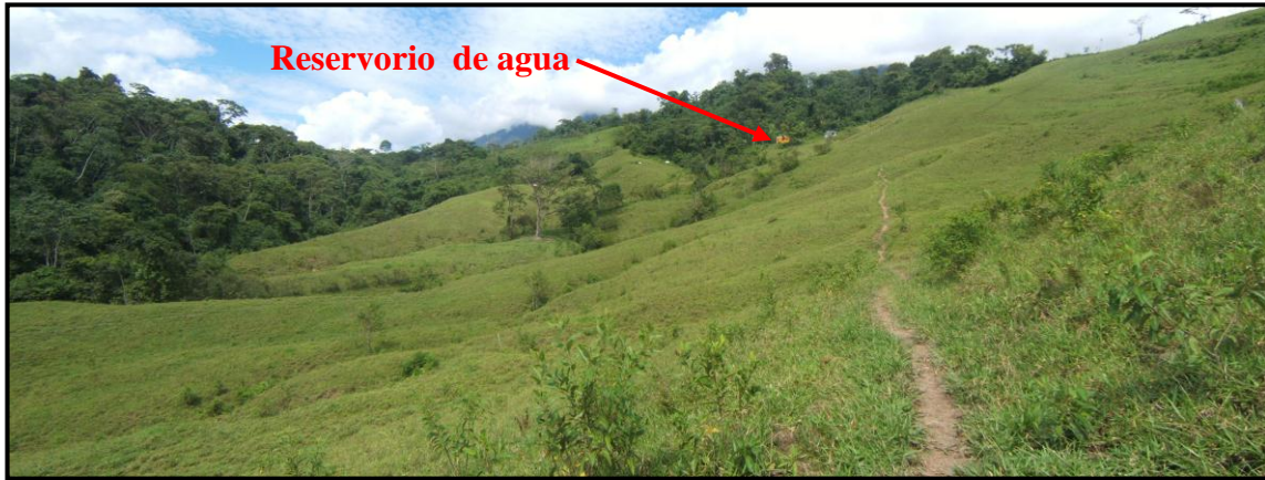
Foto 1.-Vista de un sector del deslizamiento y el tanque de agua, se aprecia la intensa deforestación, hay presencia de erosiones en cárcavas en el cuerpo del deslizamiento.
