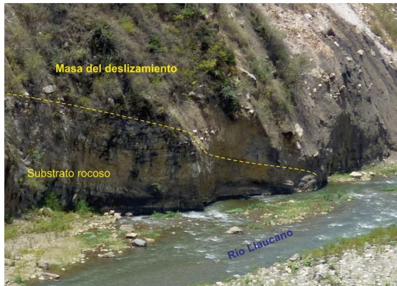
Foto 7. Afloramiento y masa del deslizamiento.
