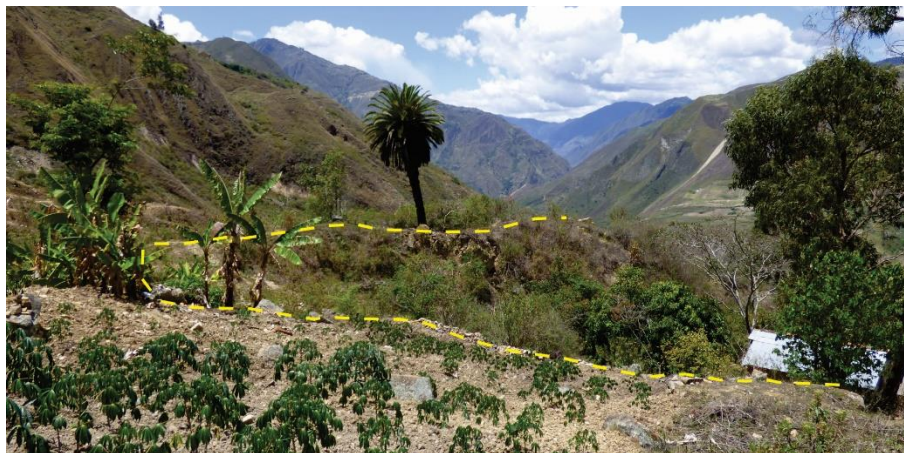
Foto 9. Sector donde se ubicaron viviendas del sector La Pampa-Huangamarquilla. Se aprecia parte de escarpa secundaria (línea amarilla), y palmera inclinada (basculada en dirección opuesta al movimiento).
