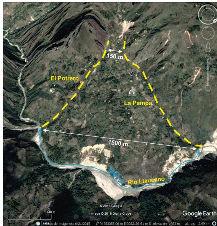
Figura 9. Cuerpo del deslizamiento antiguo en forma cónica (línea amarilla).
