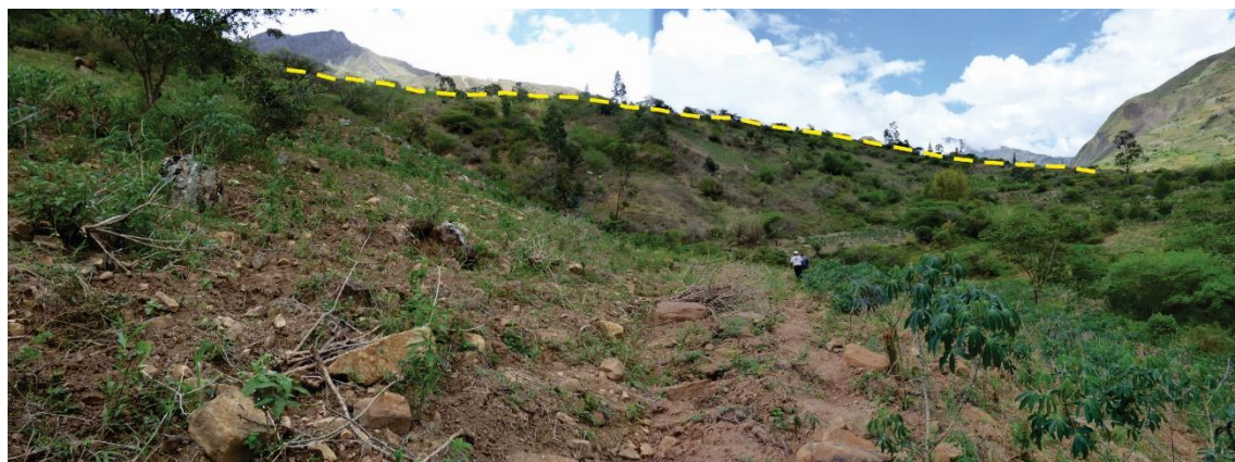
Foto 12. Parte de la escarpa del área reactivada (A), demarcada con línea amarilla.
