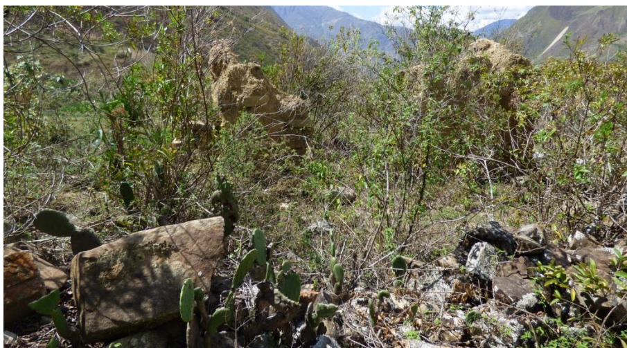
Foto 2. Material proveniente del deslizamiento (depósitos coluvio-deluviales)
