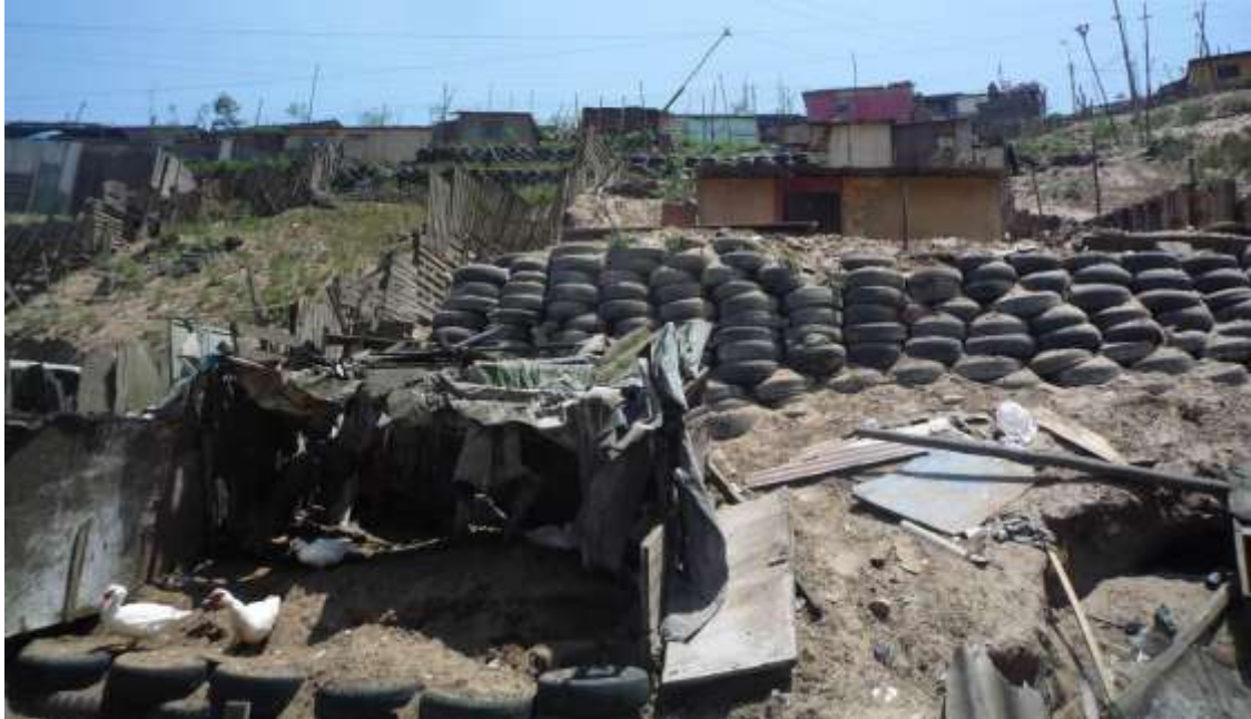
Foto 12. AH ADV Talleres artesanales. Obsérvese bases de muros de llantas sobre la que se ha levantado una vivienda de madera y calamina.
