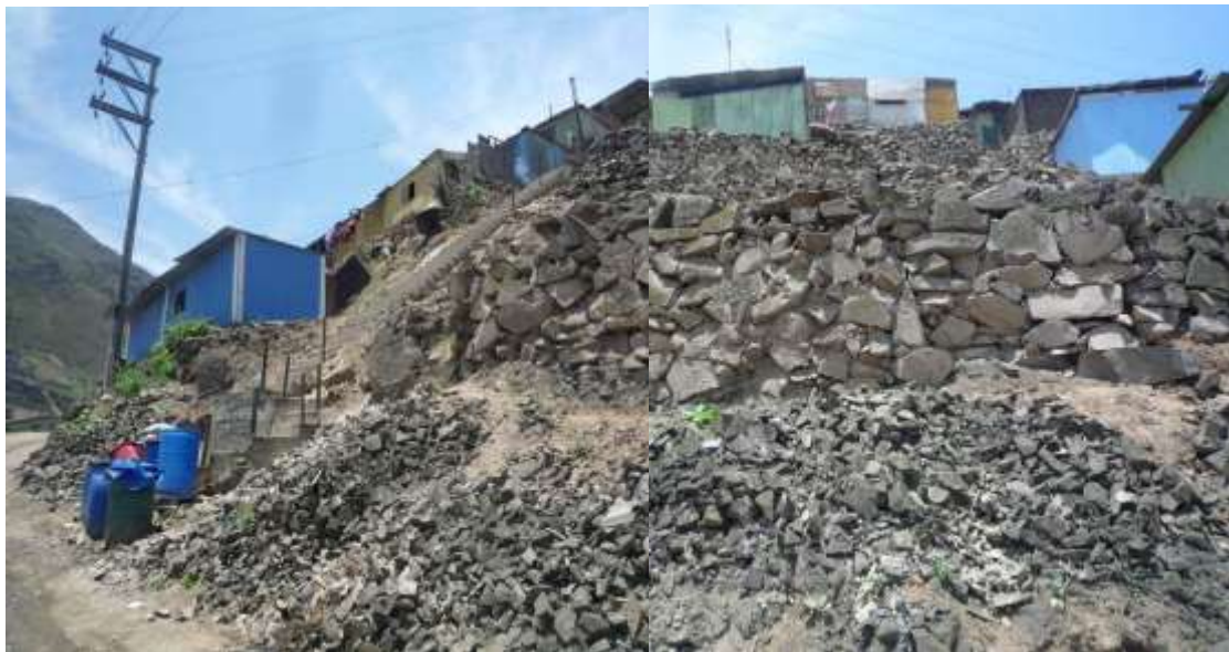
Foto 13. AH. La Planicie. Acumulaciones de rocas, formando pircas sin consolidación sobre la cual se construyen las viviendas
