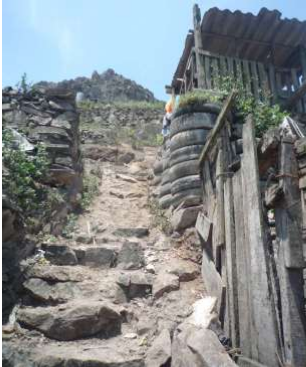
Foto 14. Escalera de acceso en el AH bajo las rocas de rocas superpuestas. Obsérvese bases de muros de llantas.
