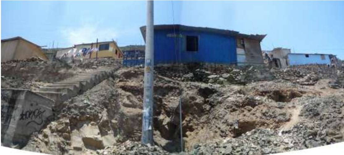
Foto 3. AH Halcón sagrado. Vista de roca intrusiva meteorizada cubierta por depósitos coluviales.
