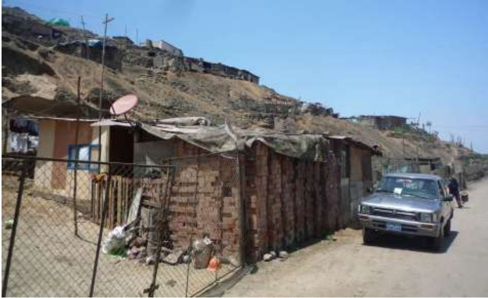
Foto 8. Sector susceptible a hundimiento en el A.H. ADV Talleres Artesanales. Para ubicar las viviendas se ha empleado material de relleno para “nivelar” el terreno.
