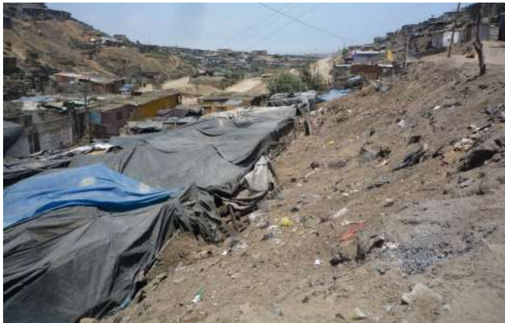
Foto 5. Obsérvese la fuerte pendiente (45°) en una ladera susceptible a derrumbe. AH. ADV talleres artesanales.
