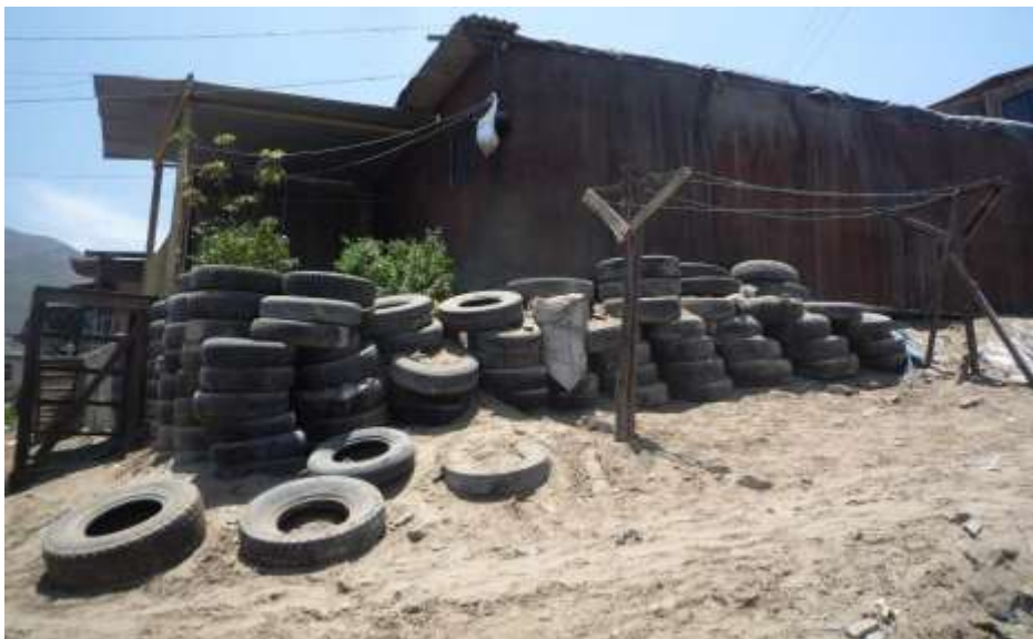
Foto 9. Obsérvese los muros de llantas para “controlar” el avance de las arenas. AH 08 de Enero - Sector A.
