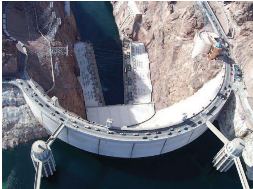
Figura 2-4: Presa Hoover ubicada en el cauce del río Colorado entre los estados de Arizona y Nevada es de tipo arco-gravedad.
