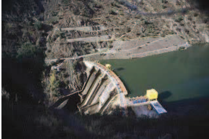
Figura 2-3: Presa Tablachaca ubicada en la provincia de Tayacaja, departamento de Huancavelica. Es de tipo Arco-gravedad de concreto armado.
