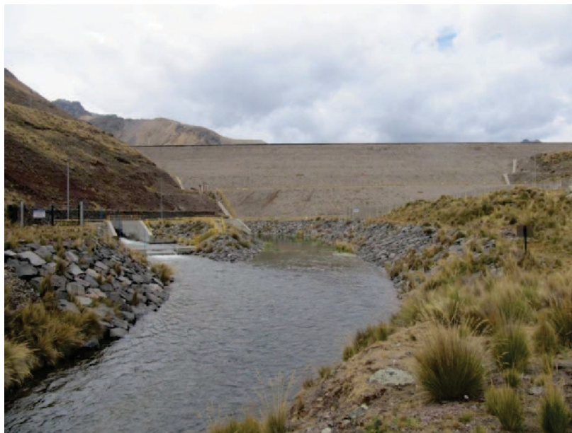
Figura 2-2: Presa Yuracmayo ubicada en la provincia de Huarochiri, departamento de Lima. La presa es de tipo de tierra zonificada
