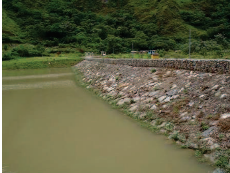
Figura 2-1: Presa Chimay ubicada en la provincia de Jauja, departamento de Junin. Está compuesta por un tramo de Concreto (62 m) y otro de tierra zonificada (115 m)
