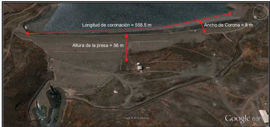
Figura 4-3: Presa de Yuracmayo
