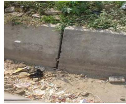
**Falta reposición de juntas asfálticas**
