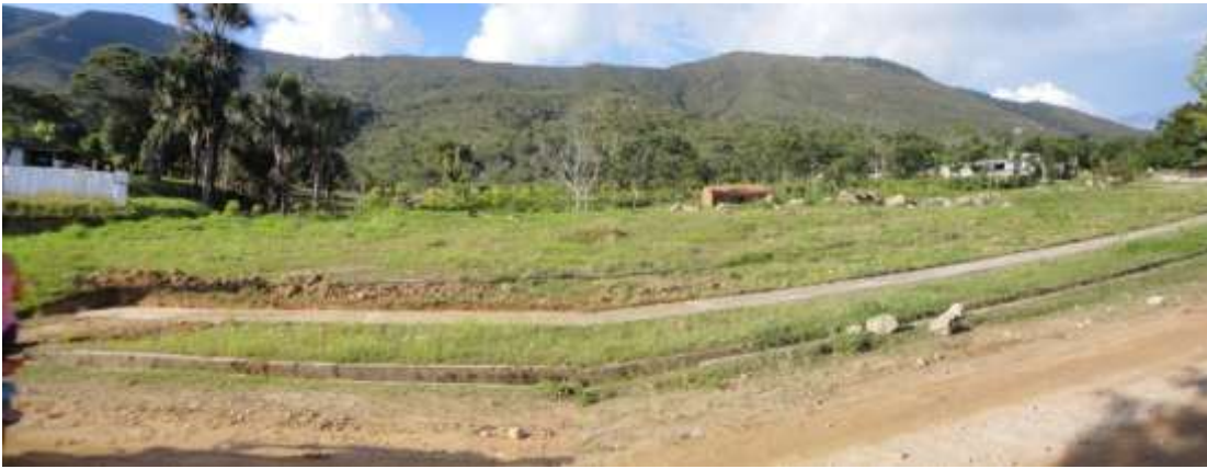
Foto 8. El material transportado por el flujo de detritos de la quebrada Yacaré llegó hasta sector donde había un grifo y viviendas.
