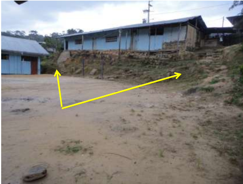
Foto 18. Se muestra el corte de talud, para la construcción de la cancha de fútbol.
