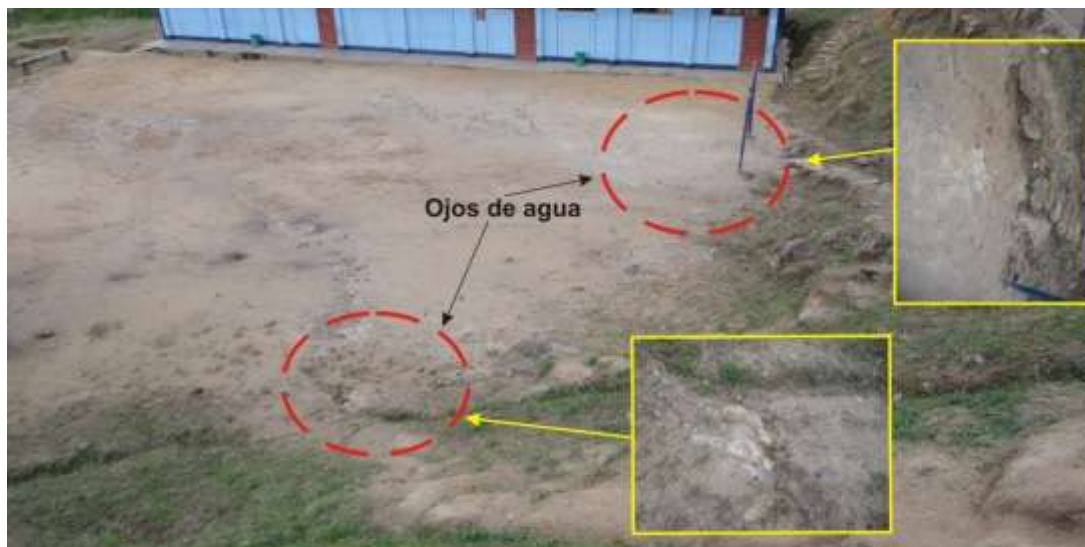
Foto 17. Filtraciones de agua en el colegio de Carrizales.
