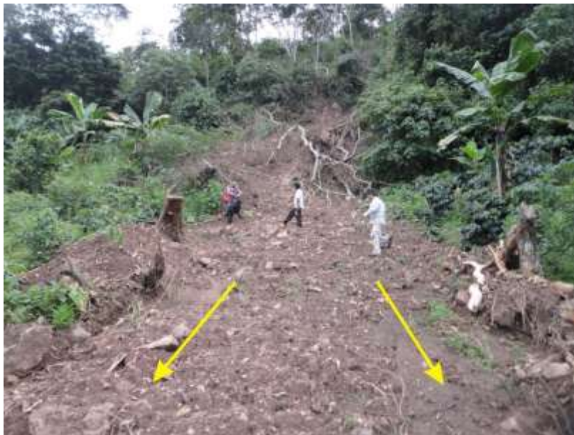
Foto 23. Derrumbe-flujo en las inmediaciones del C.E. Juan Velasco Alvarado
