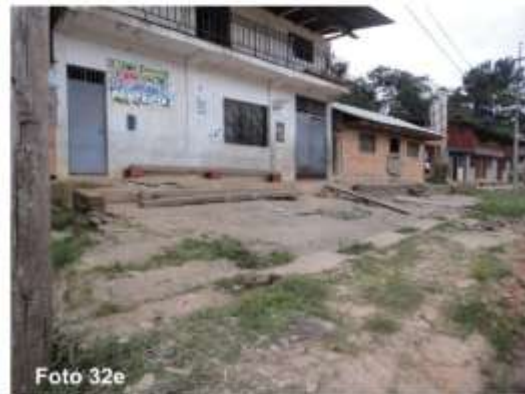
Fotos 32a, 32b, 32c, 32d y 32e. Paredes y pisos agrietados en las viviendas afectadas por el segundo deslizamiento en el poblado de Pacaypite.
