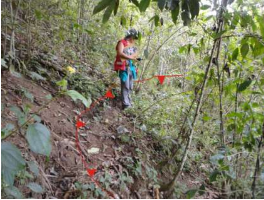
Foto 30. Escarpa de inicio de deslizamiento de Pacaypite.
