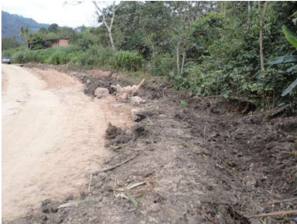
Foto 27. Sector de la carretera reconstruido, donde empieza el flujo de tierra.
