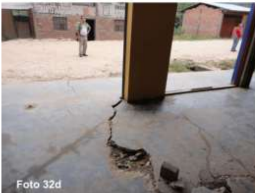
Fotos 32a, 32b, 32c, 32d y 32e. Paredes y pisos agrietados en las viviendas afectadas por el segundo deslizamiento en el poblado de Pacaypite.
