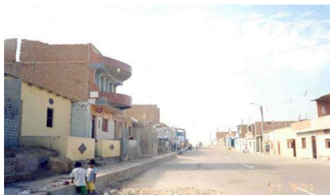
Las nuevas edificaciones carecen de sistema de drenaje.
