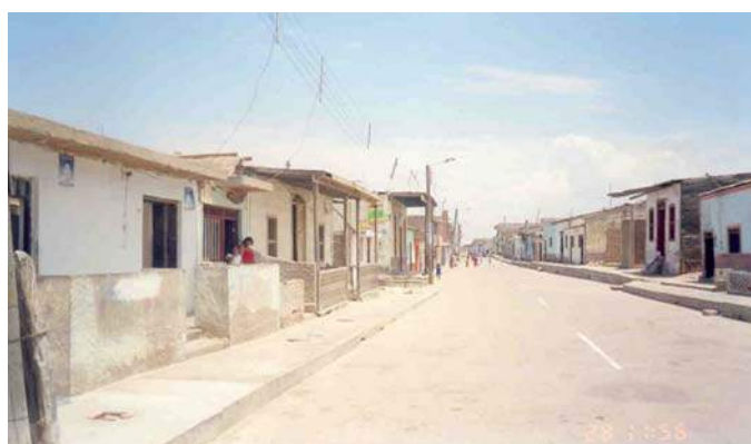
Deben formarse las medidas necesarias para evitar afectaciones por inundación.
