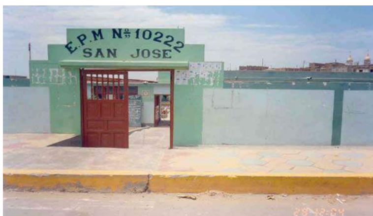
Colegio E.P.M. N° 10222 San José, vulnerable principalmente ante fenómenos de origen climático.
