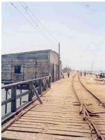
Vista del entramado de madera y barandas del Muelle Pimentel en muy mal estado.
