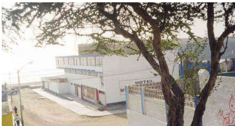
La Estación de Bomberos se encuentra en una zona amenazada por fuertes oleajes.
