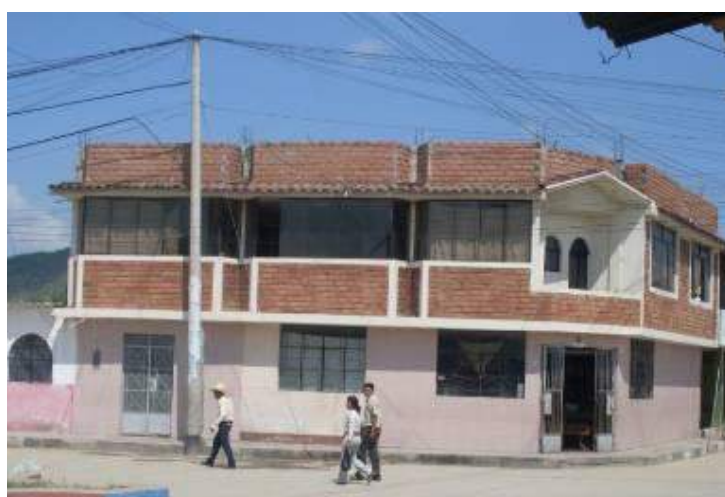
Figura 10.32.- Confinamiento de parapetos dentro del sistema resistente.
