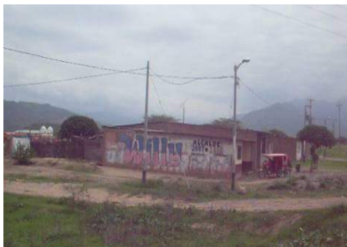
Figura 10.35.- Asentamiento Humano Alan García sus edificaciones la mayoría son de adobe y muestran de regular a buen estado de conservación.
