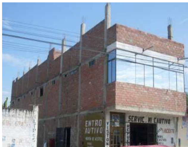
Figura 10.12.- Unidades de albañilería industrial de buena calidad.
