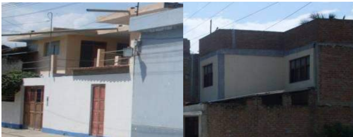
Figura 10.20.- Irregularidad en planta, problema de torsión.
