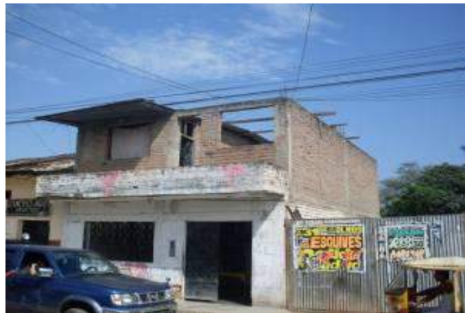
Figura 10.6.- Edificaciones de albañilería.
