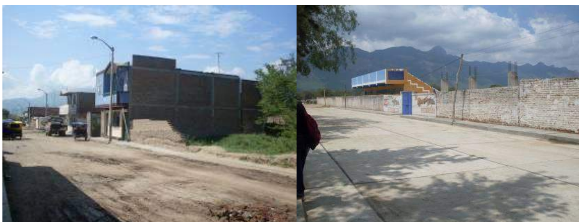
Figura 6.12.- izquierda Edificación de 2 pisos con un gran peso por la gran longitud en la dirección perpendicular a la fachada. La dirección paralela a la fachada es crítica por insuficiente densidad de muros. Derecha cerco perimétrico del Estadio de albañilería simple que no ofrece resistencia ante un sismo.
