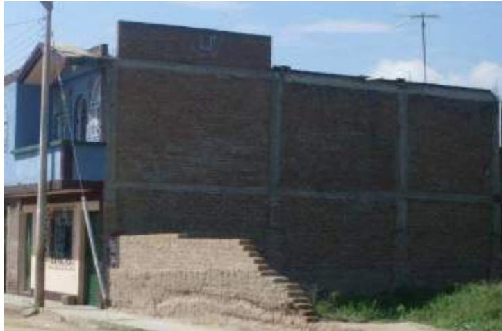
Figura 10.9.- Edificio de albañilería, puede notarse el vaciado de columnas y vigas posterior
