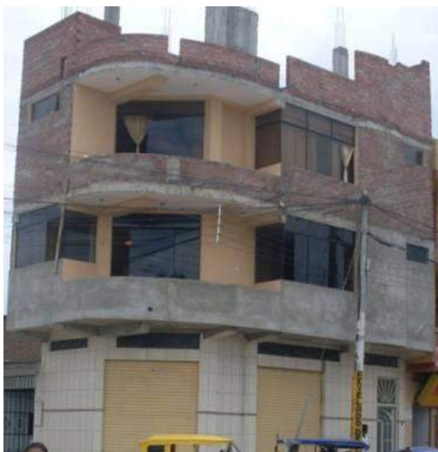
Figura 10.30.- Mampostería fuera del sistema resistente sin confinamiento.
