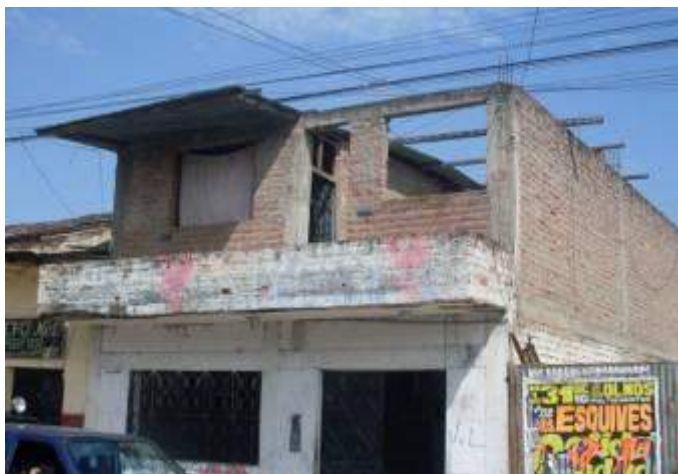
Figura 10.13.- Mala calidad de los elementos que forman el sistema resistente.
