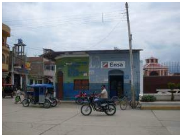
Figura 10.11.- Construcción de adobe de un piso – local ENSA. (Calle Grau)
