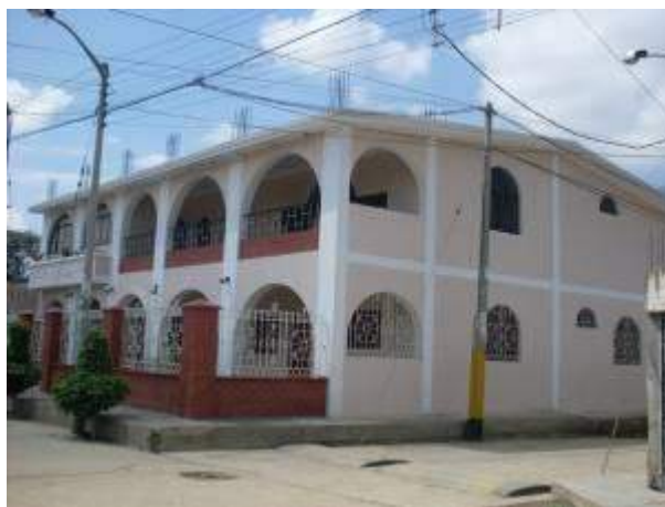
Figura 10.7.- Edificaciones de concreto armado, identificadas por la separación entre columnas y vigas, de los tabiques.
