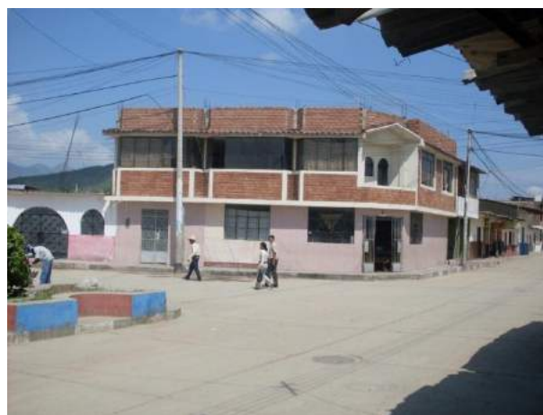
Foto N° 03.- Calle Santo Domingo y Tarata
