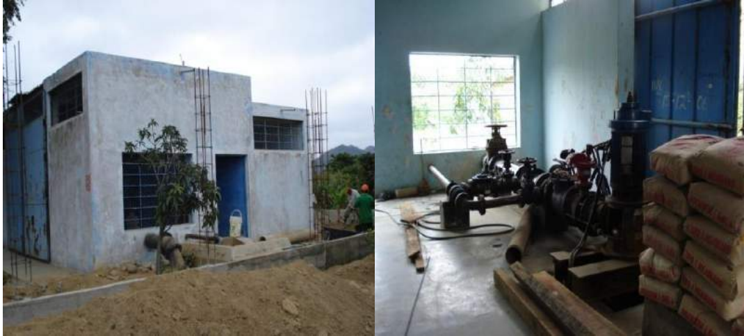
Foto N° 11.- Caseta de la Poza N° 02 y su bomba de impulsión
