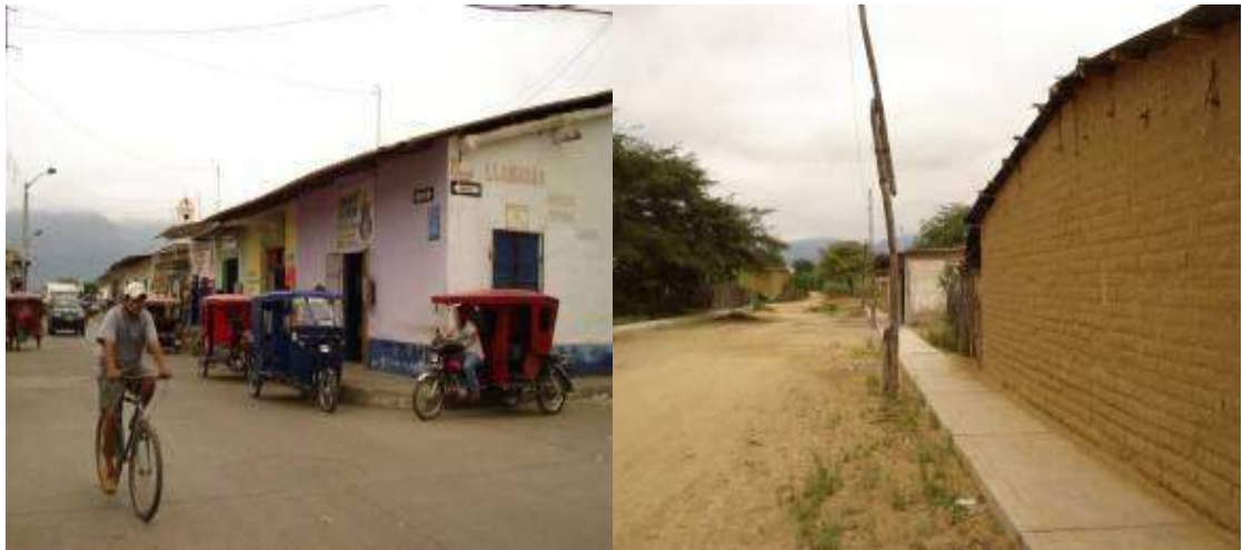
Figura 10.5.- Gran porcentaje de construcciones de adobe en el centro ciudad de olmos y alrededores. Esq. de Ca. Leguía y Tarata, y Ca. San Jorge
