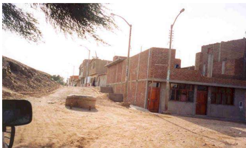
Vista de ejes viales no pavimentados en el A.H. Santa Rosa.
