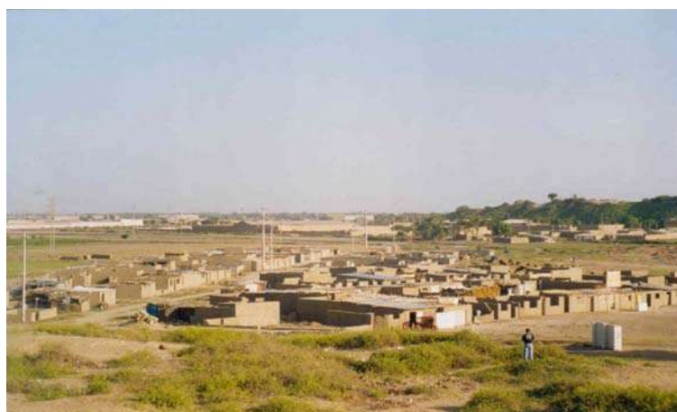
Vista de el área de expansión urbana colindante a los asentamientos La Alameda y César Vallejo y Prolongación Los Angeles.
