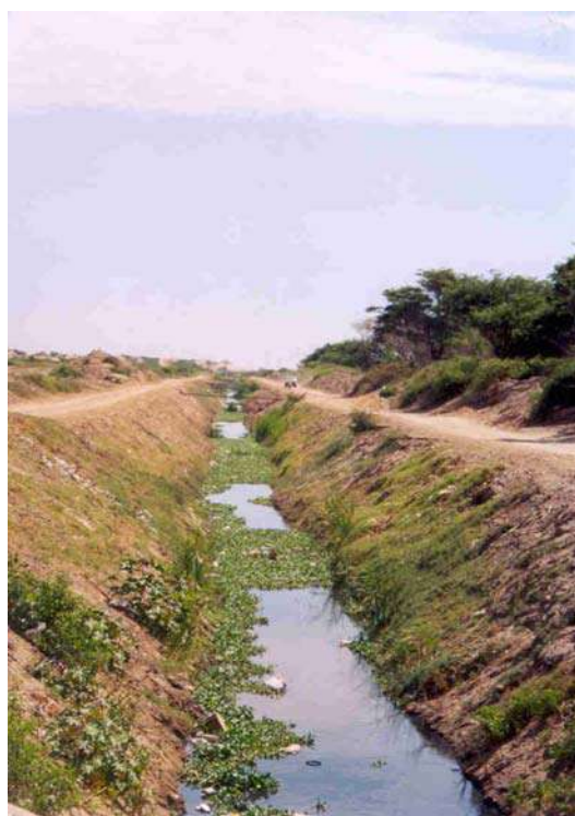
Vista de la sección transversal de un Dren agrícola. La protección debe prever el acondicionamiento de una franja de seguridad.
