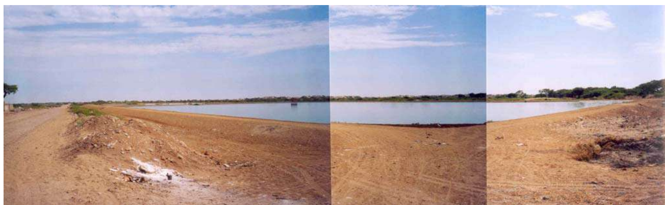
Vista del conjunto de Lagunas de Oxidación camino a Bodegones.
