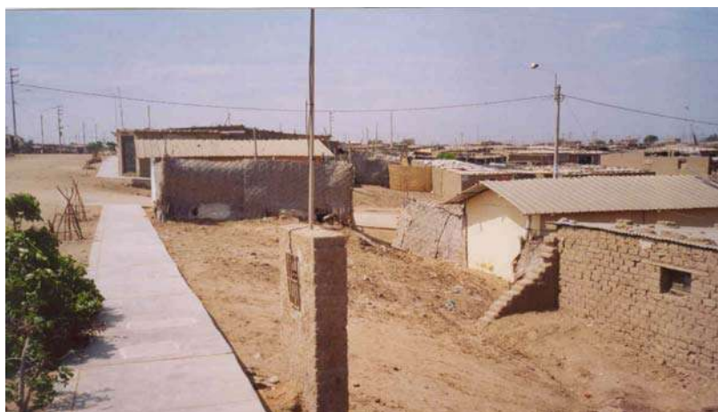
Vista de la inadecuada aplicación de criterios de diseño y sistemas constructivos en la edificación de viviendas. Notese el deficiente emplazamiento en terrenos en pendiente.
