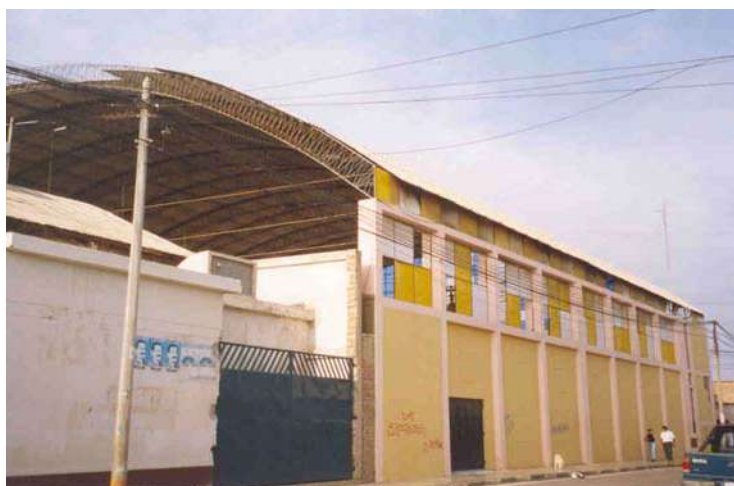
Vista exterior del Coliseo Municipal.
