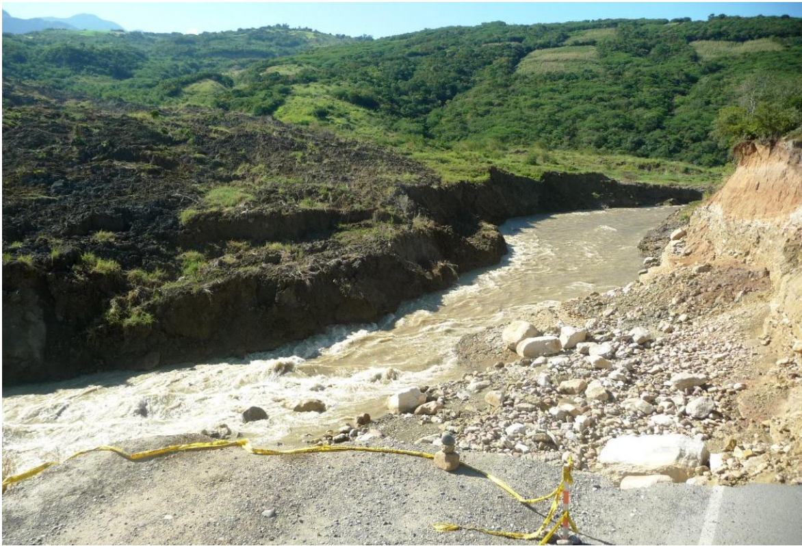
Foto N° 7. Cauce actual del río Utcubamba Foto tomada el 17 de mayo del 2011.
