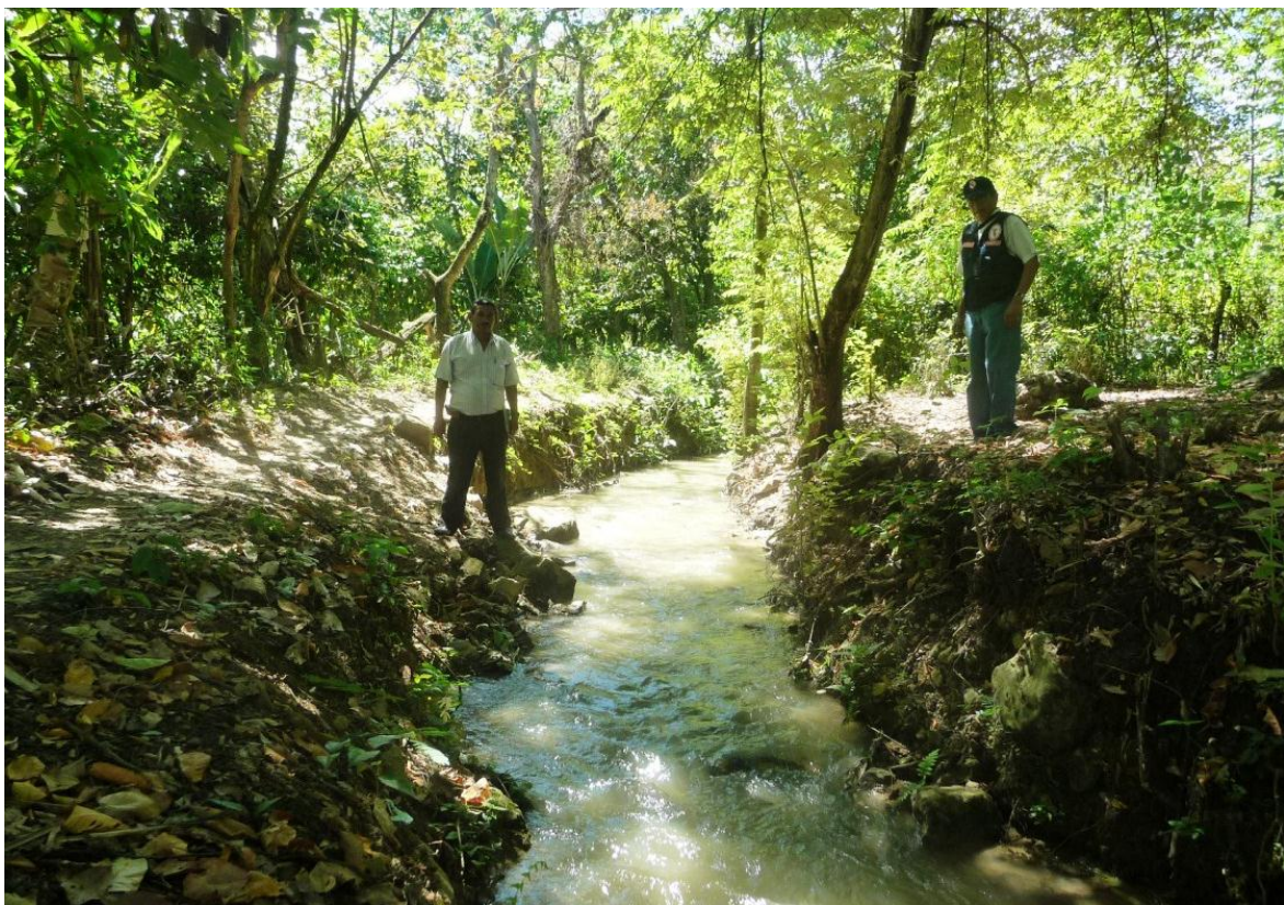
Foto N° 11. Canal de riego sin revestimiento, pasa por la parte alta de la zona afectada por los eventos de movimientos en masa.
