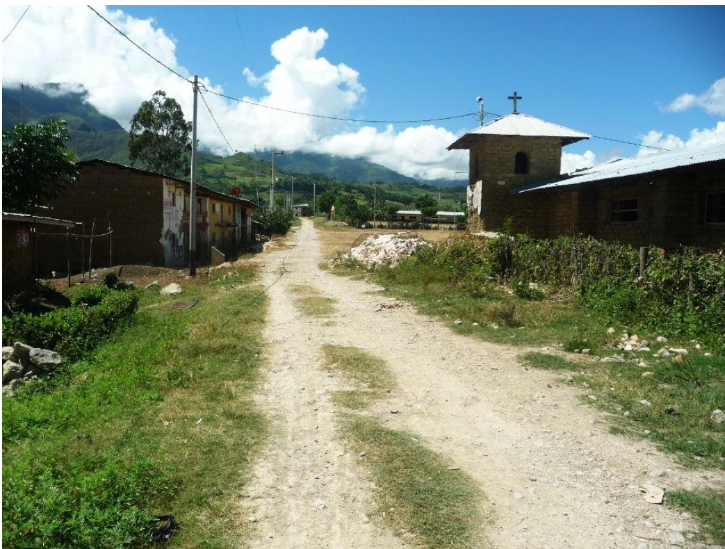
Foto N° 17. Viviendas del Sector San José El Alto, ubicado a 200 metros de la escarpa principal de un deslizamiento traslacional retrogresivo.
