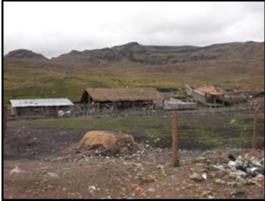
Instalaciones de Botadero Municipal
