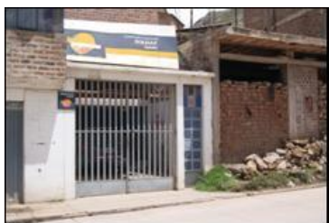
Av. Universitaria N° 220, Distribuidora de gas – Santa Ana
