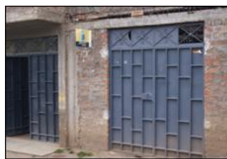
Av. Universitaria N° 387, distribuid. de gas – Paturpampa.
