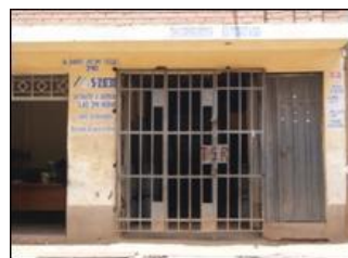
Av. Andrés A. Cáceres N° 340, distribuid. de gas Yananaco.
