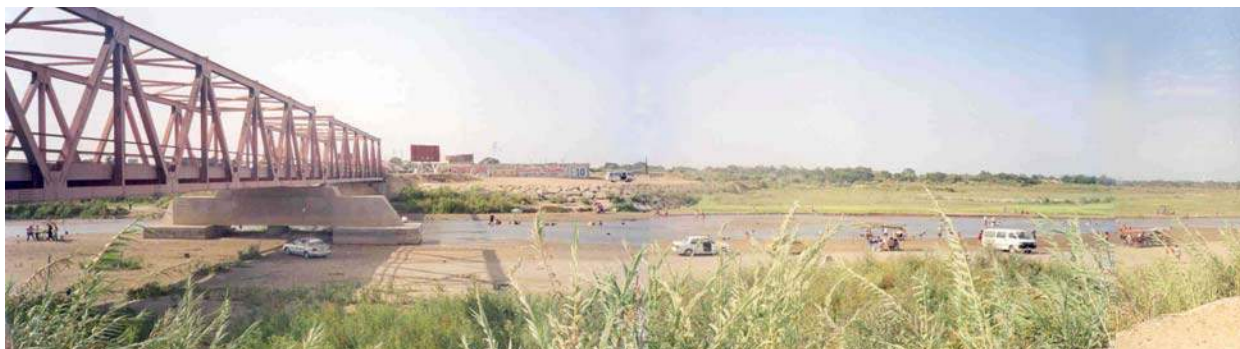
Estructura vulnerable del Puente Reque.
