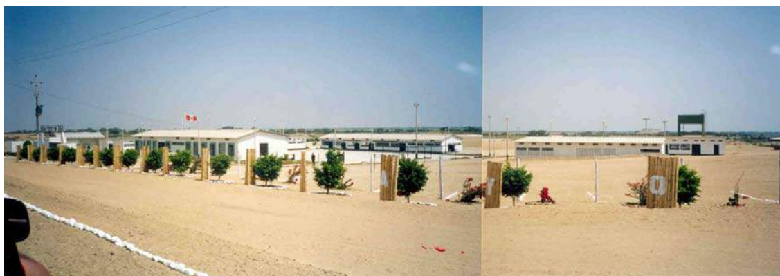
Cuartel de la Policía Nacional del Perú, también forma parte de los equipamientos mayores de Reque.
