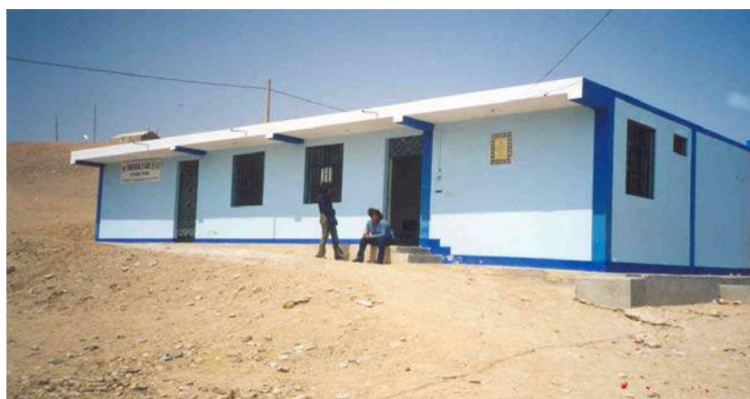
Vista de la infraestructura actual del Centro de Salud Las Delicias.
