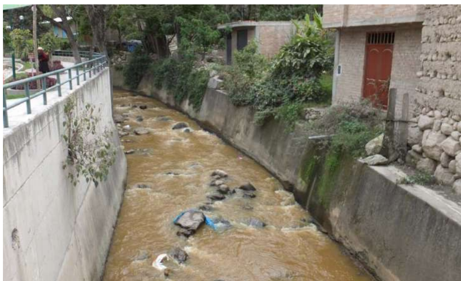
Foto 11: Vista del río Maygasbamba, afluente del río Llaucano, en el Sector de José Olaya. Se aprecia residuos de basura, así como descargas domiciliarias de desagüe. En este sector de la ciudad el río se encuentra canalizado en sus laderas.
