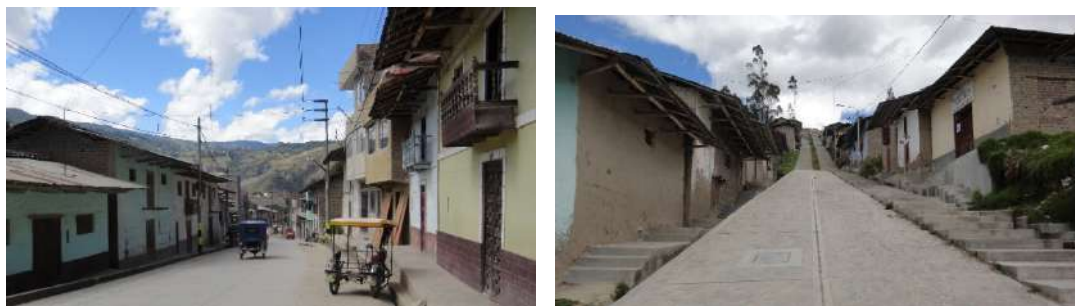
Foto 14: Material de edificaciones, altura y estado de conservación en Bambamarca
