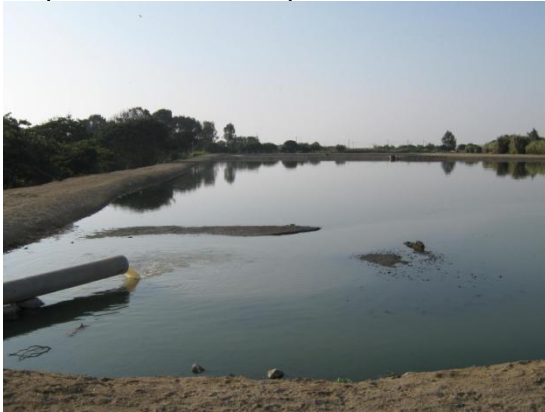
Foto N° 42 .- Laguna de oxidación ubicada en el Tablazo
