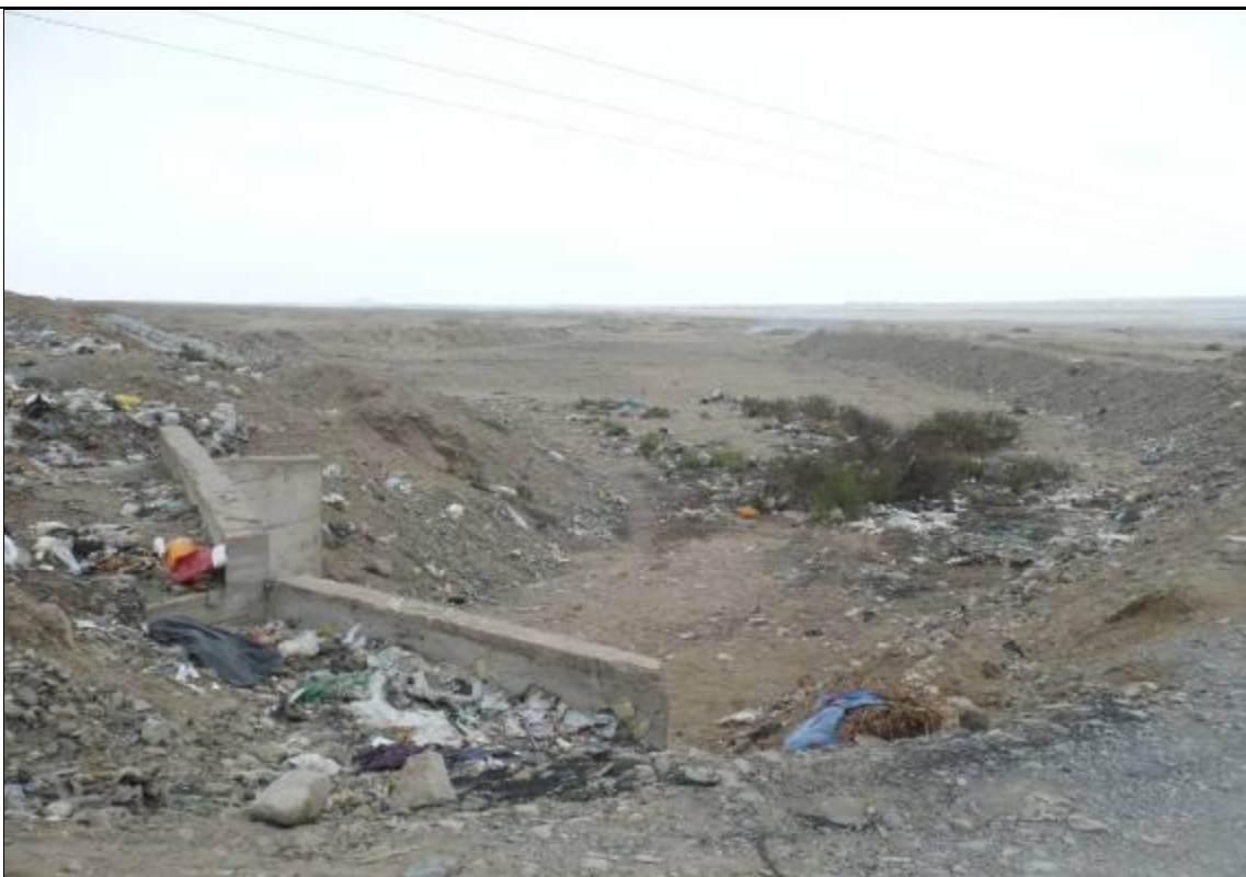
Vista aguas abajo - salida de alcantarilla
