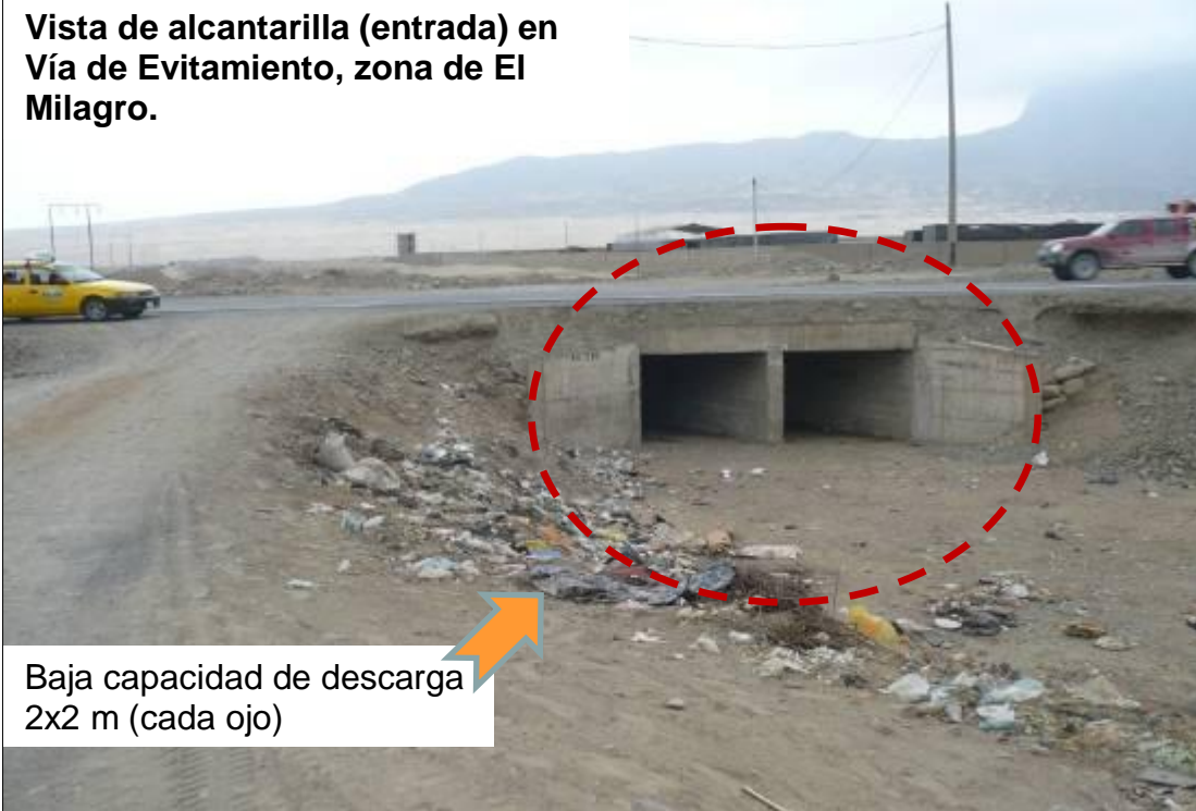
Vista de entrada de alcantarilla
