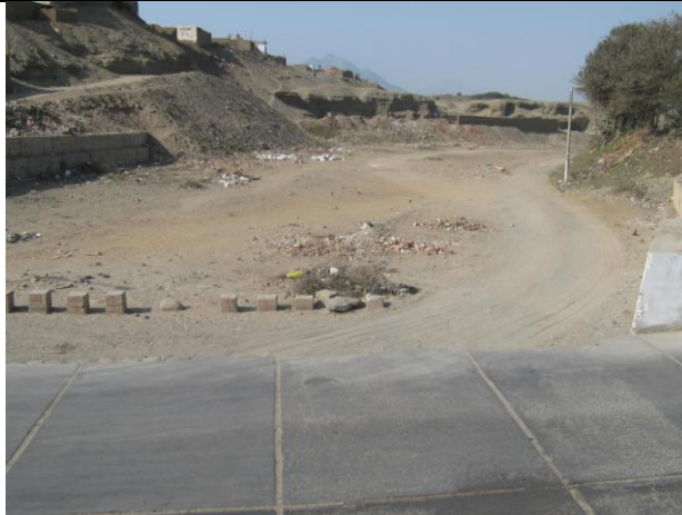
Foto Nº. 17 .- Cauce de la Quebrada León Dormido- Huanchaco
