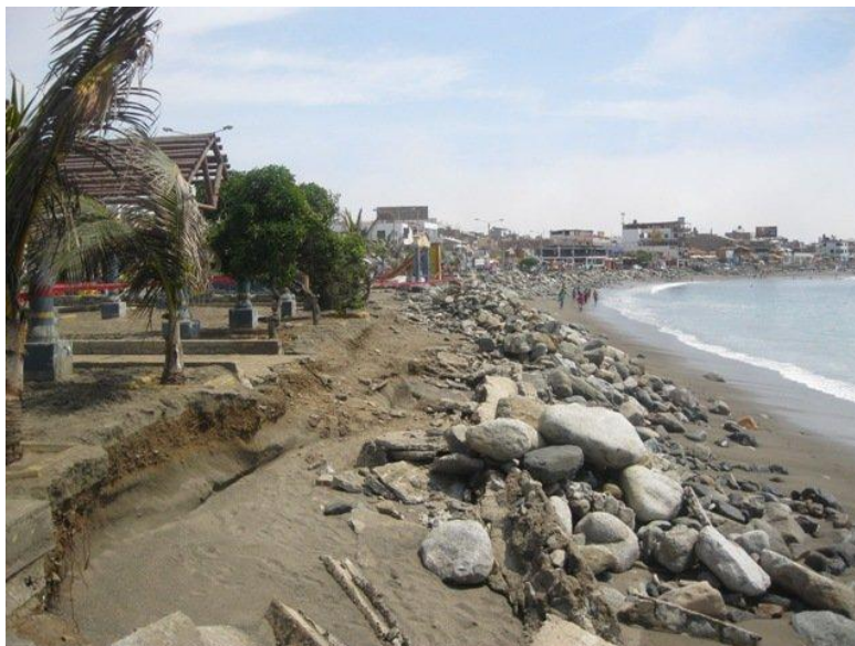
Foto N° 36 Afectación y erosión marina en el Balneario de Huanchaco Playa
