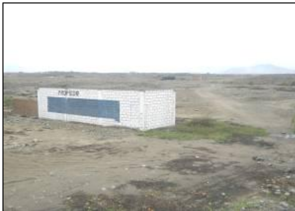
Muro de albañilería que deberá ser demolido, actualmente bloquea la dirección del flujo.
