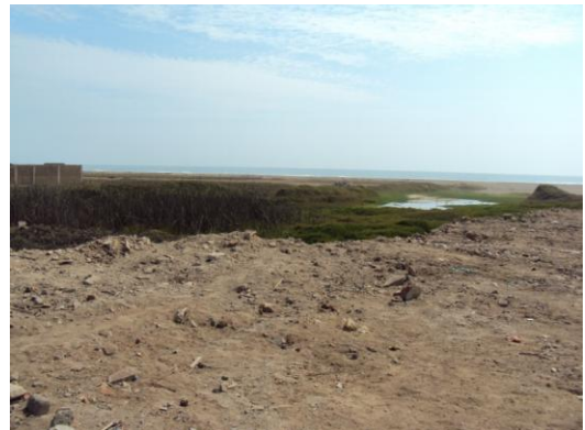
Foto Nº.04 .- Vista Panorámica de Huanchaquito Bajo donde se aprecia trabajos de relleno en zona húmeda.
