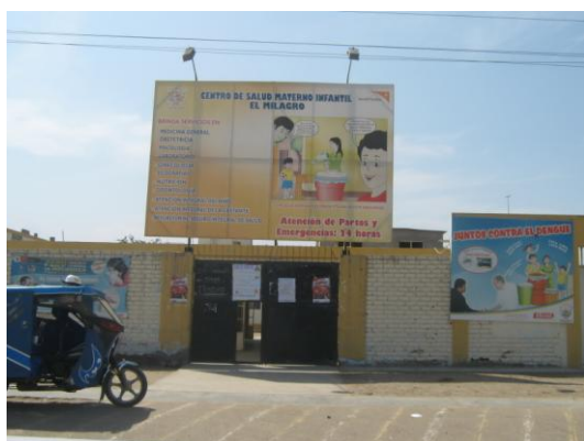
Foto N° 22 Posta de Salud Centro Poblado El Milagro
