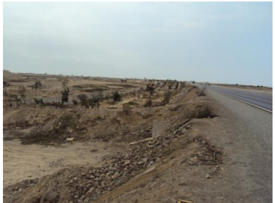
Foto N°. 12 .- Vista Panorámica de la carretera Vía de Evitamiento de la Panamericana Norte donde se aprecia el talud formado que trabaja como muro de contención para evitar la llegada del agua al Aeropuerto, en una futura avenida del Fenómeno del Niño.
