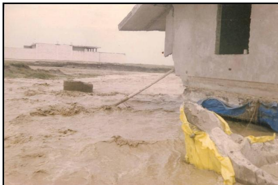
Foto N° 46 Edificaciones en cauce de quebradas
