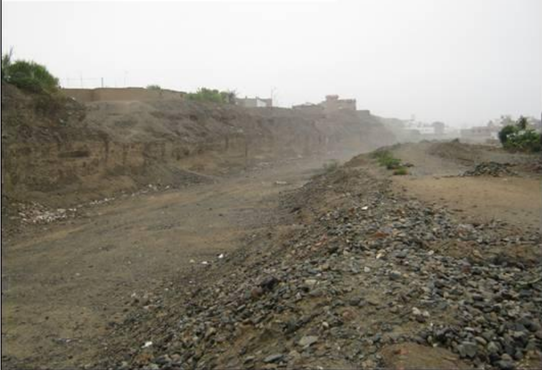
Vista aguas abajo, QDA. Rio Seco
