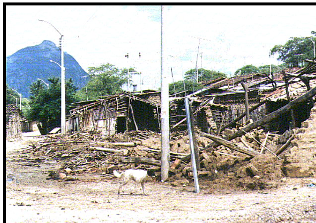
Foto N° 33 Muestra de la destrucción de casas ubicadas en la parte baja de Huanchaquito por los desbordes de las aguas venidas en tiempo del Fenómeno del Niño.
