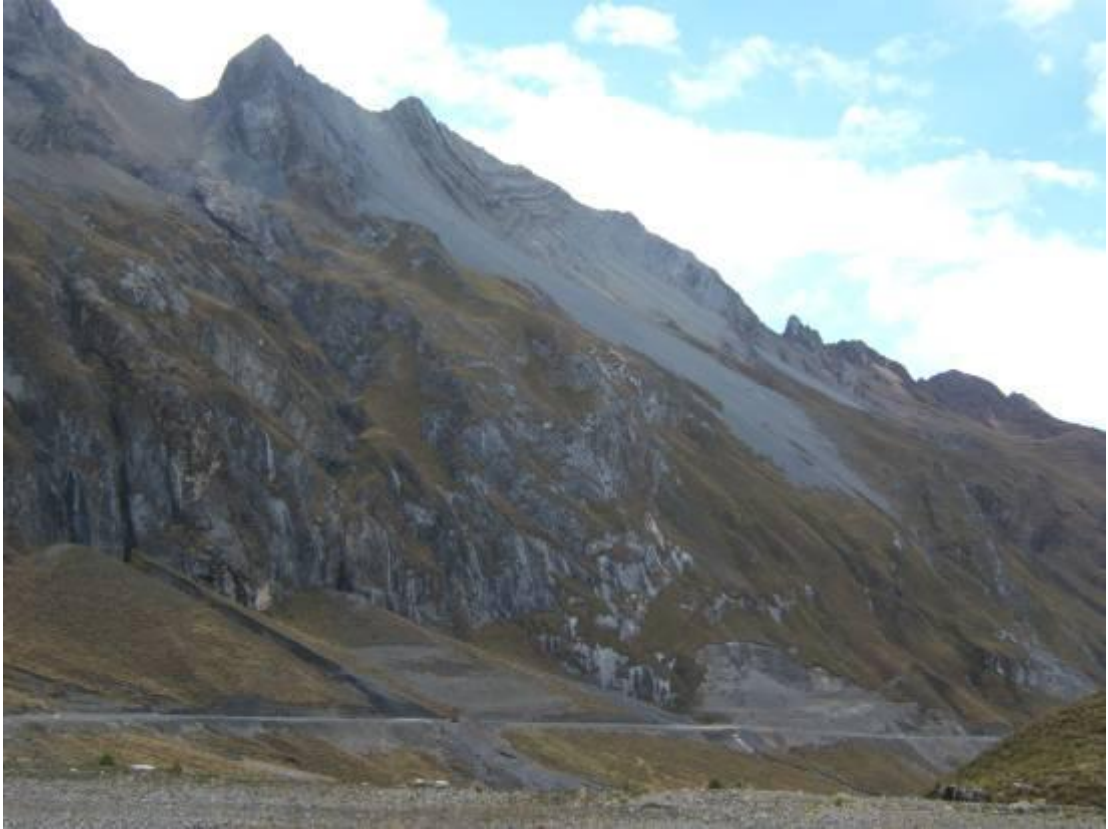
Foto 44 Área susceptible a peligros de avalancha de detritos, ladera del nevado Burro, cabecera de la cuenca del río Fortaleza (Km 46-47 tramo Conococha-Antamina).
