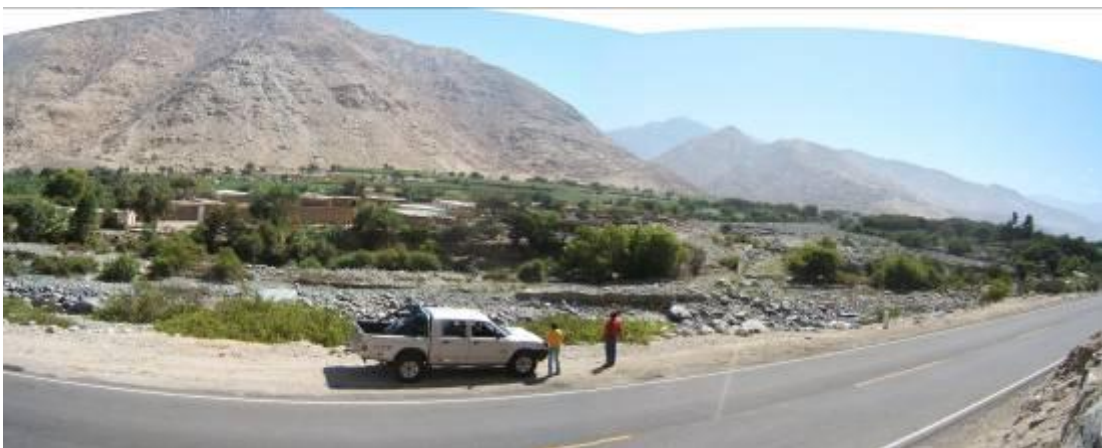
Foto 41 Vista del sector de Huaquish afectado por flujo de detritos de la quebrada Patap; en el mismo sector erosión fluvial.
