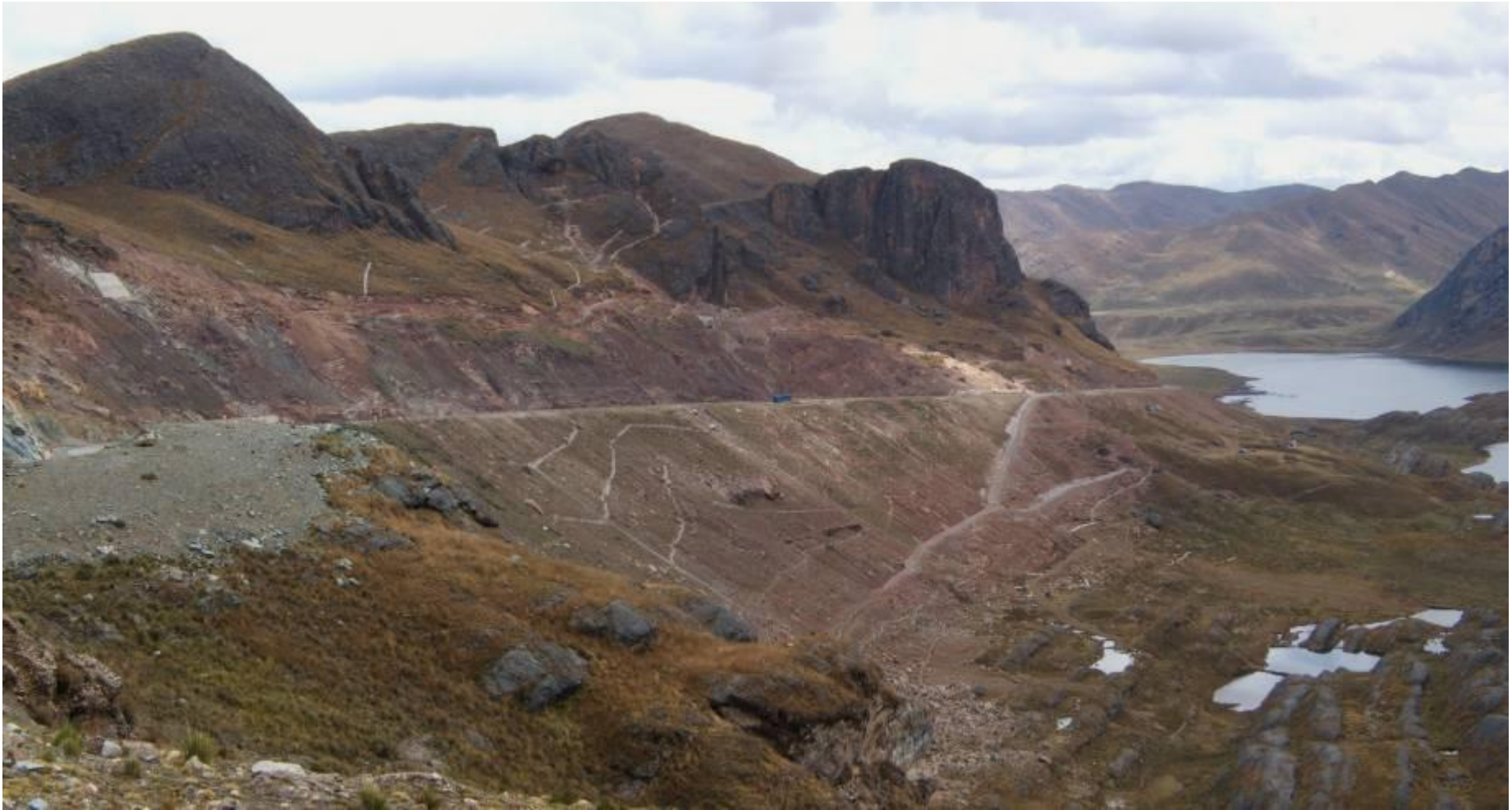
Foto 66 Sector de la laguna Canrash (carretera Conococha-Antamina), afectada por vuelco, derrumbes y caída de rocas.
