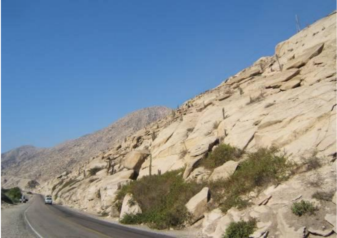
Foto 32 Laderas en rocas intrusivas con bloques inestables, sujetos a caída de rocas; paraje Chiquiahuanca (Km 43-44, Pativilca-Conoccocha)
