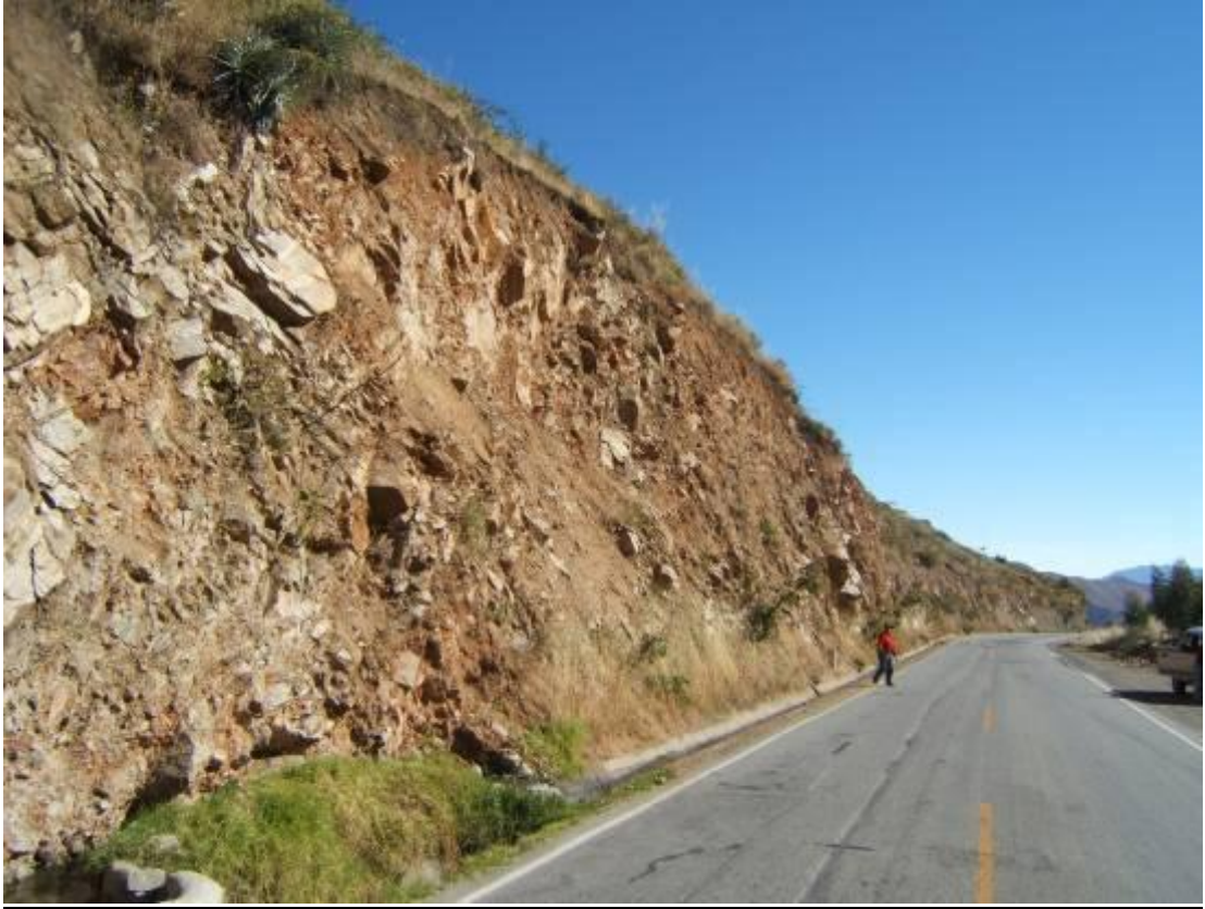
Foto 38 Sector susceptible a derrumbes y caída de rocas, Km 92 Pativilca-Conococha.
