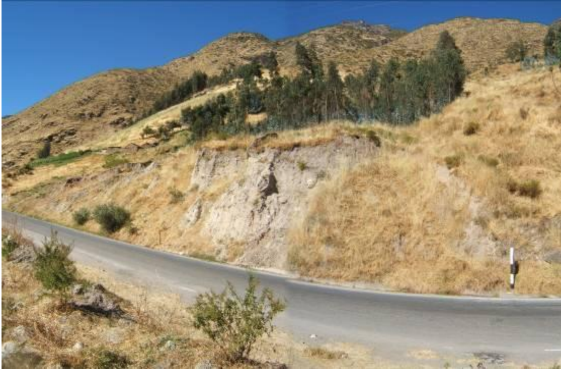
Foto 51 Deslizamiento rotacional antiguo, reactivado, sector de Puquioyacu, cerca de Pampas Chico (Km 98 Pativilca-Conococha).
