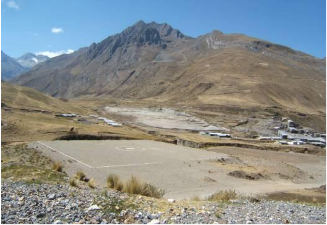
Foto 29 Rellenos antrópicos generados por la actividad minera, sector Pachapaqui; se aprecia además montañas sedimentarias con estructuras plegadas.
