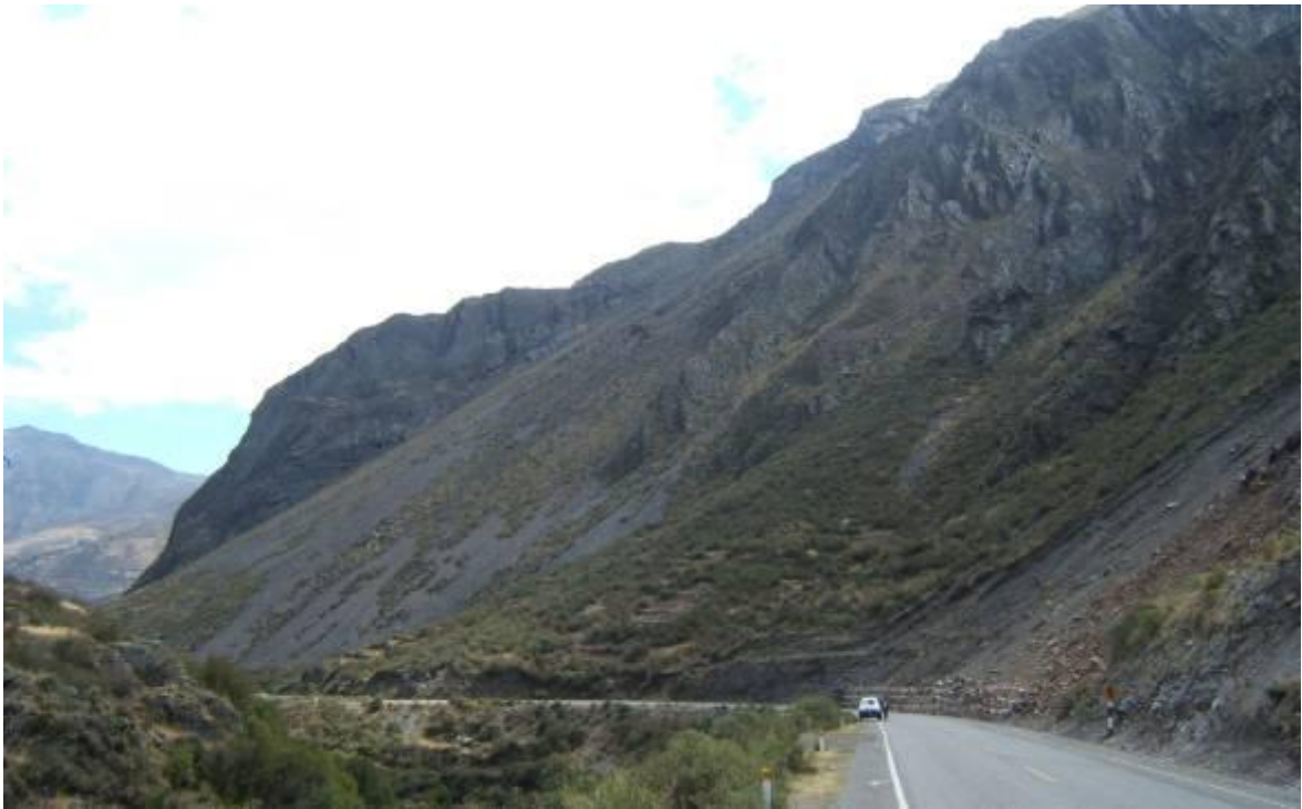
Foto 68 Zona crítica por caída de rocas y avalancha de detritos, laderas de los cerros Cresta de Gallo e Iscatana.
