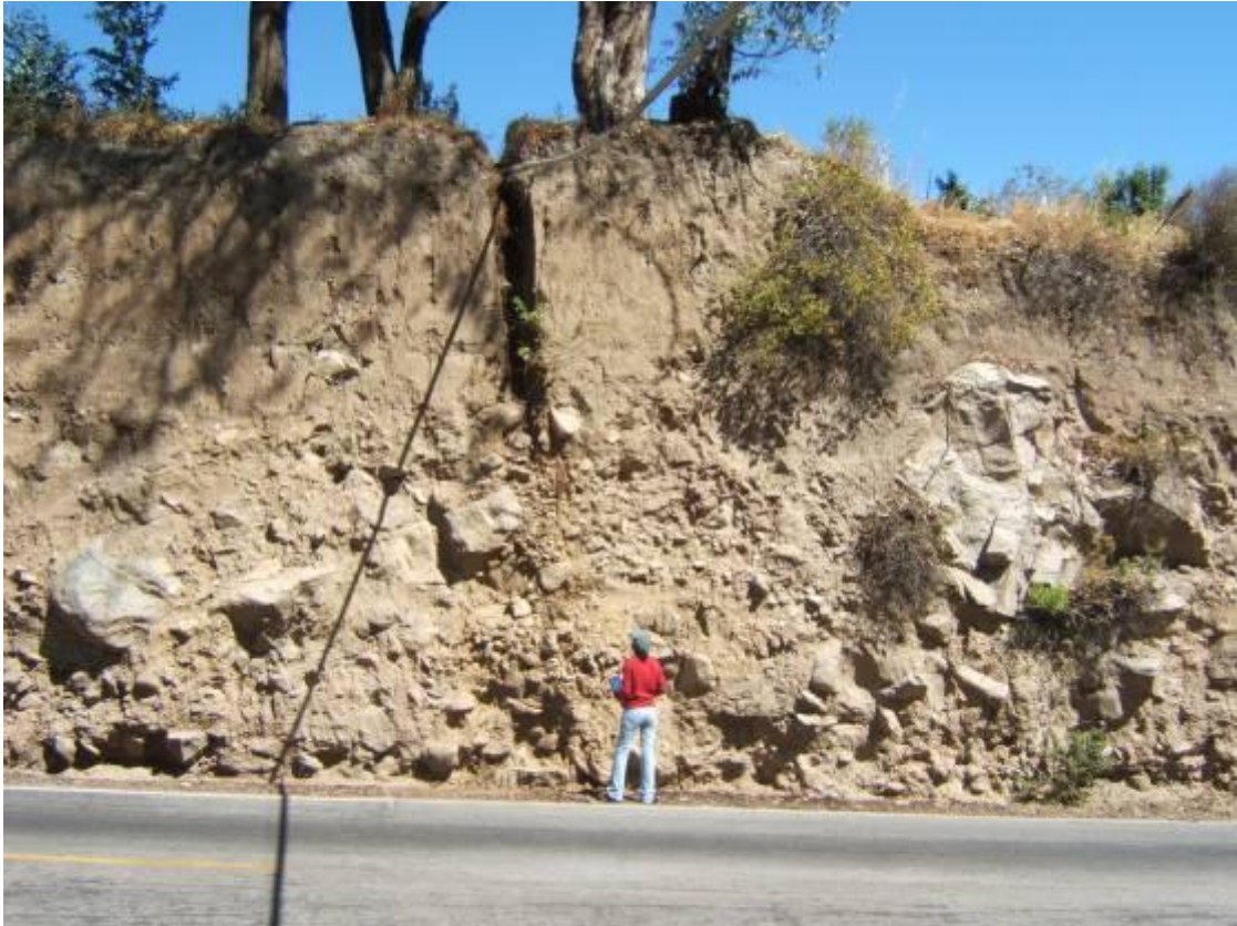
Foto 14 Sector Raquia, taludes de corte de carretera que muestra dos eventos de depósitos caóticos de origen proluvial, el superior de granulometría fina.
