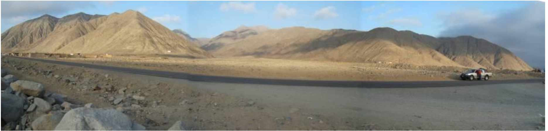
Foto 62 Quebrada Manas, zona crítica susceptible a flujos e inundación de detritos excepcionales.
