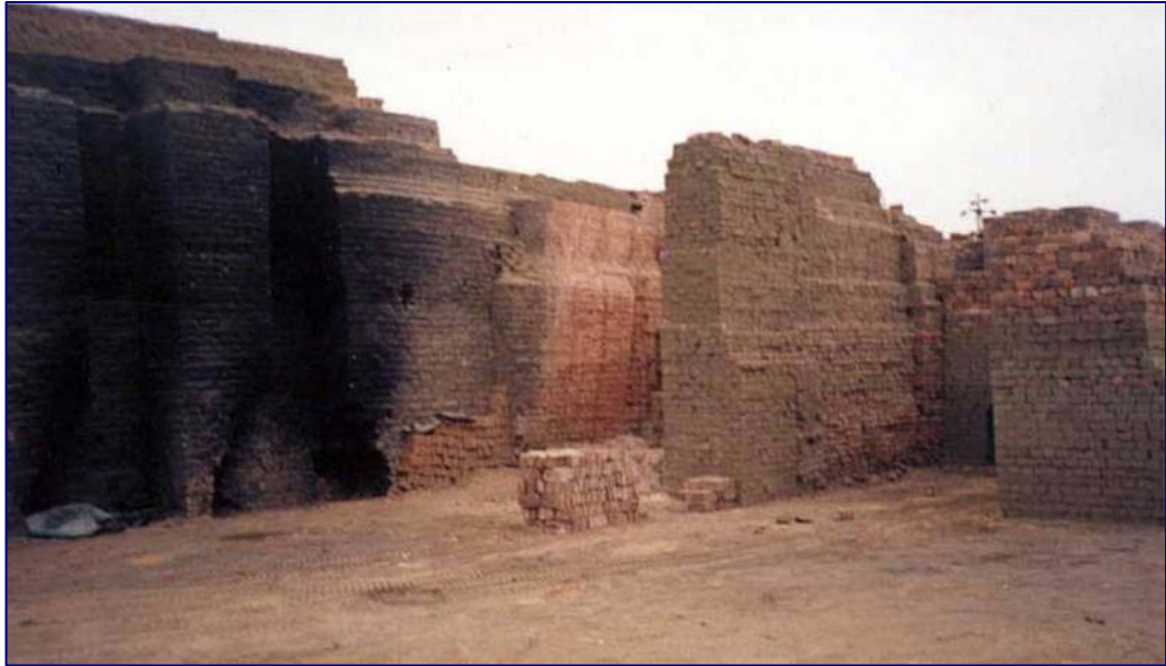
Figura 4.3 Ladrillera de la Campiña de Moche
