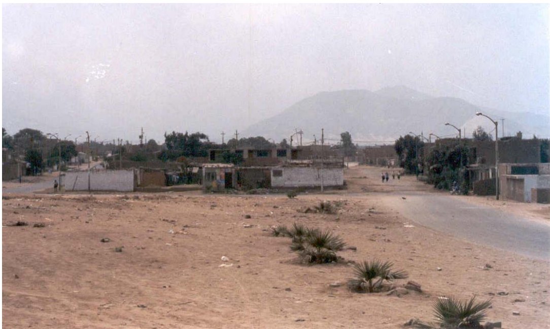
Figura 4.18. Viviendas reconstruidas en el sector Mampuesto del distrito El Porvenir; en área que fue inundada debido al desborde de la quebrada San Ildefonso, en 1998.
