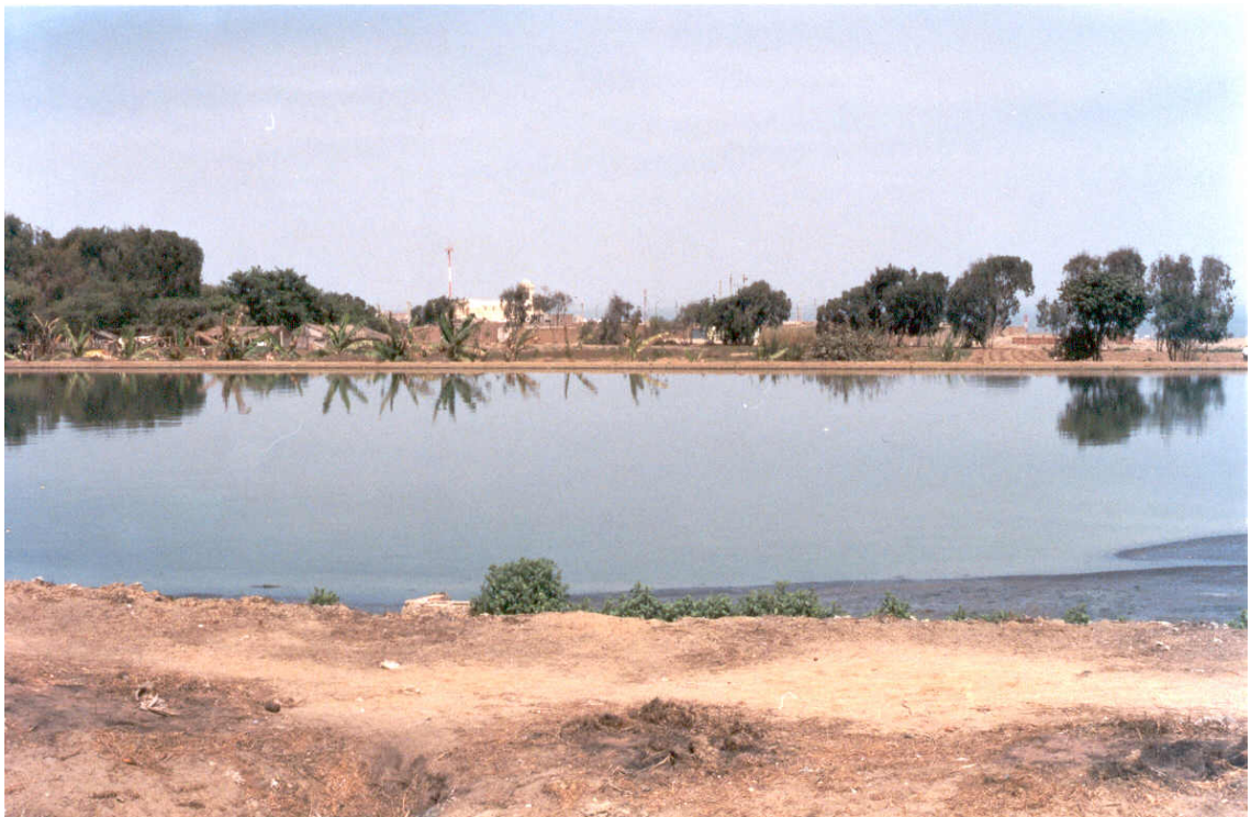
Figura 4.20. Lagunas de sedimentación del sector El Tablazo del distrito Huanchaco, con taludes sin revestimiento y gran deterioro; cerca a éstas se encuentran cultivos y viviendas, como las del poblado Nuevo Paraíso (al fondo).
