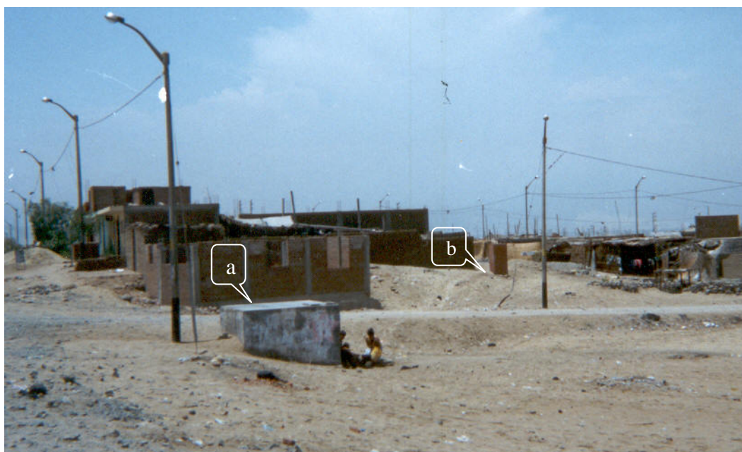
Figura 4.16. Viviendas en el sector Alto Trujillo del distrito El Porvenir; se muestra reservorio de agua (a) y letrina sanitaria (b) en condiciones deficientes.
