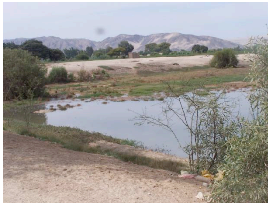
Lagunas de Estabilización. Santiago.
