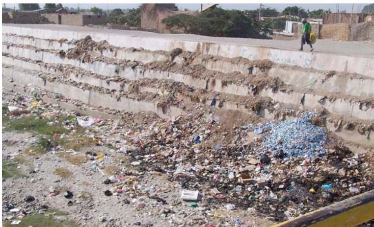
Cauce del río Ica, a la altura de Parcona
