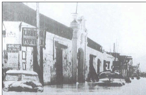
Mercado Central, zona muy afectada por la inundación.1963
