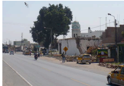
Viviendas en el centro de Guadalupe, con daños severos (colapso)
