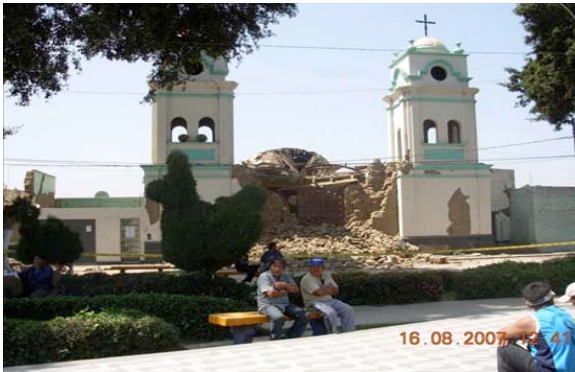
Iglesia de Guadalupe con daños severos (colapso)
