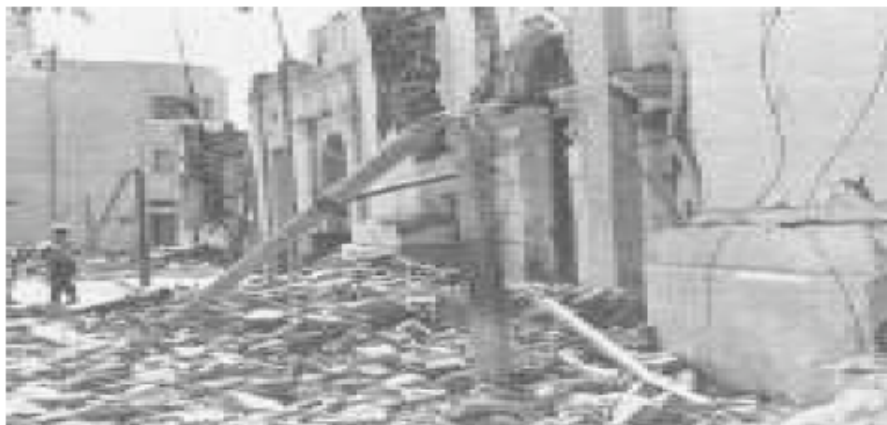
Terremoto de 1950, que destruyó parcialmente la ciudad de Ica Foto: Almanaque Estadístico de Ica. INEI
