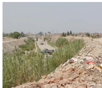
Río Ica. Al fondo, depósito fluvial. En primer plano, depósito antropogénico.
