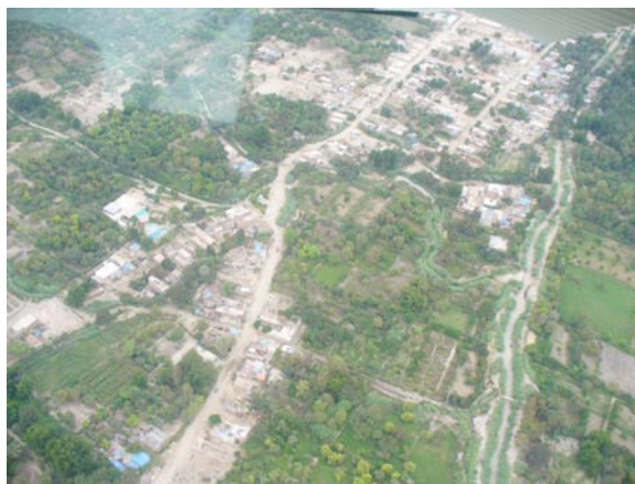
Acequia La Achirana en tramo Los Aquijes
