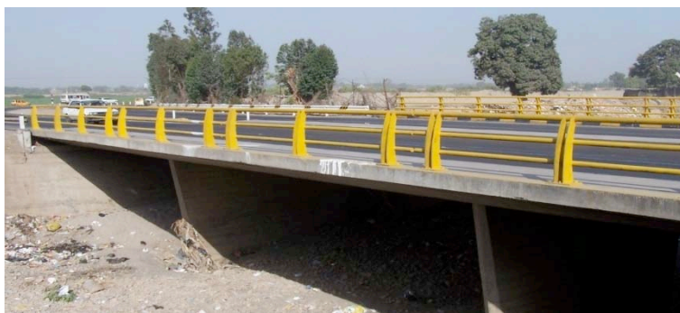
Puente Los Maestros. Salida de la carretera Panamericana de Ica hacia Los Aquijes, Pueblo Nuevo, Tate y Santiago.
