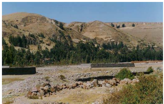
OBRAS DE PROTECCIÓN EXISTENTES EN EL RIO SANTA-GAVIONES
