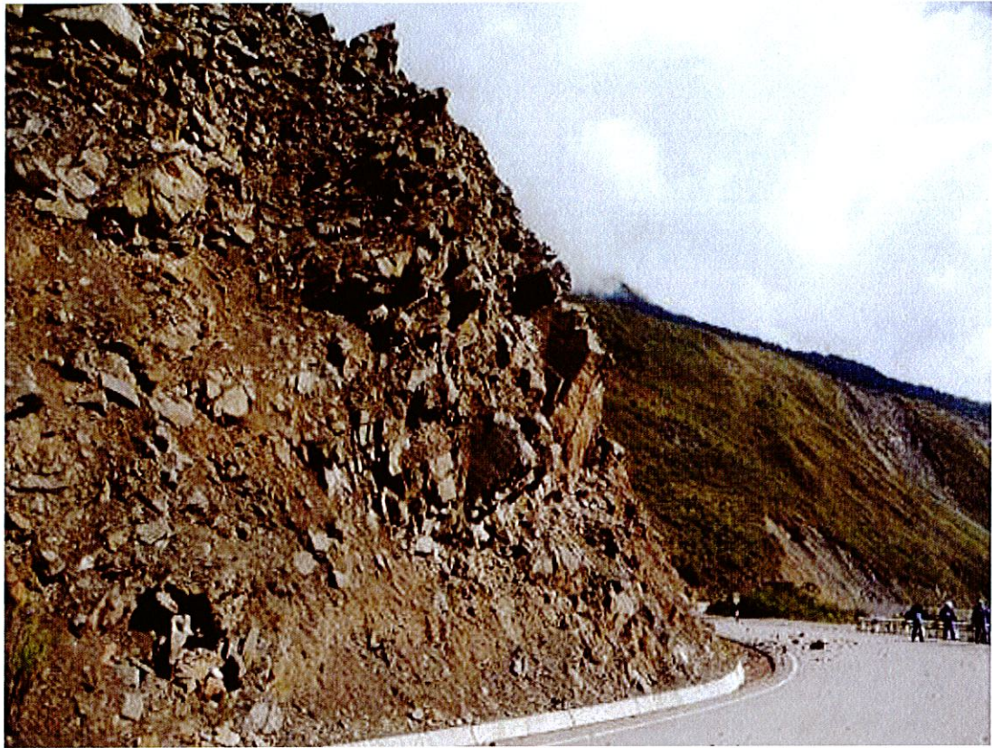
Foto 5. Macizos rocoso muy fracturado compuesta por pizarra moteada; presenta una pendiente muy fuerte ( 65^{\circ} a 70^{\circ} ) en el talud de corte.
