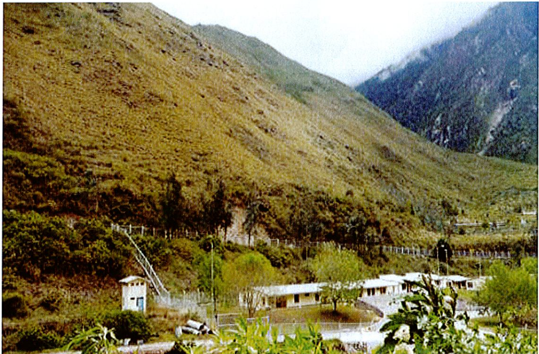
Foto 2. Villa de Residentes Chuani. Obsérvese el estado de las laderas y el talud de corte.
