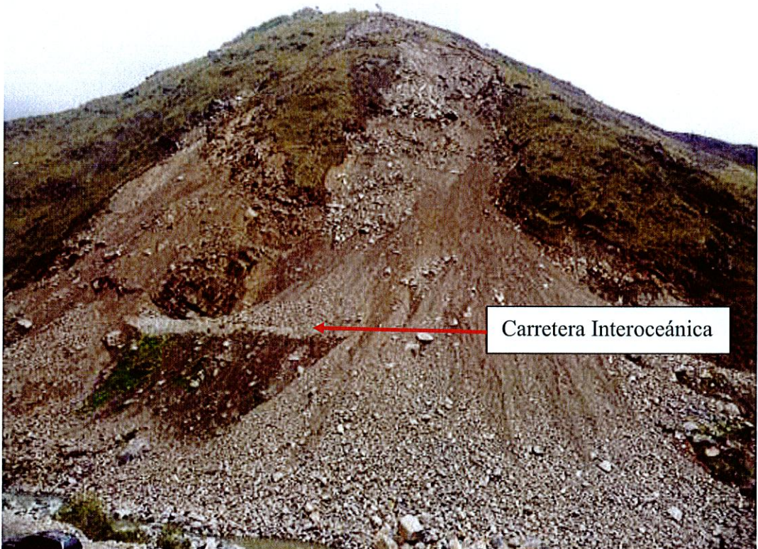
Foto 10. Ladera del cerro Michi Michi; Km 240+250 de la Carretera Interoceánica, después del derrumbe.
