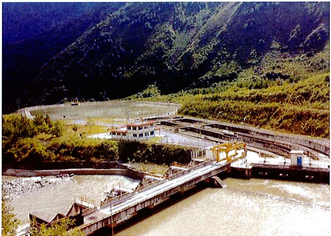
Foto 3. Instalaciones de la Centra Hidroeléctrica San Gabán II.
