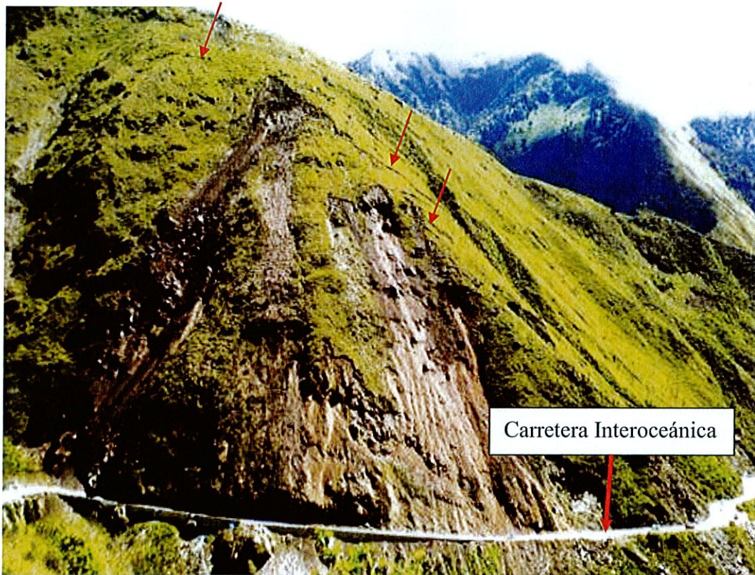
Foto 09. Ladera del cerro Michi Michi; Km 240+250 de la Carretera Interoceánica, antes del derrumbe. Obsérvese las grietas de coronación y los grandes bloques al pie
