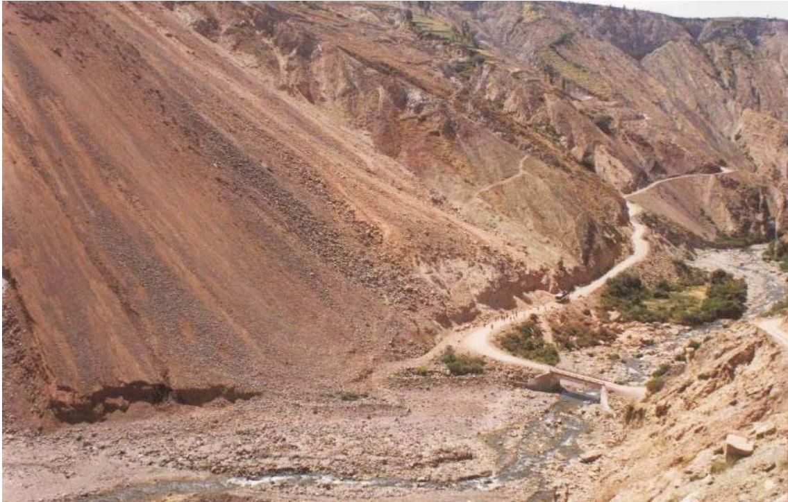
Foto 23: Derrumbes en la carretera Huanca - Taya - Lluta
