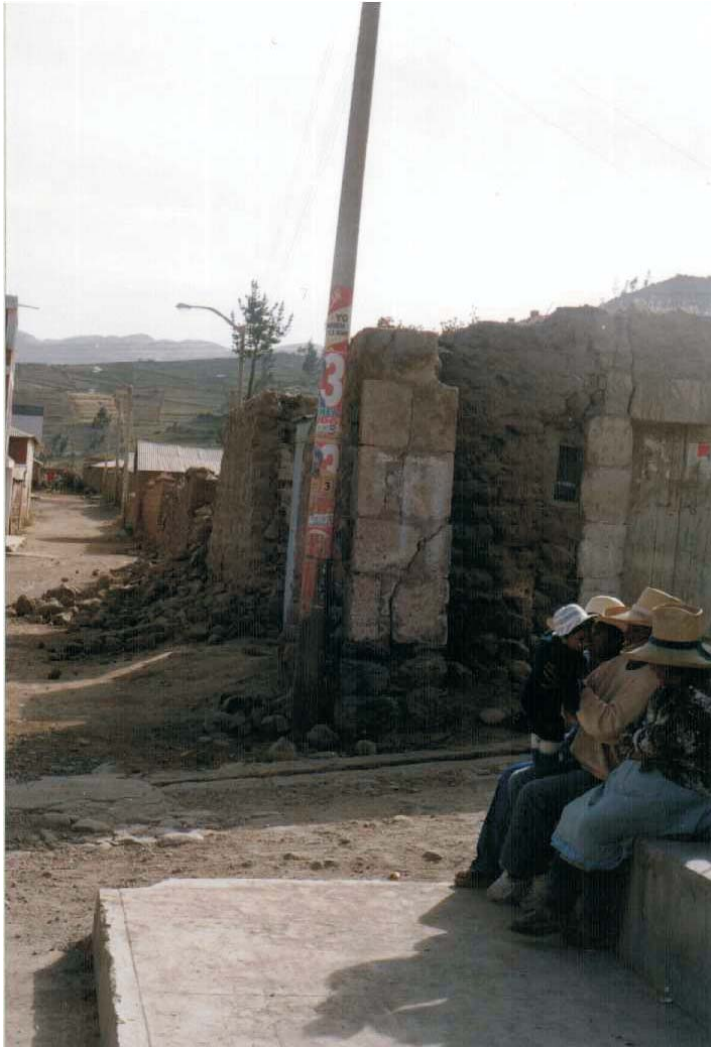
Foto 15: Derrumbes de paredes en la calle Junín cuarta cuadra Huanca
