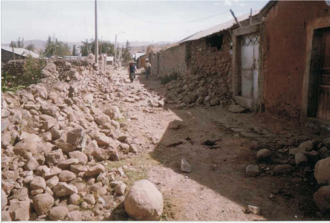
Foto 19: Caída de paredes en la calle Miguel Gráu - Huanca
