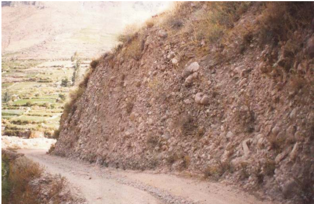
Foto N° 6: Vista donde se observa la composición de los suelos de la zona de Huanca
