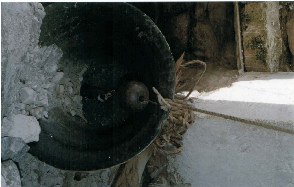
Foto 18: Caída de la campana de la Iglesia de Huanca
