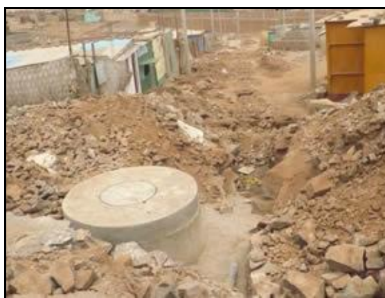
Foto N° 45. Obras de alcantarillado
