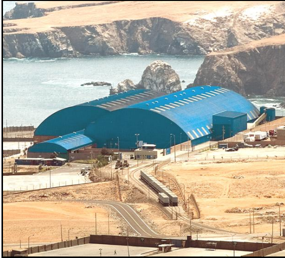
Foto N° 11. Depósito de Concentrado de Mineral
