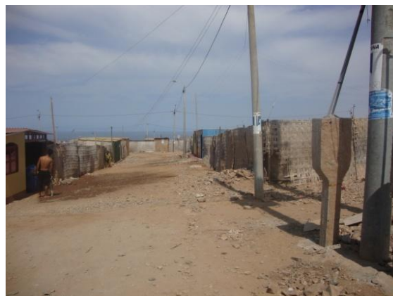
Foto N° 59. Redes eléctricas en AA.HH.
