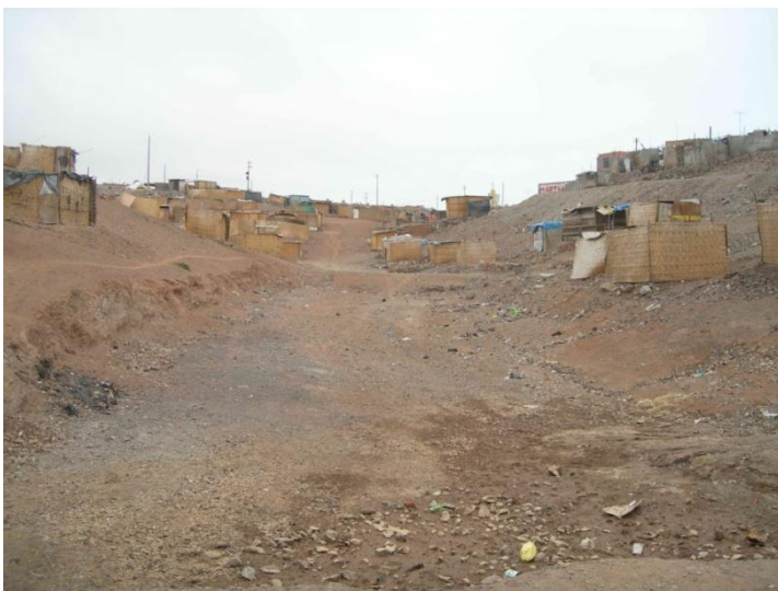
FOTO N° 46. Parte de la quebrada Matarani que está siendo invadida por viviendas precarias
