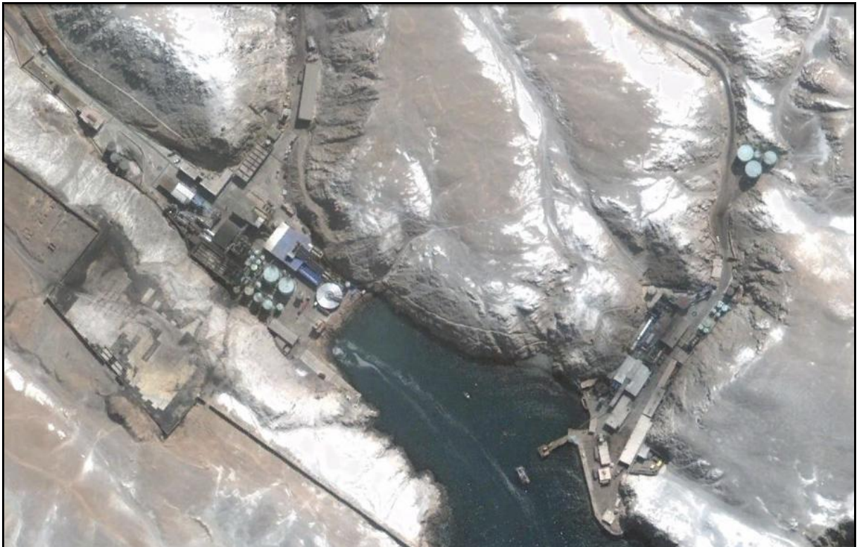
FOTO N° 13. INSTALACIONES INDUSTRIALES EN EL LÍMITE DEL ÁREA DE ESTUDIO
