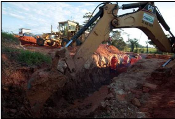
Foto Nº 1. Obras Carretera Interoceánica
