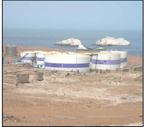
Foto N° 12. Depósito de Sustancias peligrosas
