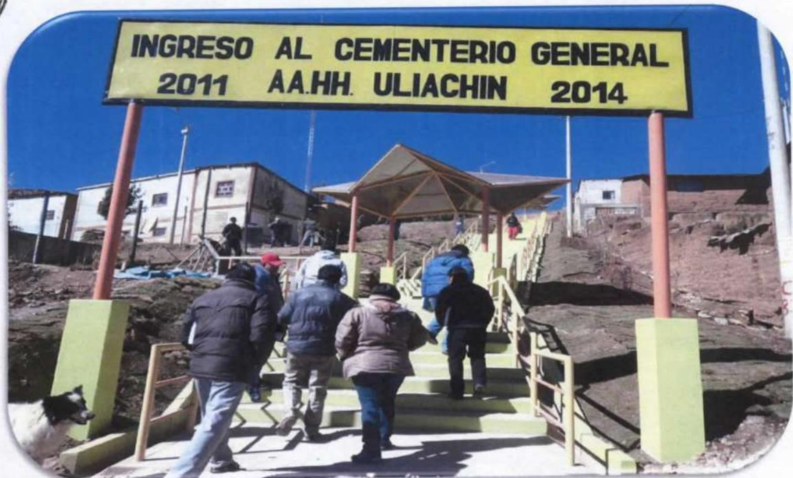
GRADERIAS DE CONCRETO ARMADO Y DRENAJES PLUVIALES PARA REDUCIR RIESGO DE DERRUMBES.
