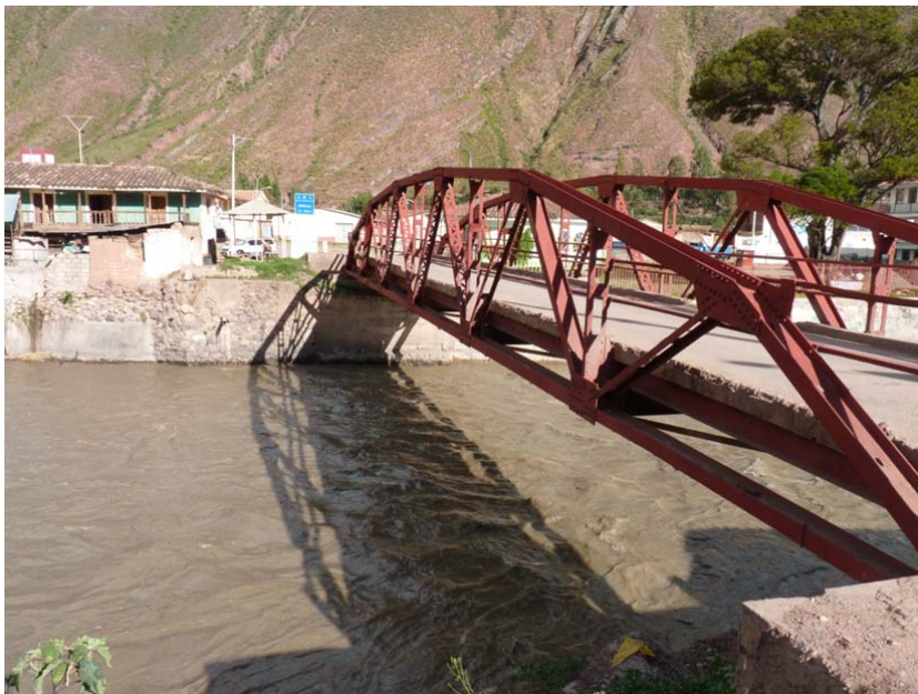
Foto 11: Vista del Puente Huayllabamba, el cual está parcialmente en uso.
