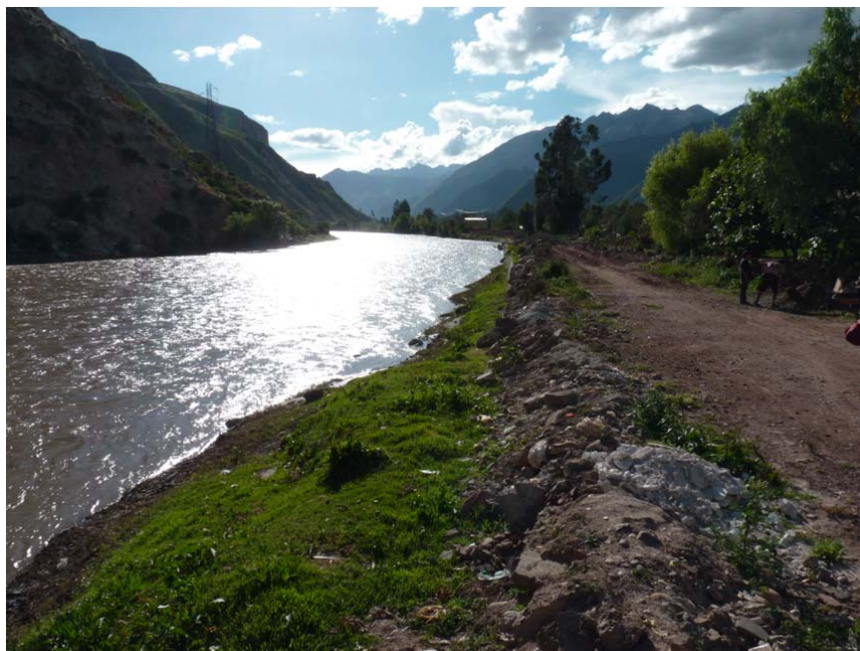
Foto 13: Vista de la carretera ya reconstruida que fue erosionada por la crecida del río Vilcanota.
