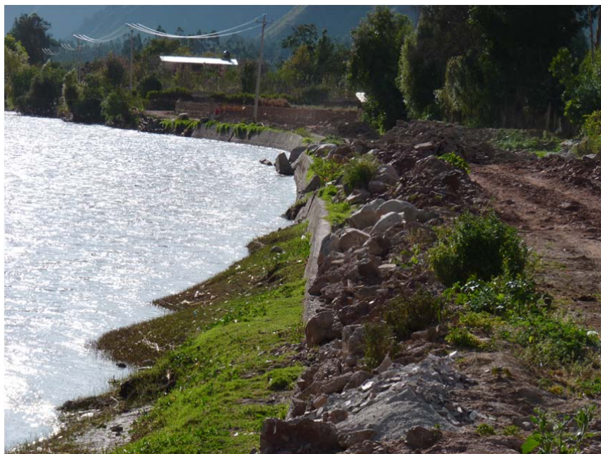
Foto14: Construcción parcial de un muro de defensa. El resto de la carretera se encuentra sin ninguna protección ante futuras crecidas.
