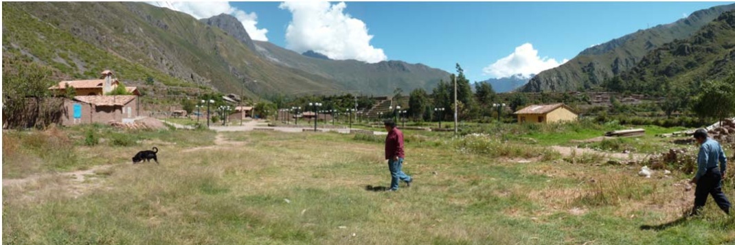
Foto 01: Vista del área afectada por crecidas del río Vilcanota.
