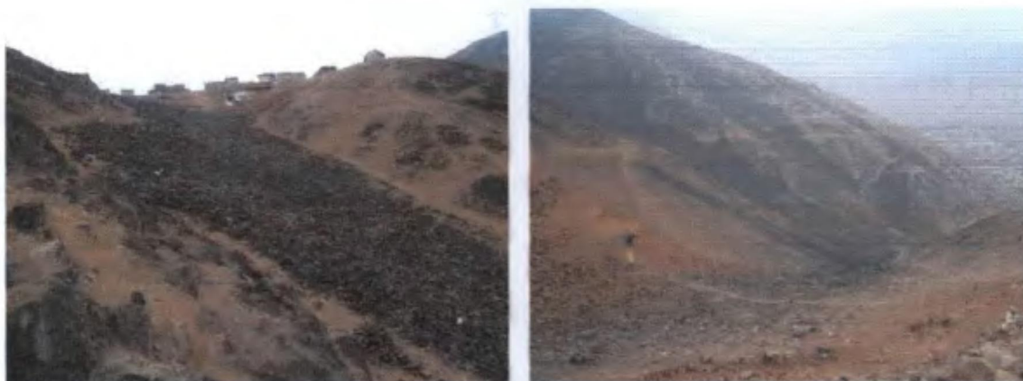
Foto N° 11 y 12. Se observan conos de talus debajo de la manzana "B" y entre las manzanas "A" y "F", las cuales podrían originar flujos.
