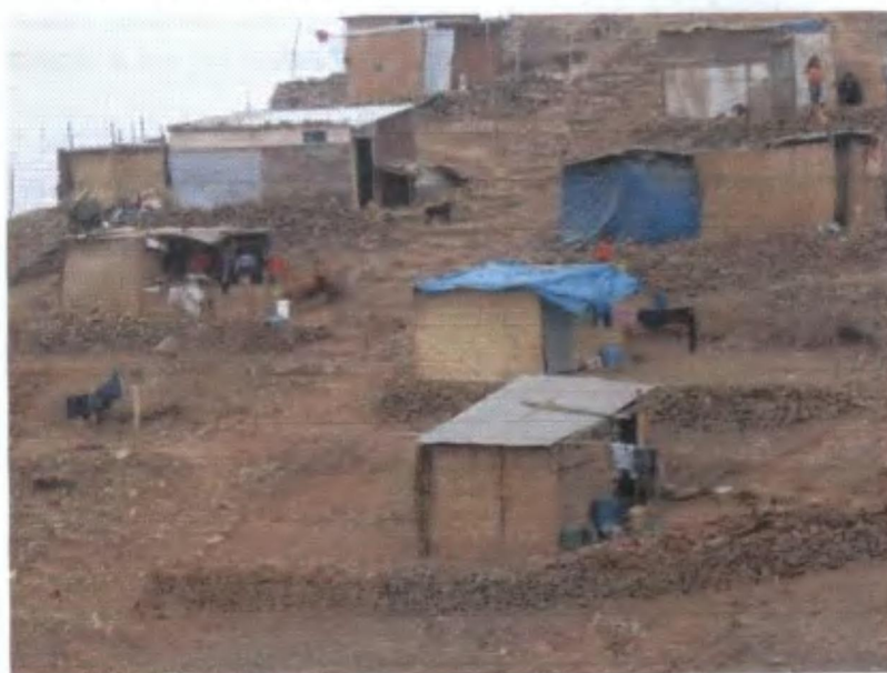
Foto N° 13. Obsérvese los terraplenes que terminan en una pirca sin adhesión, la cual podría colapsar y originar derrumbes.
