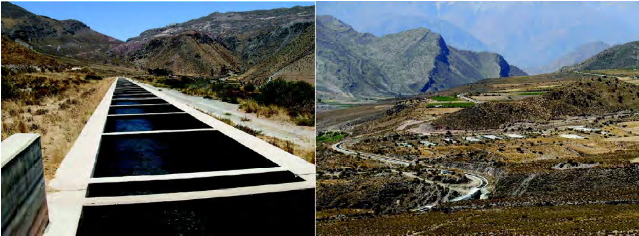
Fig. 1.9 Canal de irrigación Majes en la zona de Huambo
