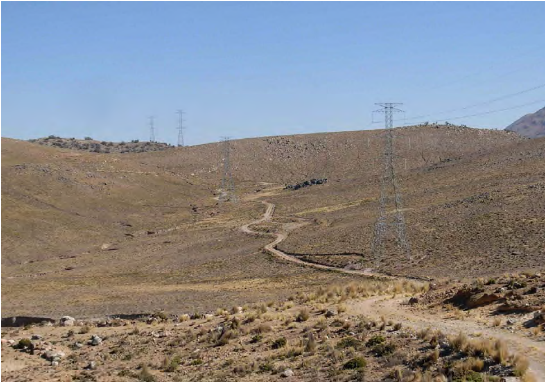
Fig. 2.0 Línea de transmisión eléctrica Socabaya-Mantaro, junto con la carretera construida para su instalación y mantenimiento
