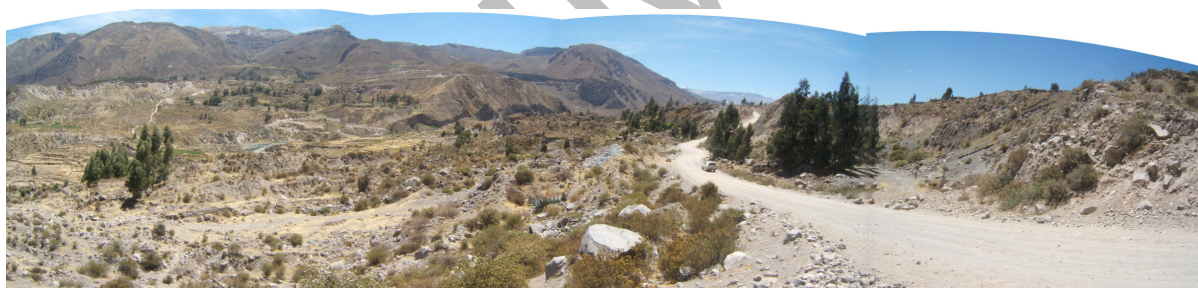
Deslizamientos rotacionales que afectan al distrito de Maca y carretera a Cabanaconde. Deslizamiento de Maca.
