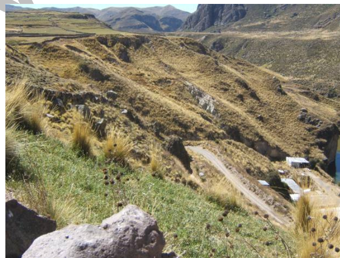
Deslizamiento rotacional que en el año 2005 produjo asentamientos de terrenos que afecto casa de maestranza de la bocatoma de Tuti.
