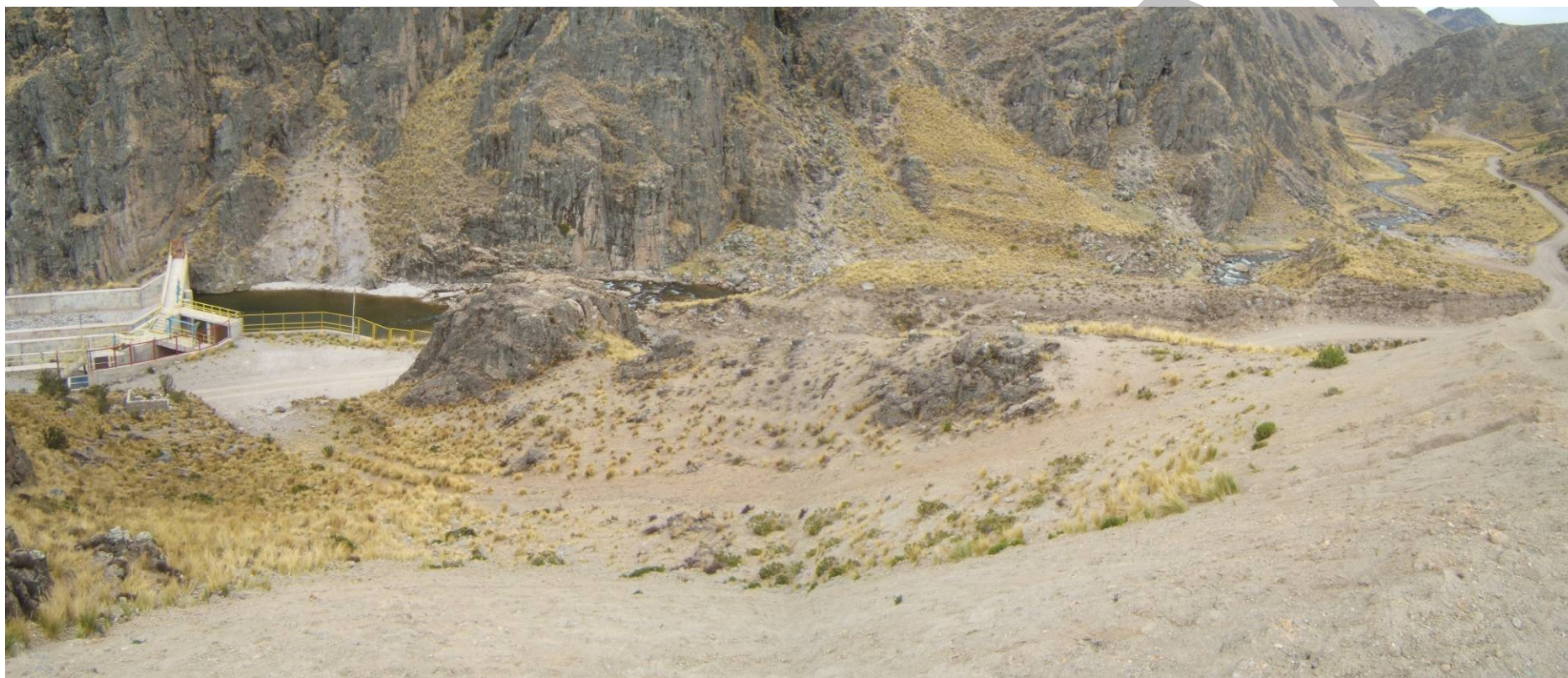
Sector Collaglla. Flujo de detritos en épocas de precipitaciones puede cortar el tránsito por la carretera y destruir la bocatoma de la Central Hidroeléctrica de Huancarama.
