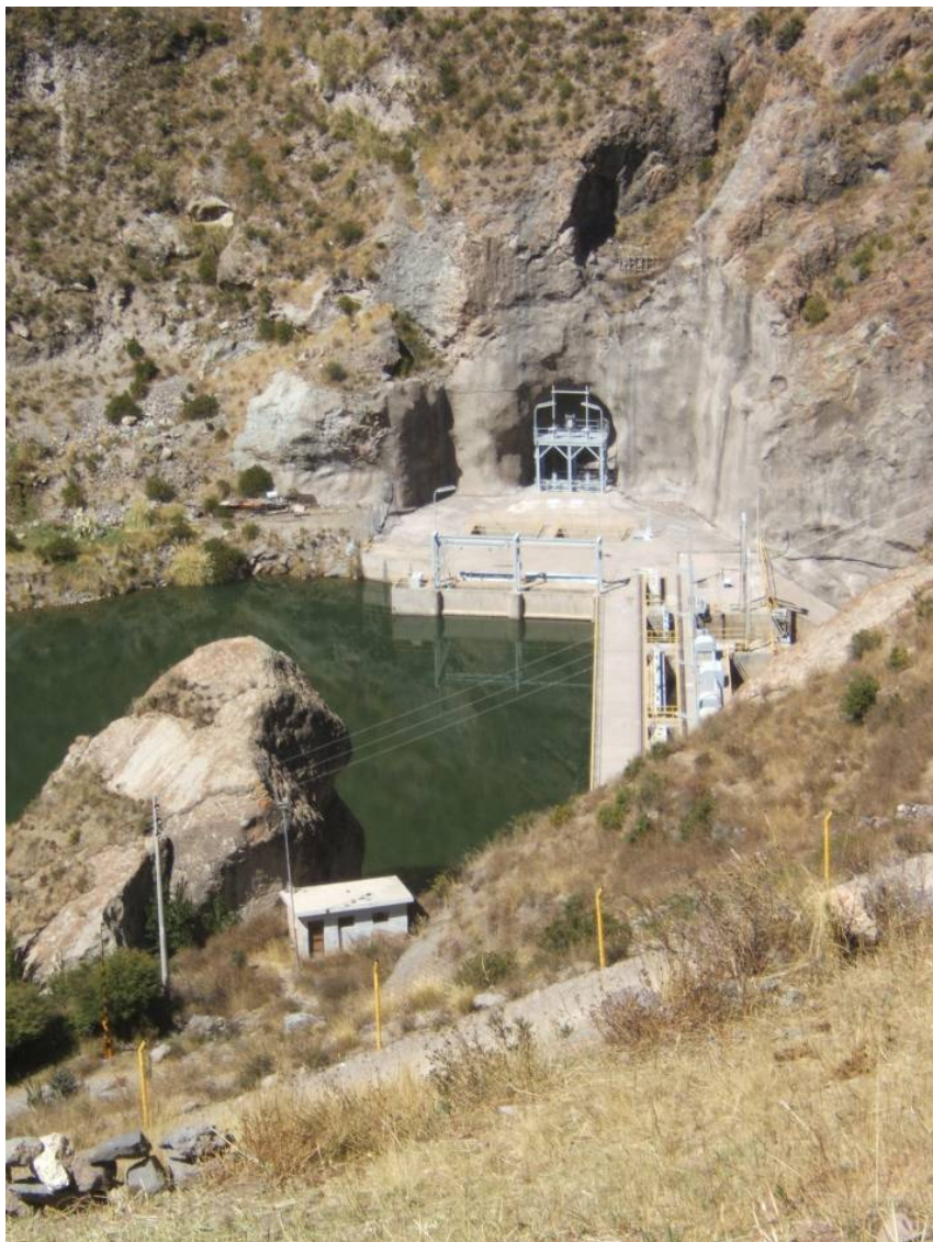
Deslizamiento rotacional que en el año 2005 produjo asentamientos de terrenos que afecto casa de maestranza de la bocatoma de Tuti.
