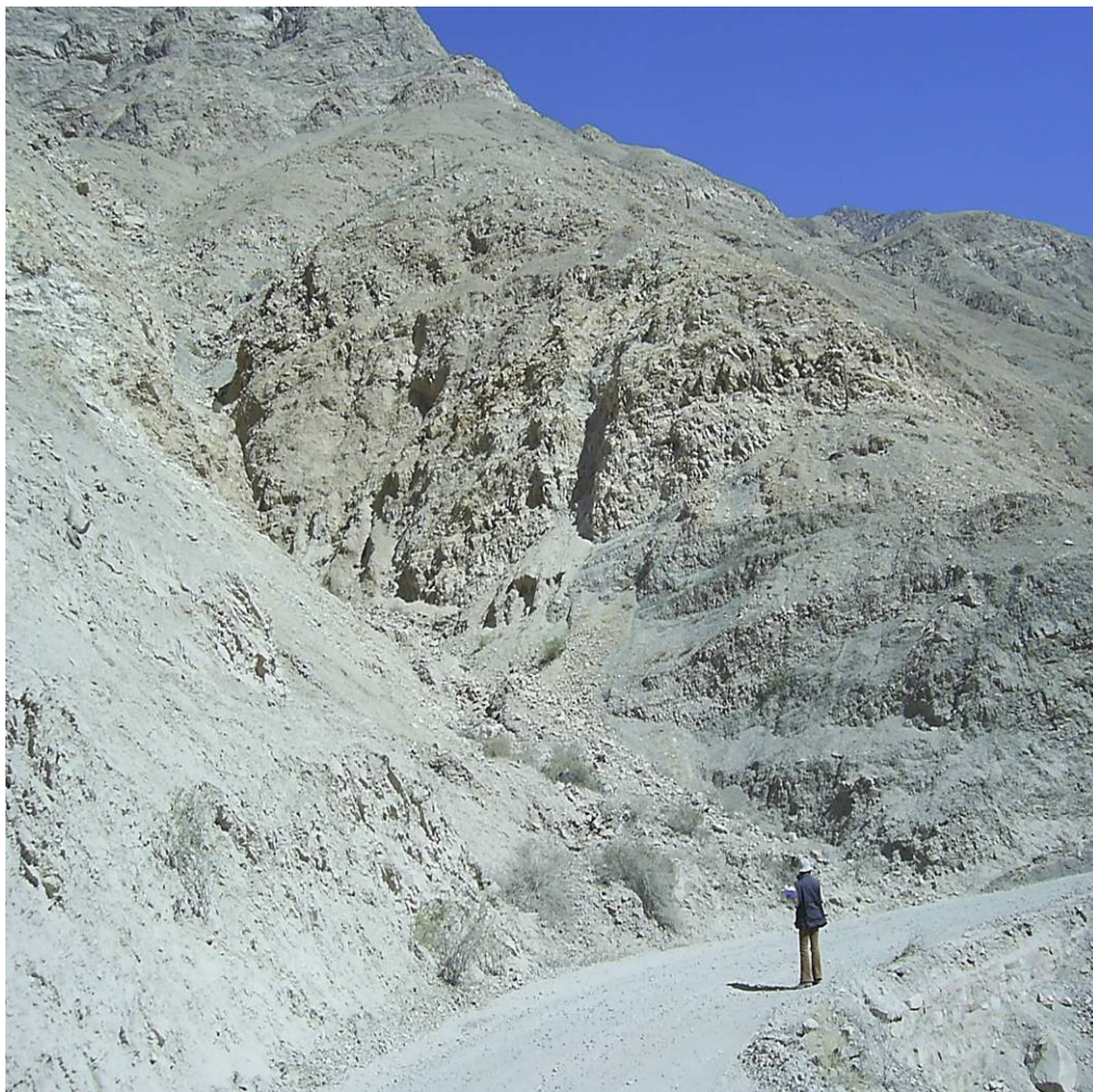
Ladera NE del Cerro Lomas de Mamas donde flujos de detritos, derrumbes y erosión de laderas afectan 5 km. de la carretera Tipan – Viraco.
