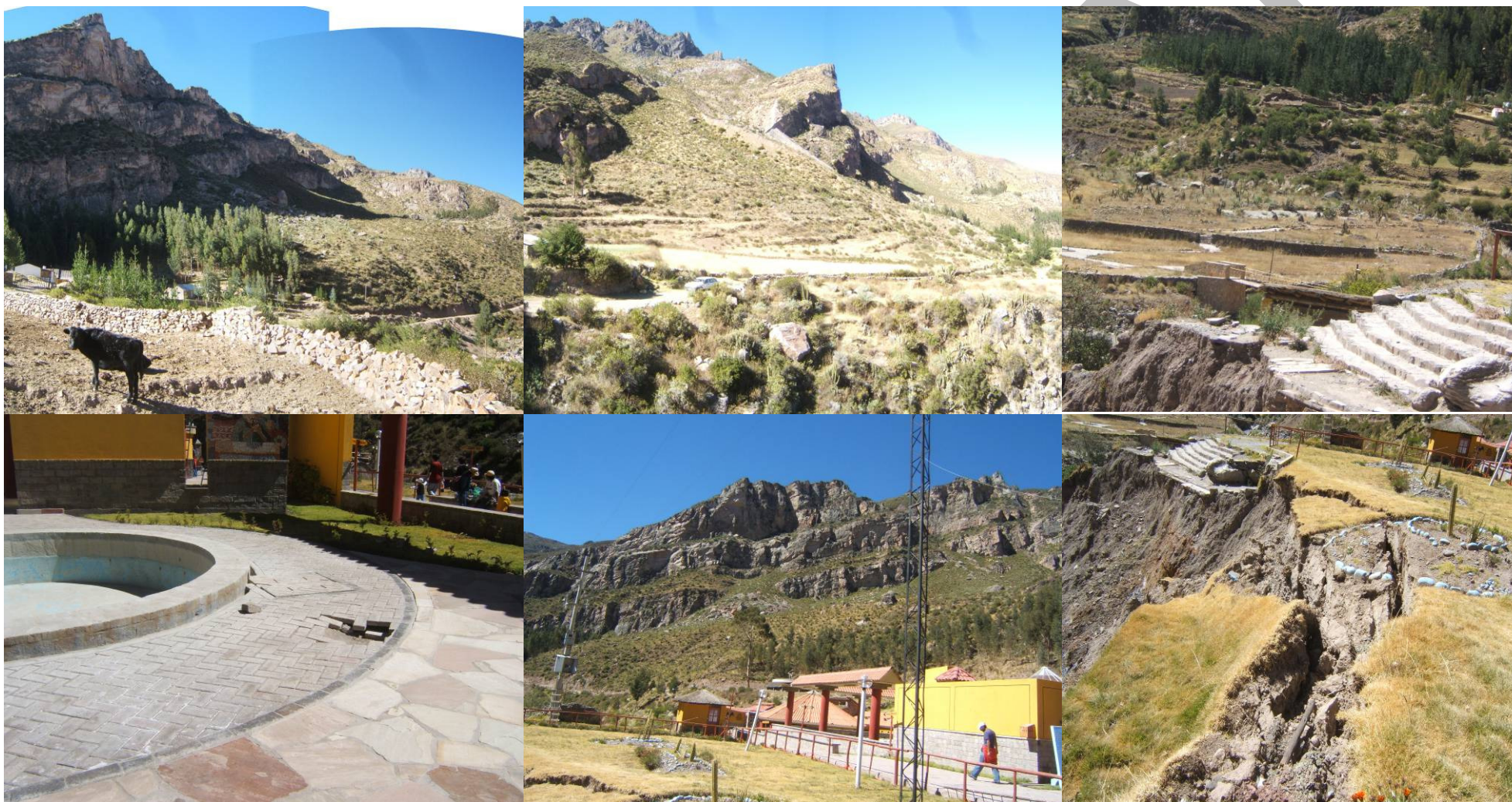
Sector La Calera, Pucaloma y Hospedaje el Bosque del distrito de Chivay que se ven afectadas por deslizamientos, caídas de rocas y flujos que afectan la infraestructura del lugar y a los vehículos que transitan por la zona.
