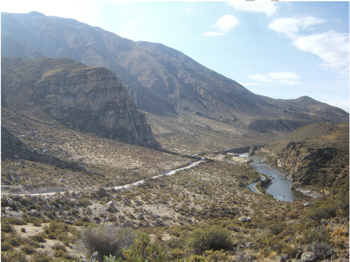
Ladera del cerro Pichihua, susceptible a erosión de laderas y flujos de detritos que comprometen tramo de carretera Orcopampa-Andahua, así como bocatoma y canal de Andahua.
