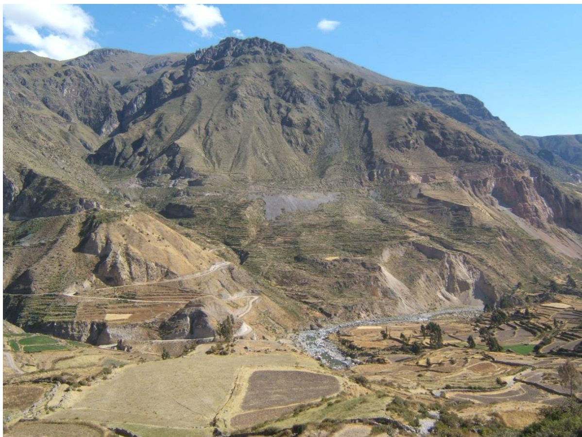
Deslizamientos rotacionales que afectan al distrito de Maca y carretera a Cabanaconde. Deslizamiento de Antahuilque.
