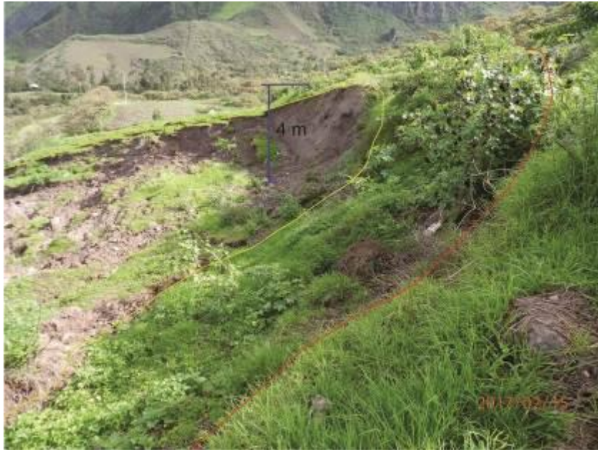
Foto 3. Vista de la parte superior del deslizamiento, se observan Corona (escarpa principal) de 75 m. de longitud, salto vertical de 4 m. donde afecta terrenos de cultivo y pastoreo.
