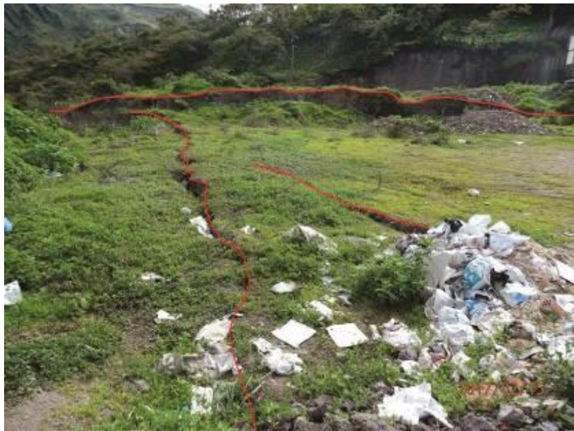
Foto 4. Vista de la parte superior del deslizamiento, se observan agrietamientos con una longitud que varía entre 27 a 74 m.
