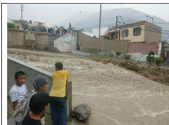
Foto Recorrido del flujo del 02 de enero del 2010 que afectó a viviendas del sector de Collique (tomado de: www.rpp.com.pe ).
