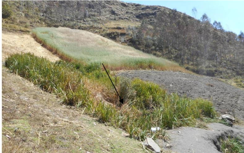
Foto 19: En la parte alta del cerro Cebollita, existen afloramientos de agua, que sobresaturan los sedimentos causando inestabilidad en la ladera.
