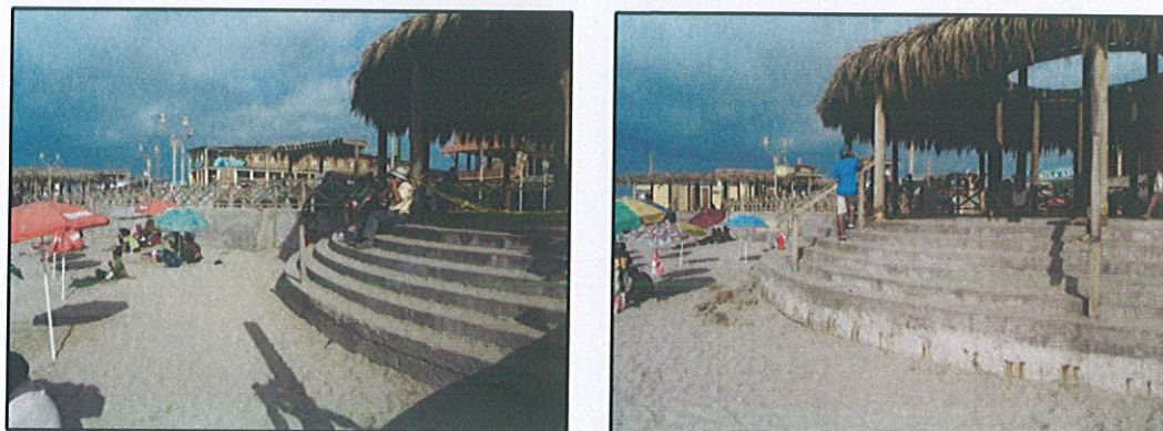
Figura 5.- Vista panorámica del mirador centro que no ha sufrido mayores daños por estar más mejor protegido.
