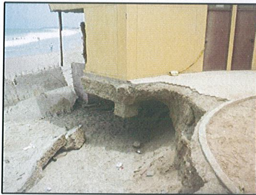
Figura 14.- Vista panorámica de la parte interior del mirador que fue rellena con tierra y arena.
