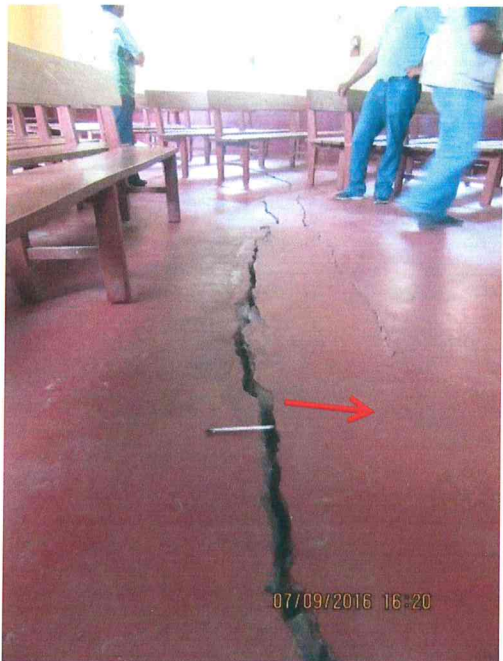
Foto 19. A. Grietas en piso (Apertura: 4 cm, Largo: 15 m). B. Fisuramientos en paredes. (Apertura: 2 cm, Alto: 3 m).
