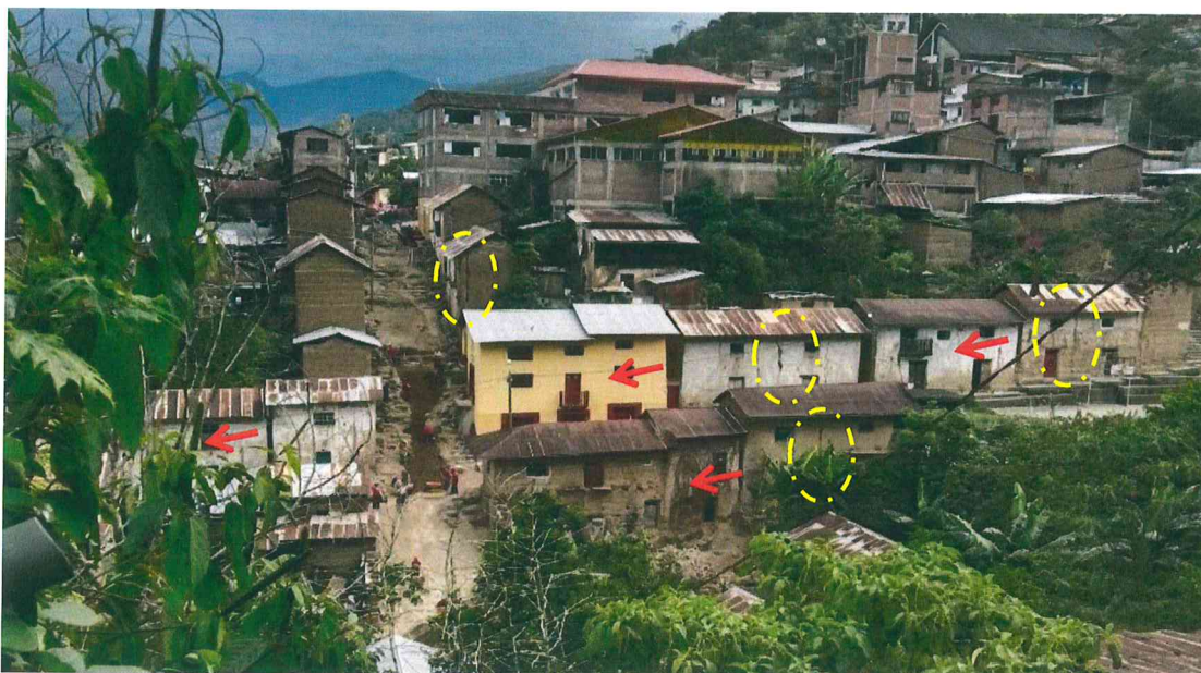
Foto13. Vista panorámica del Barrio Central (Espalda de la Municipalidad). Las flechas indican dirección de movimiento de deslizamiento. Los círculos punteados señalan agrietamientos en muros.
