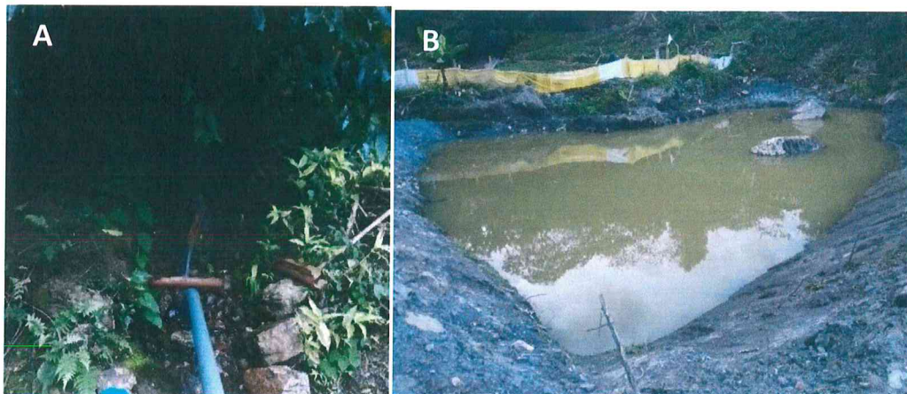
Foto 25. A. Emanaciones de agua subterráneas. (Base del deslizamiento). B. Manantial producto de acumulaciones de aguas subterráneas y de escorrentía. (Margen Izq. Río Tambopata).
