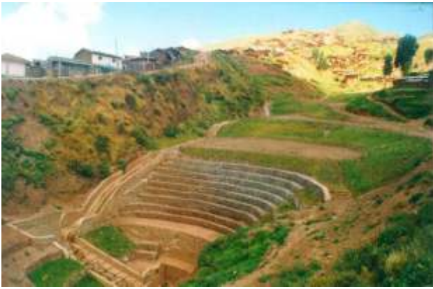
Foto 7. Deslizamiento El Bosque estabilizado.
