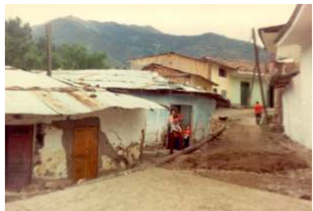
Foto 5. Vista del proceso de reptación de suelo que afecta a las viviendas y calles de Huancabamba.
