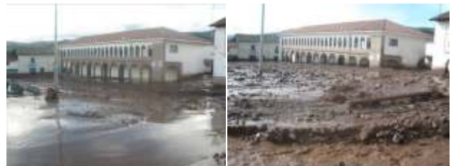
Fotos 5 y 6. Plaza de Armas de Zurite afectada por el aluvión del 28 de enero (foto de izquierda) y el aluvión del 06 de febrero (foto de lado derecho).
