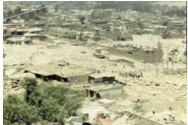
Foto 2: Casas ubicadas en el cono de deyección. Notese que en las zonas pedregosas había muchas casas que fueron destruidas por el huayco.
