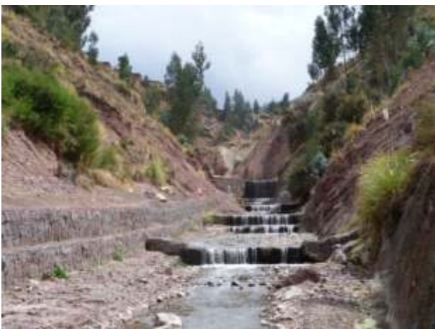
Foto 5. Río Saphy, con obras de prevención en el cauce y márgenes (2012)
