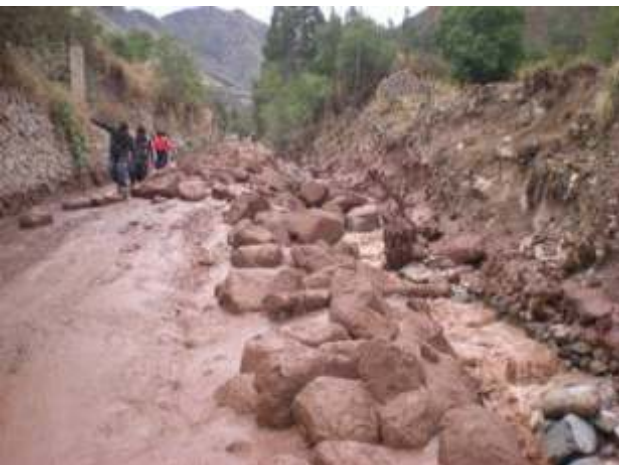
Foto 6. Último sitio de represamiento del aluvión y evidencias del flujo de lodo
