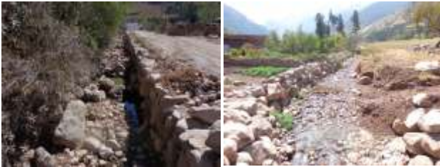
Fotos 8 y 9.- Canal ensanchado a aproximadamente 2m (izquierda), canalización provisional en el poblado de San Isidro, ubicado en la parte alta de la quebrada (derecha)
