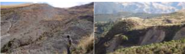
Fotos 9 y 10. Grietas tensionales en deslizamiento en el flanco derecho del deslizamiento principal ubicado en la margen derecha de la quebrada; en la foto de la izquierda se puede observar el deslizamiento que origino el flujo del año 2010, este no presenta reactivaciones ni grietas importantes en su plano de deslizamiento.
