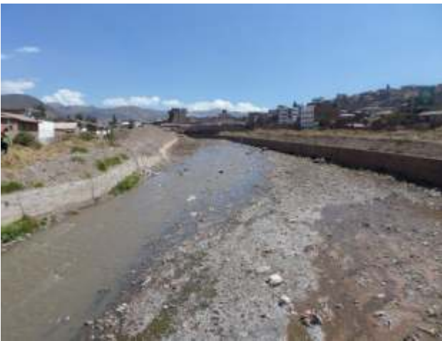
Foto 1. Margen derecha del río Huatanay intervenido en el Proyecto Huatanay (2013).
