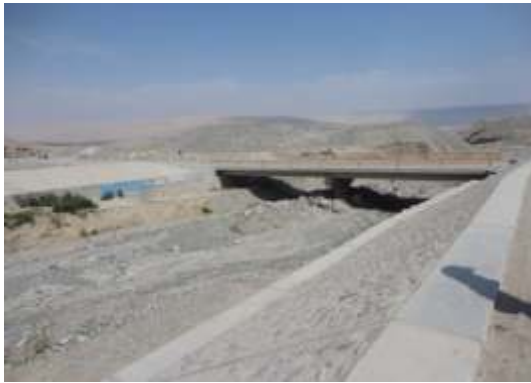
Foto N°02. Vista donde se aprecia el puente de acceso a la zona de canteras
