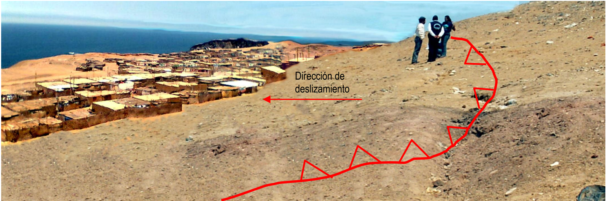
Foto 01. Escarpa principal del deslizamiento. Vista al NO.
