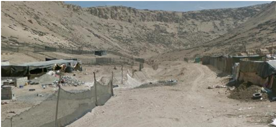
Foto 7. Derrumbe en forma de canchales de detritos en el talud natural en ambas márgenes de la quebrada Río Seco Caramolle.
