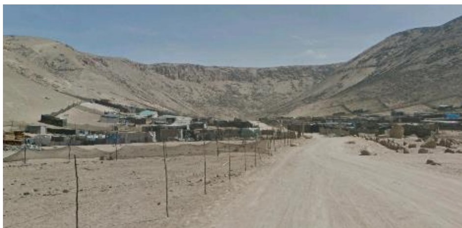
Foto 6. Vista aguas arriba de la quebrada Río Seco Caramolle obstruida por la construcción de viviendas y granjas de cerdo y aves; las vertientes en ambas márgenes de la quebrada presentan depósitos de caída de rocas que aportan material al cauce de la quebrada (tomada del Google Earth).
