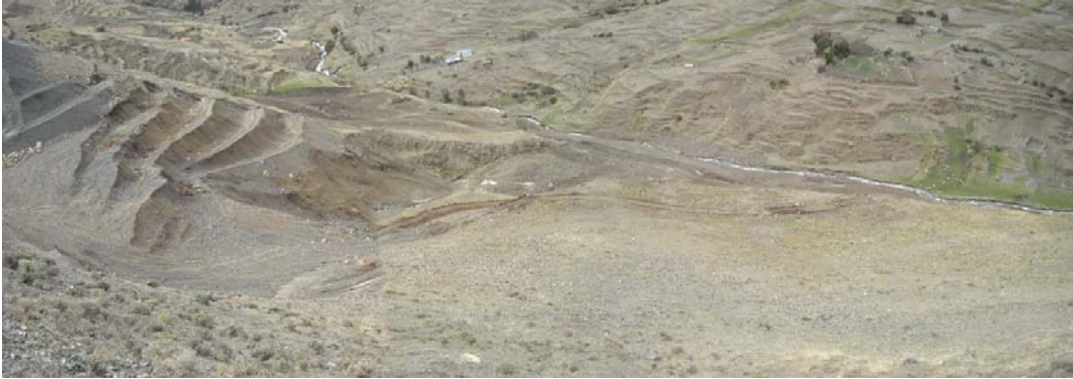
Figura 6: Base del botadero de la carretera Calca-Lares (Km 21), este genera flujos de lodo, ya que el material no tiene obras de contención y un tratamiento.
