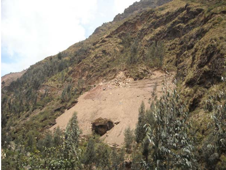
Figura 8: Material excedente del corte de talud arrojado hacia el río Ccochocc, quebrada Totorá
