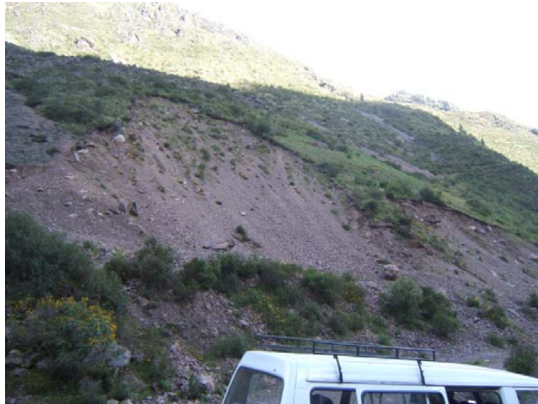
Figura 12: Deslizamientos a partir del corte de talud efectuado con la finalidad de ampliar la carretera Calca – Machacancha – Lares.
