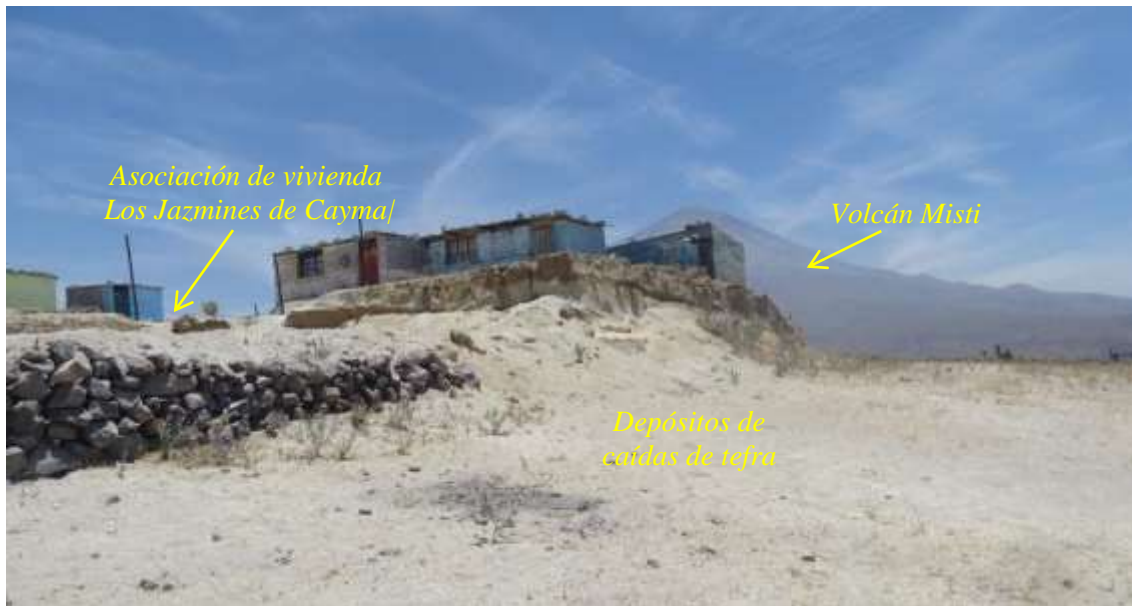
Foto 7. Asociación de Vivienda Los Jazmines de Cayma asentada sobre depósitos de tefra correspondientes a erupciones del volcán Misti.
