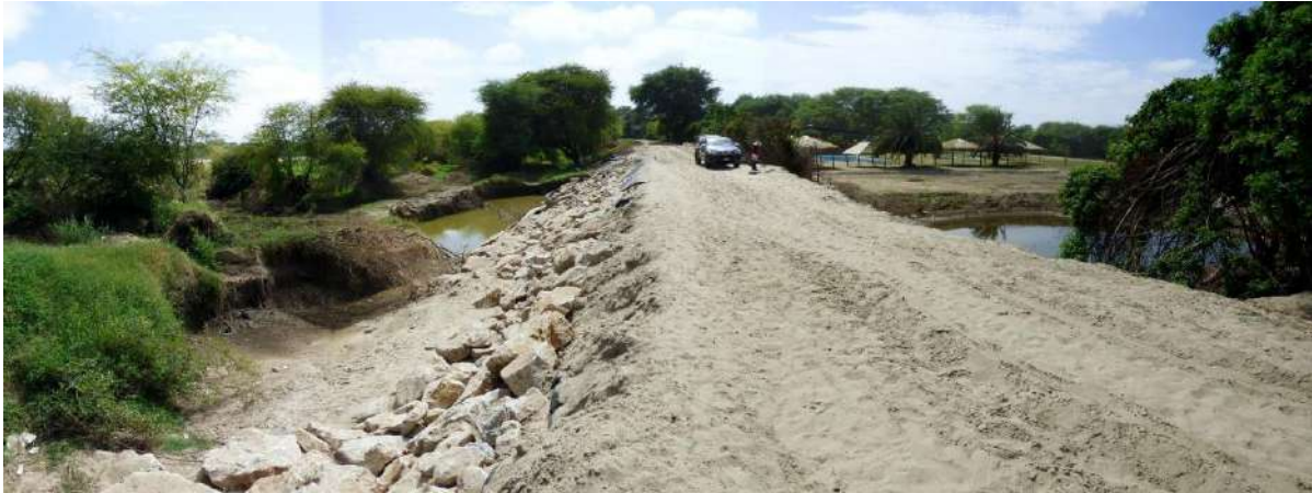
Foto 16: Muro de encauzamiento roto en el Sector El Rancho, que causó las inundaciones en Catacaos y Simbilá; también es posible observar el material fino que colmata el cauce y la vegetación riverena crecida (lado izquierdo de la foto).
