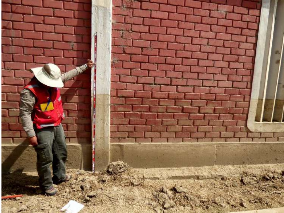
Foto 10: Los niveles del agua desbordada alcanzados dentro de la Universidad de Piura fue de 1,2 m de altura, que dañaron severamente la infraestructura de la institución.
