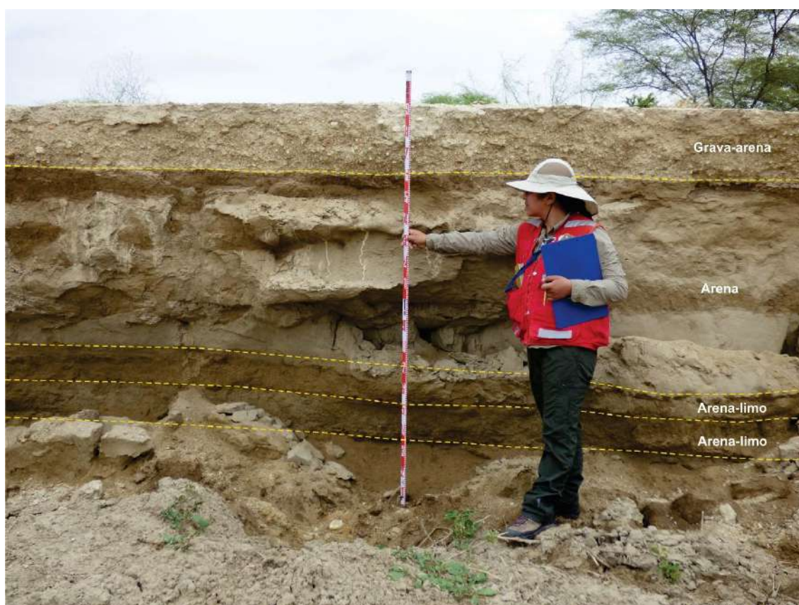
Foto 15: En la imagen es posible observar los niveles superiores del muro de encauzamiento de la margen izquierda del río Piura, conformado principalmente por material fino.
