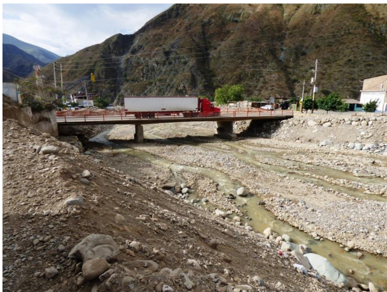
Foto 49. Se observa abundante material aluvial acumulado en las riberas del río que podría obstruir el puente Chilete de 48 metros de longitud.
