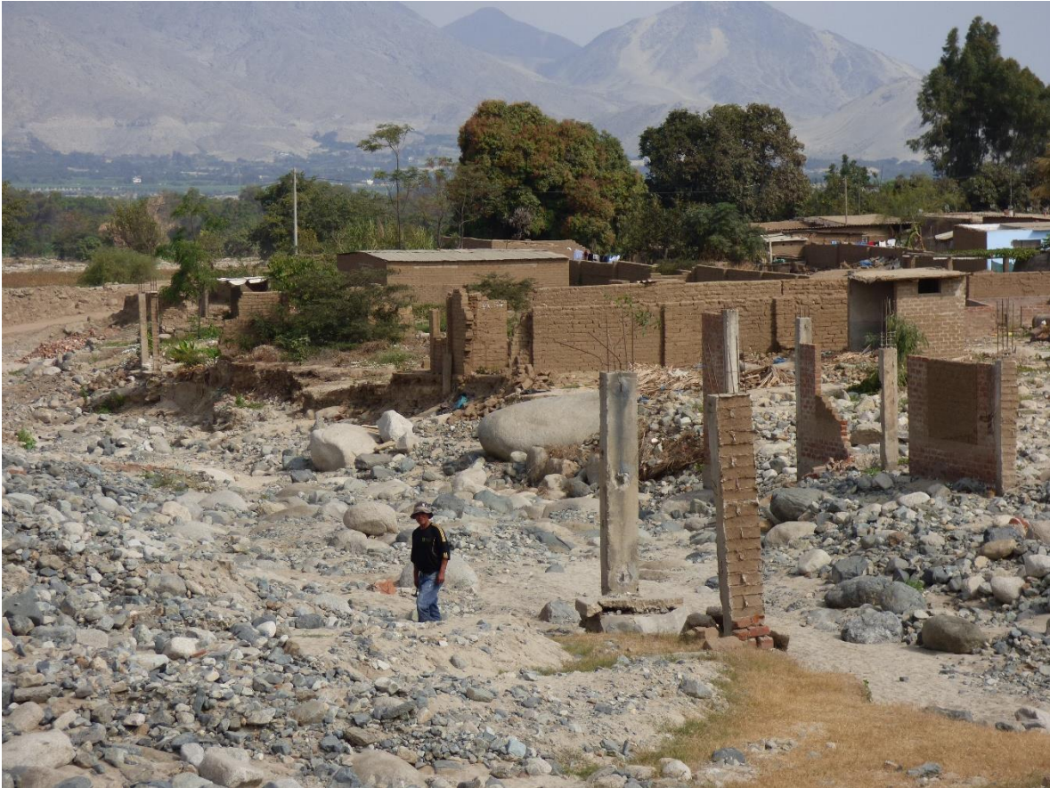
Foto 27. Viviendas destruidas por erosión fluvial, causado por la activación de la quebrada San Carlos en el distrito Laredo, provincia Trujillo, La Libertad.
