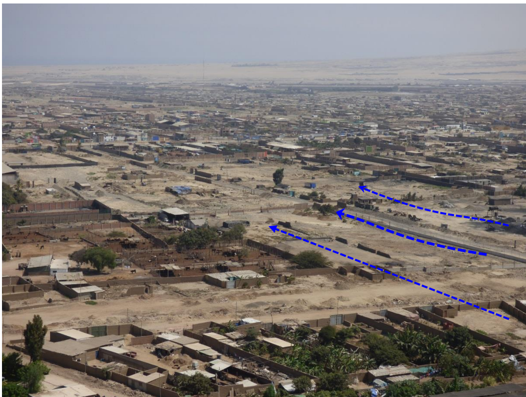
Foto 28. Activación de la quebrada Del León afectó carretera, calles y viviendas en la ciudad de Trujillo; jurisdicción de los distritos Huanchaco y La Esperanza.
