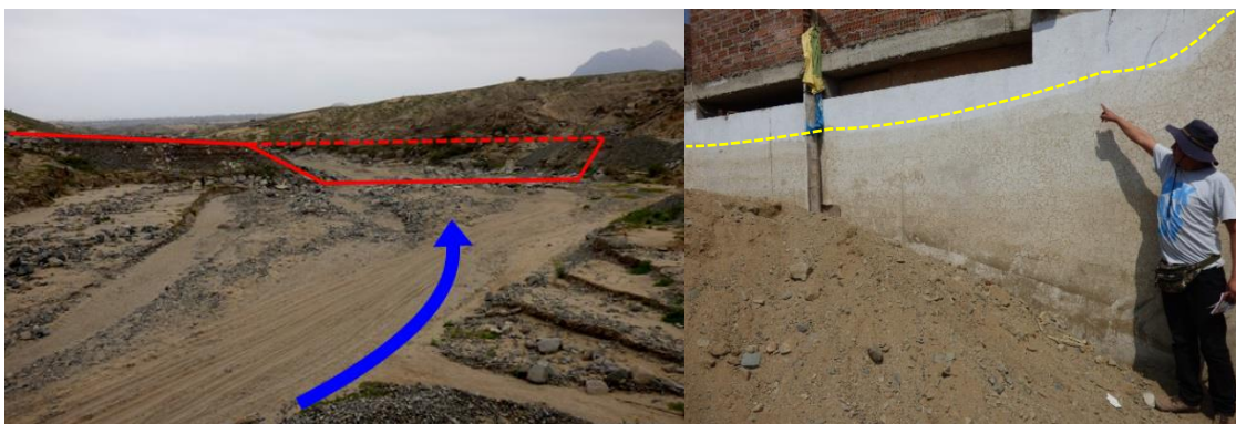
Foto 26. A). Rotura de dique transversal en el cauce de la quebrada San Idelfonso, Trujillo. B). Huellas del nivel de agua alcanzada por inundación en las calles del distrito El Porvenir, en la ciudad de Trujillo.
