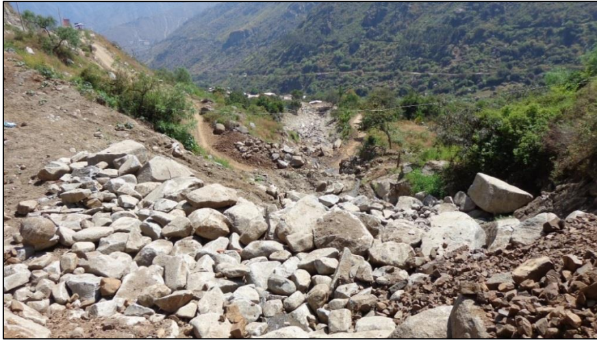
Foto 32. Flujo de detritos con clastos de tamaño variable, desplazados por una quebrada secundaria provocando el bloqueo de carretera y daños en tuberías de filtración de agua. Localidad Paday, distrito Salpo. Vista al NO.
