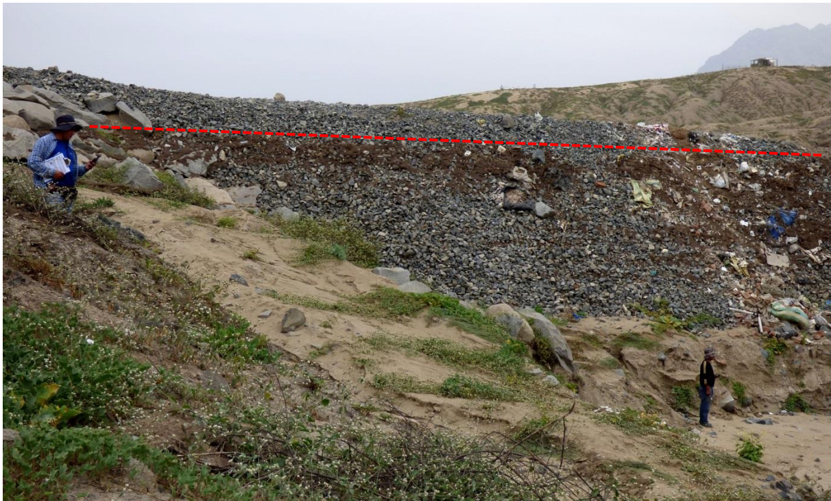
Foto 12. Se muestra rastro del nivel del agua alcanzada (línea discontinua) en el dique transversal ubicado en la margen izquierda del cauce de la quebrada San Idelfonso durante el Niño Costero.
