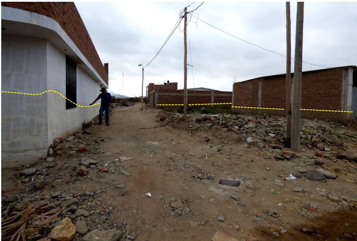
Foto 17. Nivel del agua alcanzada en las calles de El Milagro.
