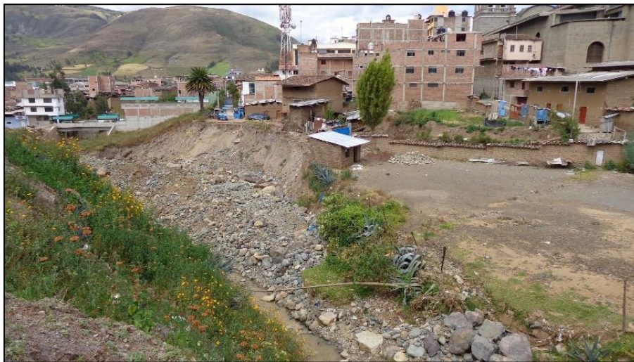
Foto 33. Las precipitaciones pluviales intensas generaron la crecida del río Pollo, provocando la erosión de sus márgenes, afectando a viviendas ubicadas cerca de la margen derecha del río. Otuzco, La Libertad. Vista al SE.
