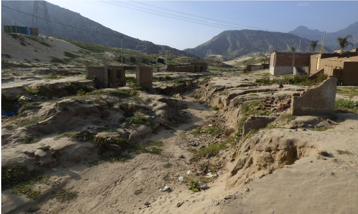
Foto 21. Viviendas destruidas por activación de las torrenteras de arena en el distrito El Porvenir, en la ciudad de Trujillo.
