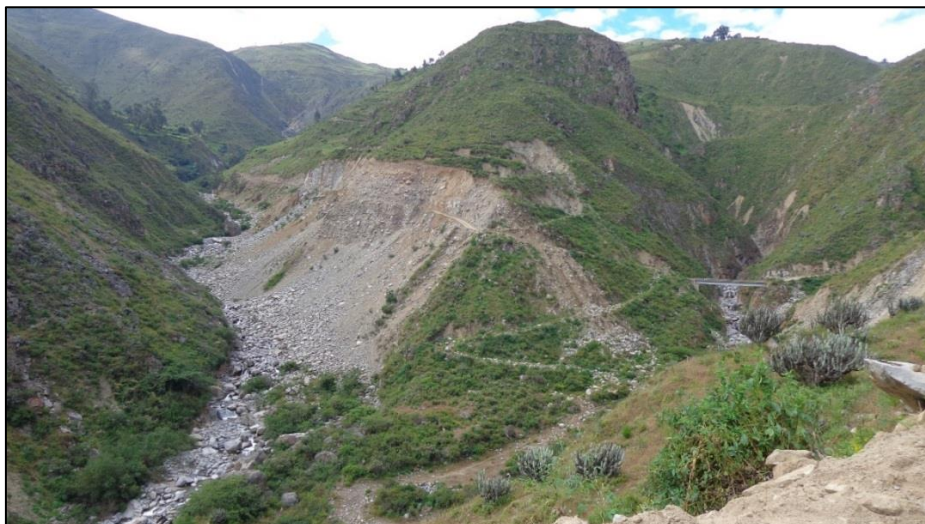
Foto 46. Deslizamiento rotacional, originado por el intenso fracturamiento, meteorización y saturación, ocasionando la destrucción de la carretera y un posible represamiento del río Huaraday. Localidad Guacapungo, distrito Santiago de Chuco. Vista al NE.
