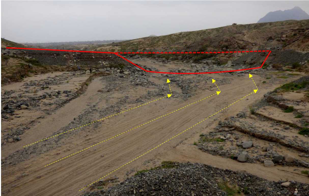
Foto 13. Rotura del dique a causa del desembalse del dique transversal ubicado en el cauce de la quebrada San Idelfonso durante el Niño Costero.
