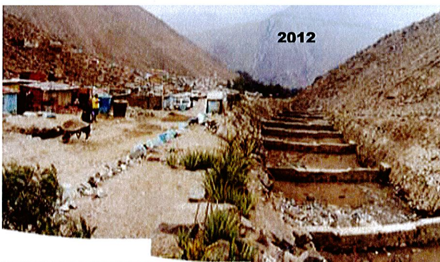
Foto 29. Fotos comparativas del estado de los diques disipadores de energía frente al AA. HH. 9 de Octubre; se aprecia el funcionamiento de ellos y la colmatación paulatina con sedimentos finos y bloques.
