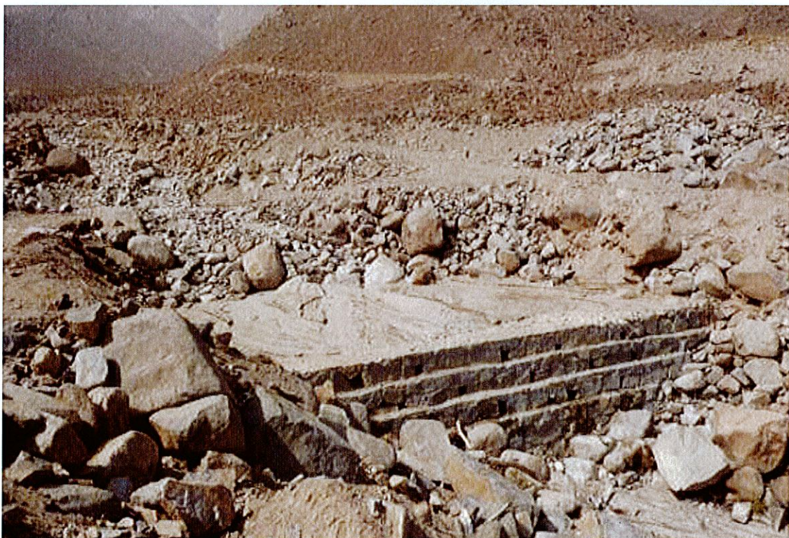
Foto 4. Cauce principal de la quebrada Los Cóndores; dique disipador que muestra material de flujo del 5 de abril, compuesto principalmente de arena. Hacia aguas abajo se distingue tramo encauzado de la quebrada.
