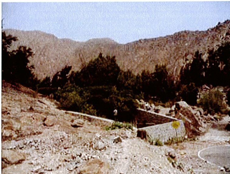
Foto 8. Dique disipador en un tramo del cauce inferior de la quebrada Coricancha construido en mampostería de piedra (11 m largo. x 2, 5 m de altura) relleno
