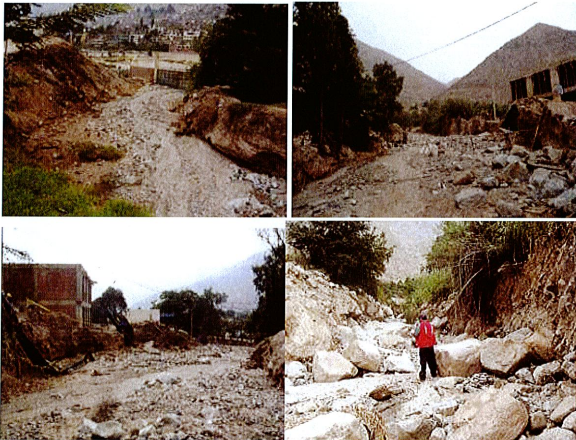
Foto 18. Vistas de la quebrada Santo Domingo que cruza la Universidad la Cantuta; erosión en las márgenes y material de huayco en el cauce de la quebrada.
