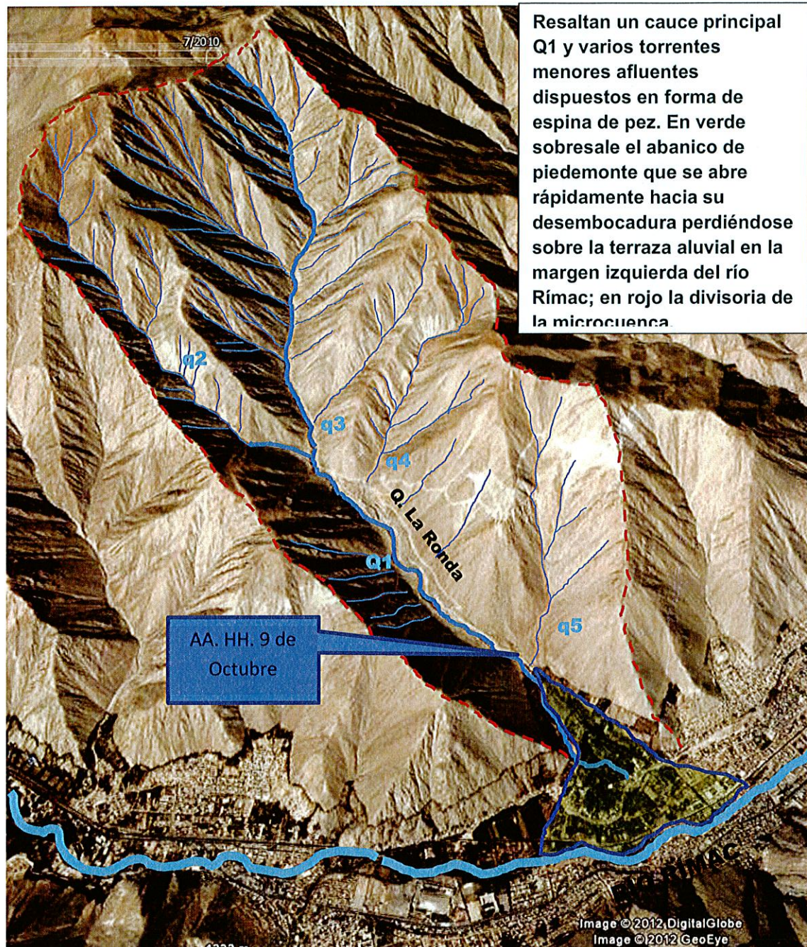
Figura 10. Imagen satelital que muestra la microcuenca de la quebrada La Ronda. Resaltan un cauce principal Q1 y varios torrentes menores afluentes dispuestos en forma de espina de pez. En verde sobresale el abanico de piedemonte que se abre rápidamente hacia su desembocadura perdiéndose sobre la terraza aluvial en la margen izquierda del río Rímac; en rojo la divisoria de la microcuenca.
