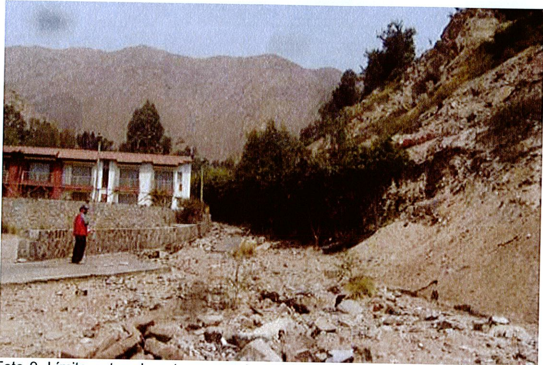
Foto 9. Límite entre el centro recreacional Coricancha y el cauce de la quebrada. Erosión en la pista originada por el paso del flujo de agua y arena del 5 de abril.
