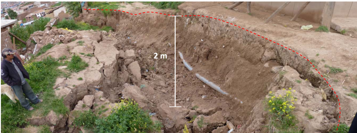
Fig. 3: Vista panorámica de la escarpa del deslizamiento de Santa Rosa.
