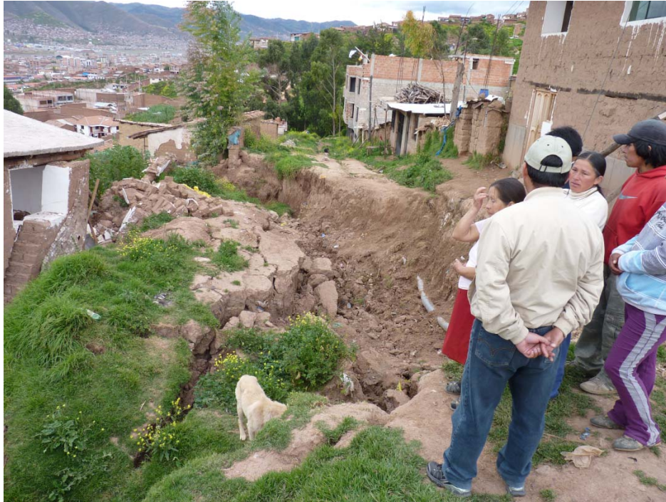
Fig. 4: Vista del deslizamiento. En la esquina superior derecha se aprecia una casa que se encuentra intacta.
