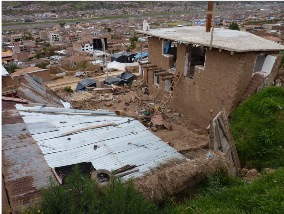
Fig. 6: Viviendas de adobe afectadas por el deslizamiento de Santa Rosa.
