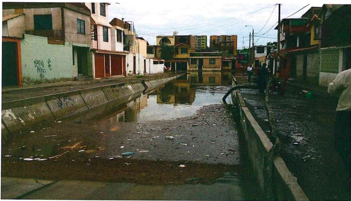
Foto N° 9: Cuenca ciega en la urbanización El Chilcal
