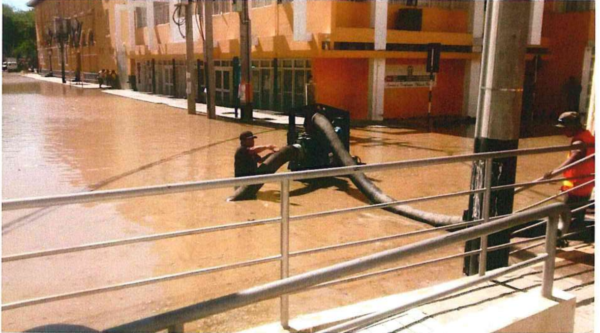
Bomba de agua extrayendo agua en un sector al centro de la ciudad
