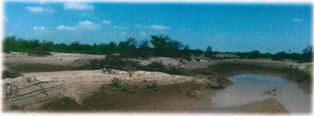
Foto N° 11, 12, 13: Retorno de Rio Motupe a cauce antiguo, por colapso de Dique
