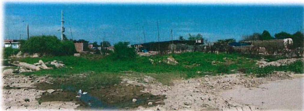
Foto N° 14, 15, 16: Rio Motupe inunda cauce antiguo, afectando zona urbana de Jayanca
