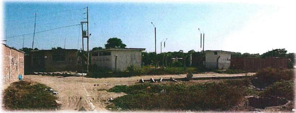
Foto N° 17, 18, 19: Zona urbana baja de Jayanca afectada por inundación de Río Motupe
