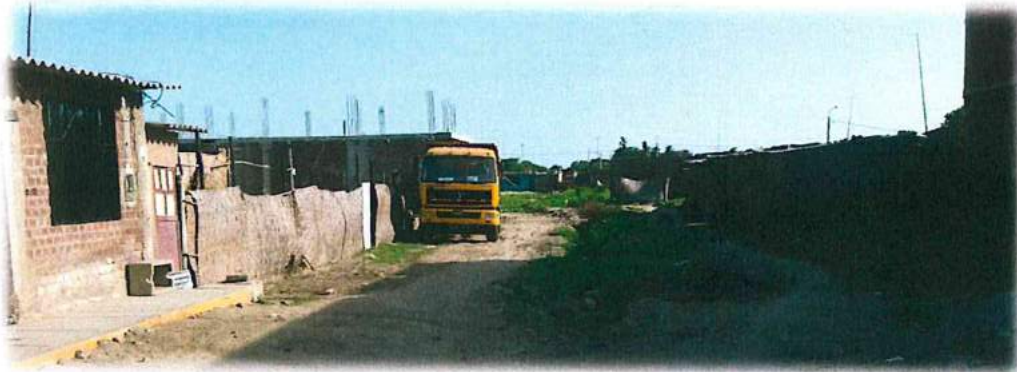
Foto N° 5, 6, 7: Vías sin pistas, ni drenaje pluvial
