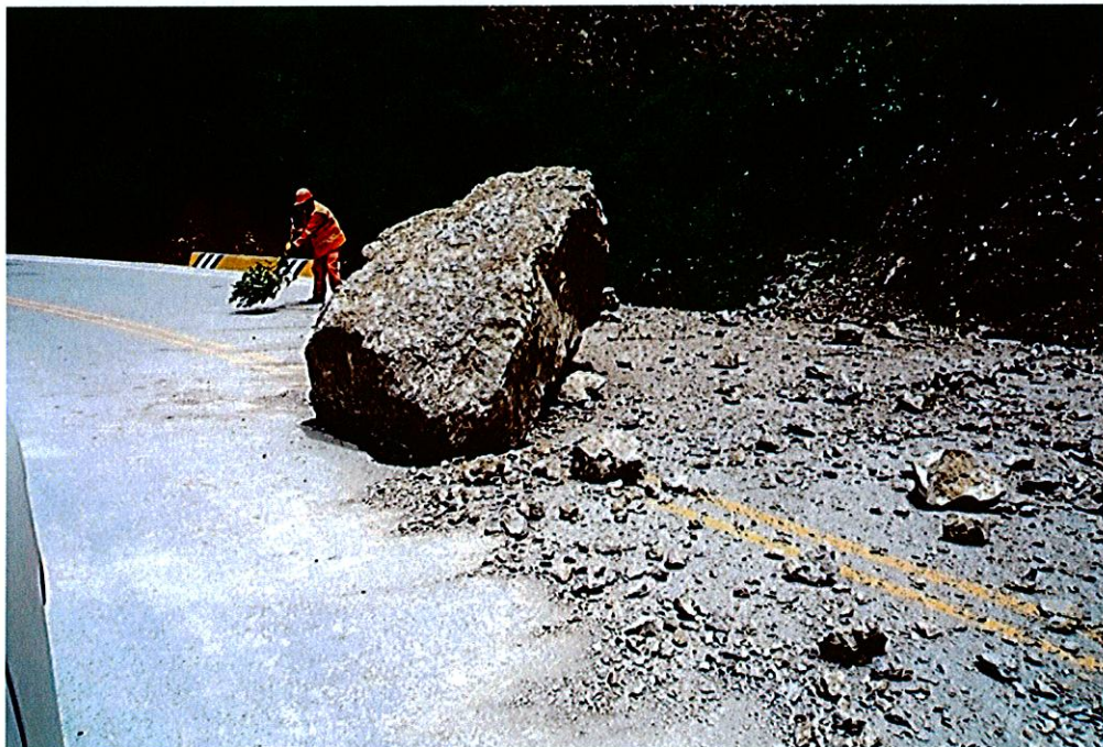
Foto 8: Bloque de roca caído de más de 2 m de longitud, que se incrusto en la plataforma de carretera, se produjo la última semana de enero del 2010.
