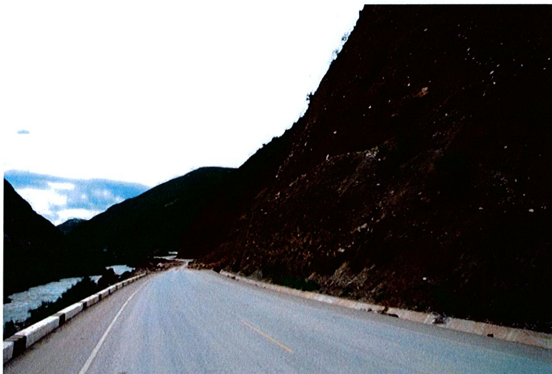
Foto 4: Depósitos coluviales, conformado por mezclas de gravas, arenas y limos.
